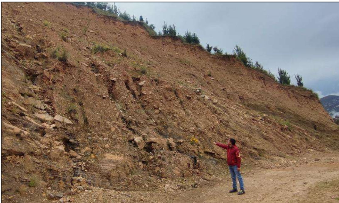
Gráfico 14: Grietas e inestabilidad de talud en carretera a Illahuasi
