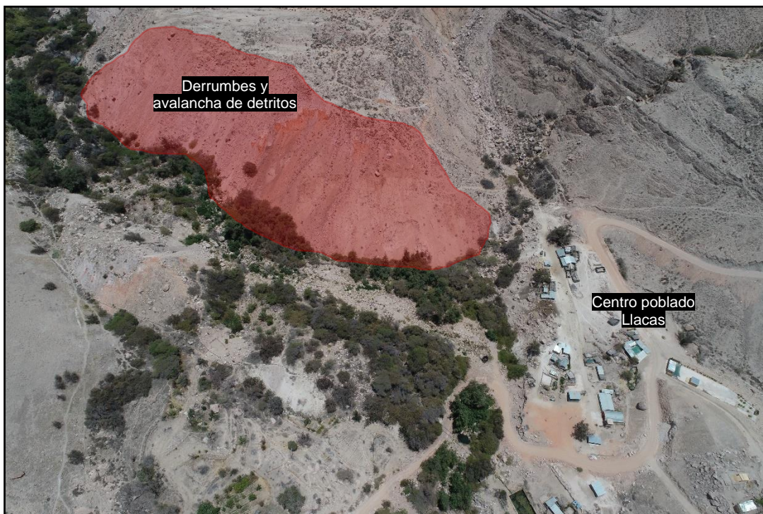
Figura 6. Derrumbes en el sector Llacas
