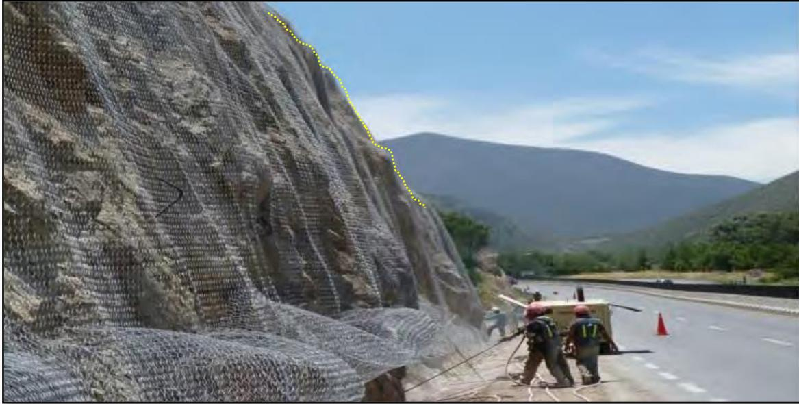
**Figura 37.** Mallas de protección con anclajes para caída de rocas o derrumbes tanto en detritos como roca alterada, (Vilchez, 2021)
