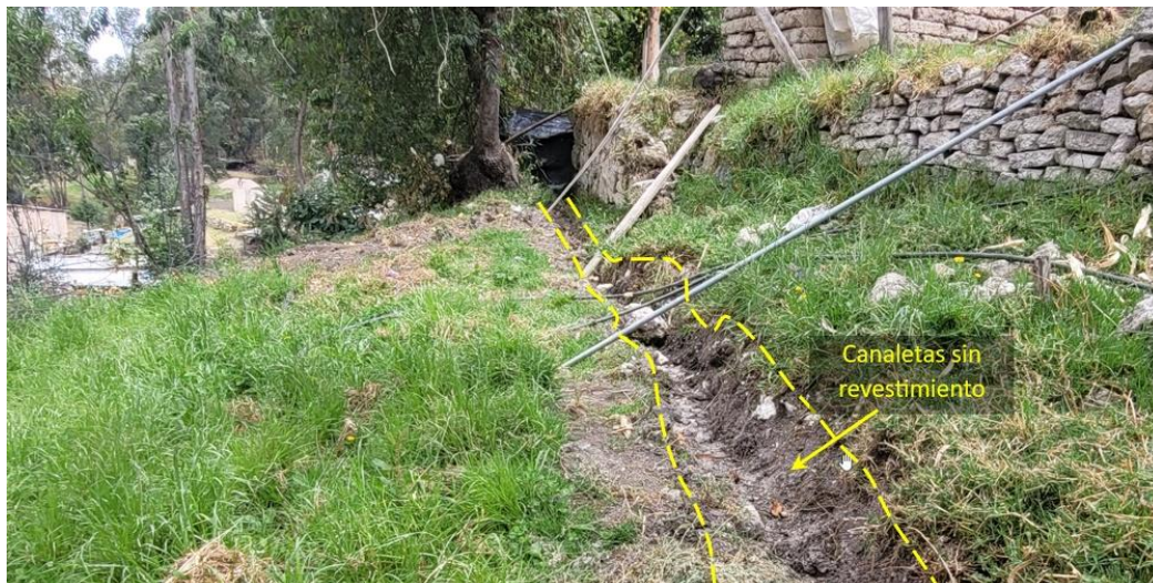
Figura 11. Canales de riego sin revestimiento Coordenadas: E: 781761, N: 9212133.
