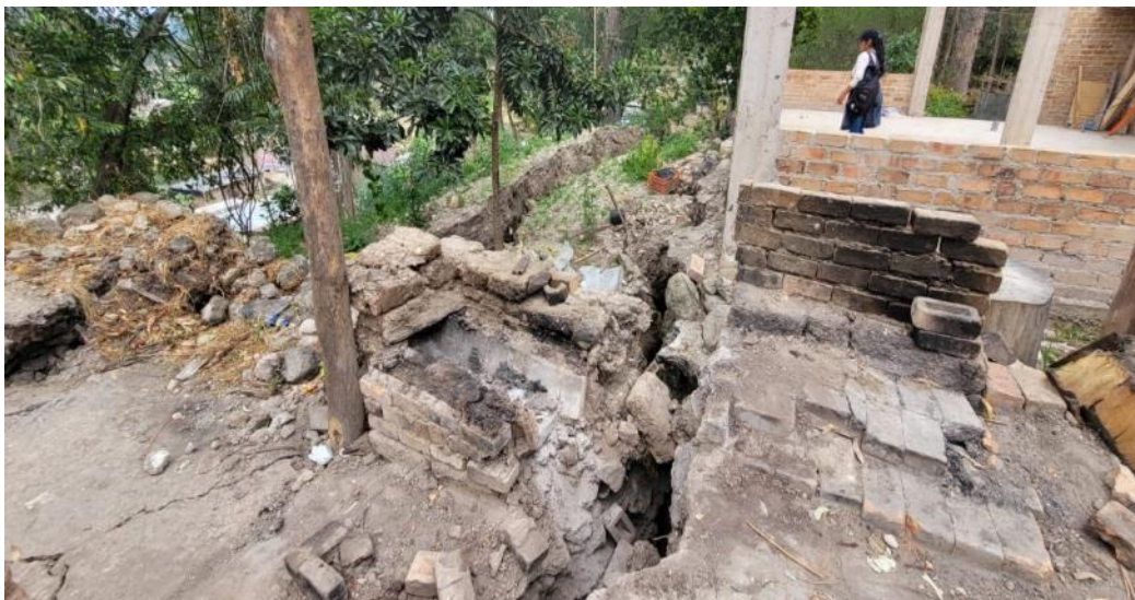
Figura 13. Vivienda afectada por el escarpe principal, en la parte alta del deslizamiento. Coordenadas: E: 781751, N: 9212142.
