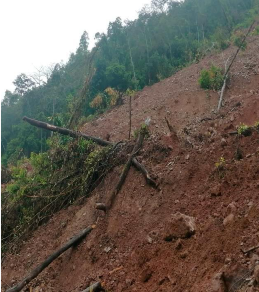
Fotografía 1. Escarpa de deslizamiento registrado el 22 de febrero del 2022 (fuente: Informe de emergencia N° 254 - 6/3/2022 / COEN - INDECI)
