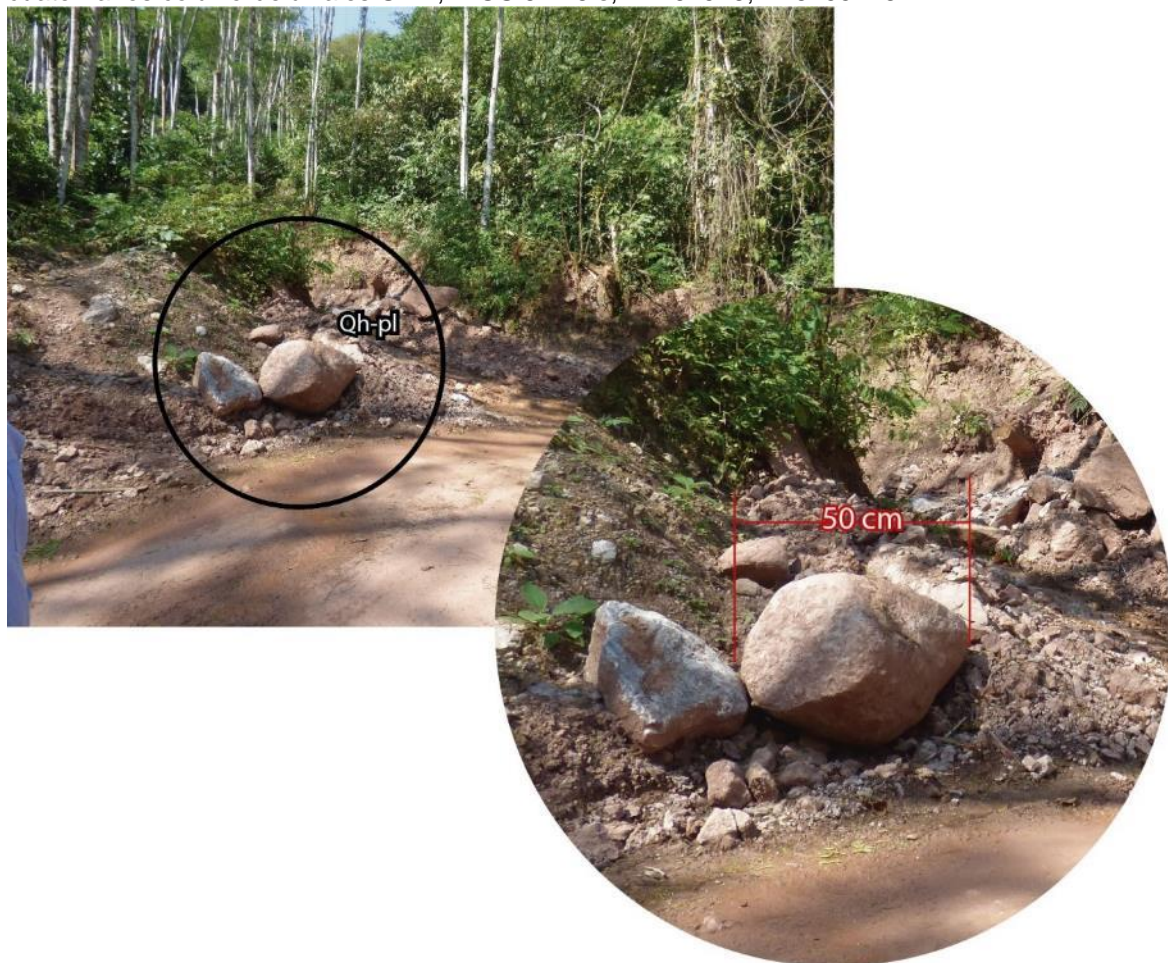
Figura 7. Depósitos proluviales en quebradas de la ladera este del cerro 1. acumulado en la carretera de acceso al sector de Unión Mantus.
