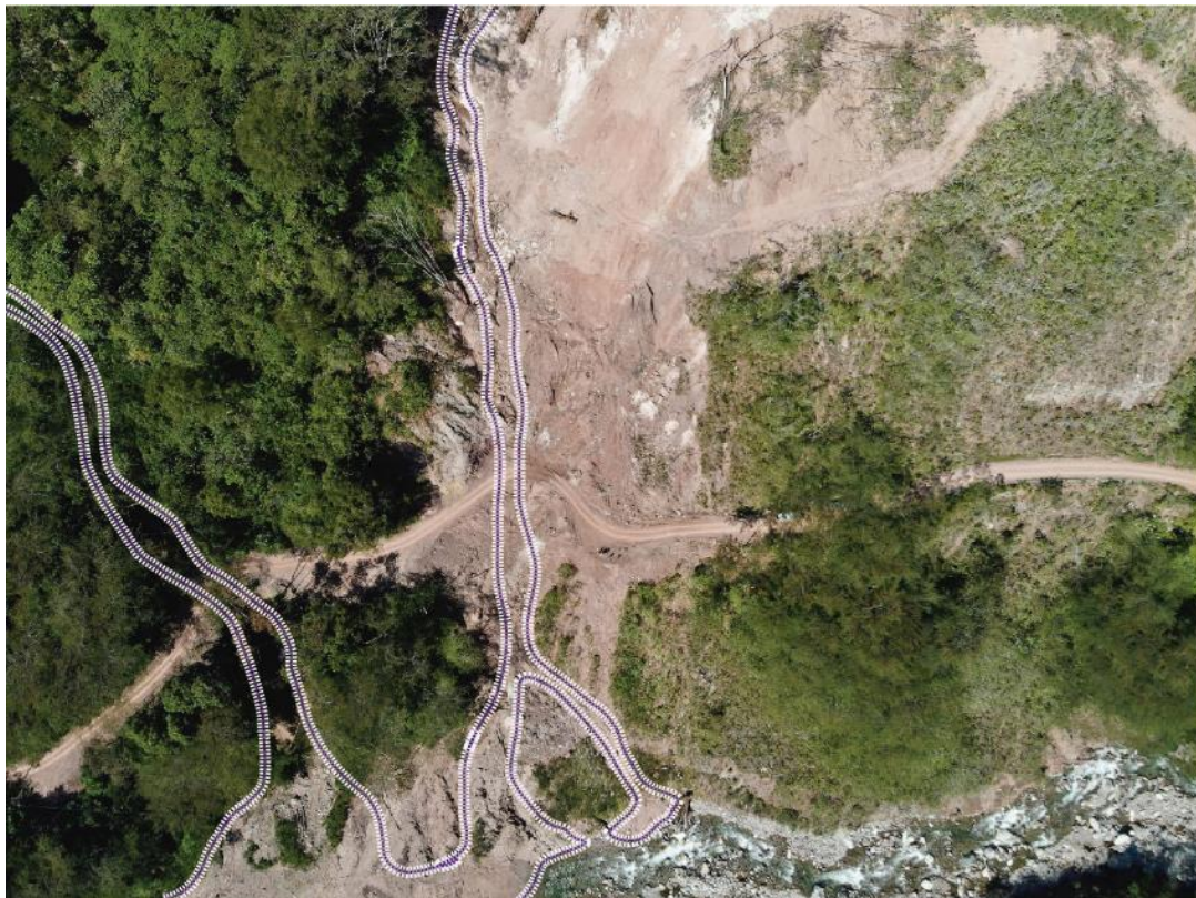
Figura 21. Recorrido de flujo de detritos en las quebradas 1 y 2 que descienden al río Anaymayo.
