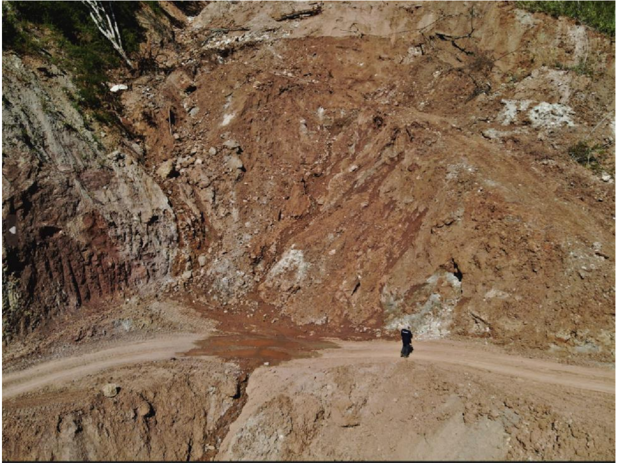
Fotografía 4. Vista aérea (agosto 2023) tomada con drone del deslizamiento D3
