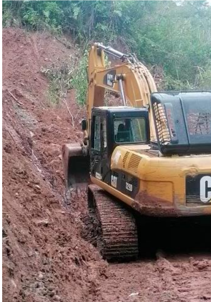
Fotografía 3. Trabajos de limpieza de la vía obstruida el 22 de febrero del 2022 (fuente: Informe de emergencia N° 254 - 6/3/2022 / COEN - INDECI)
