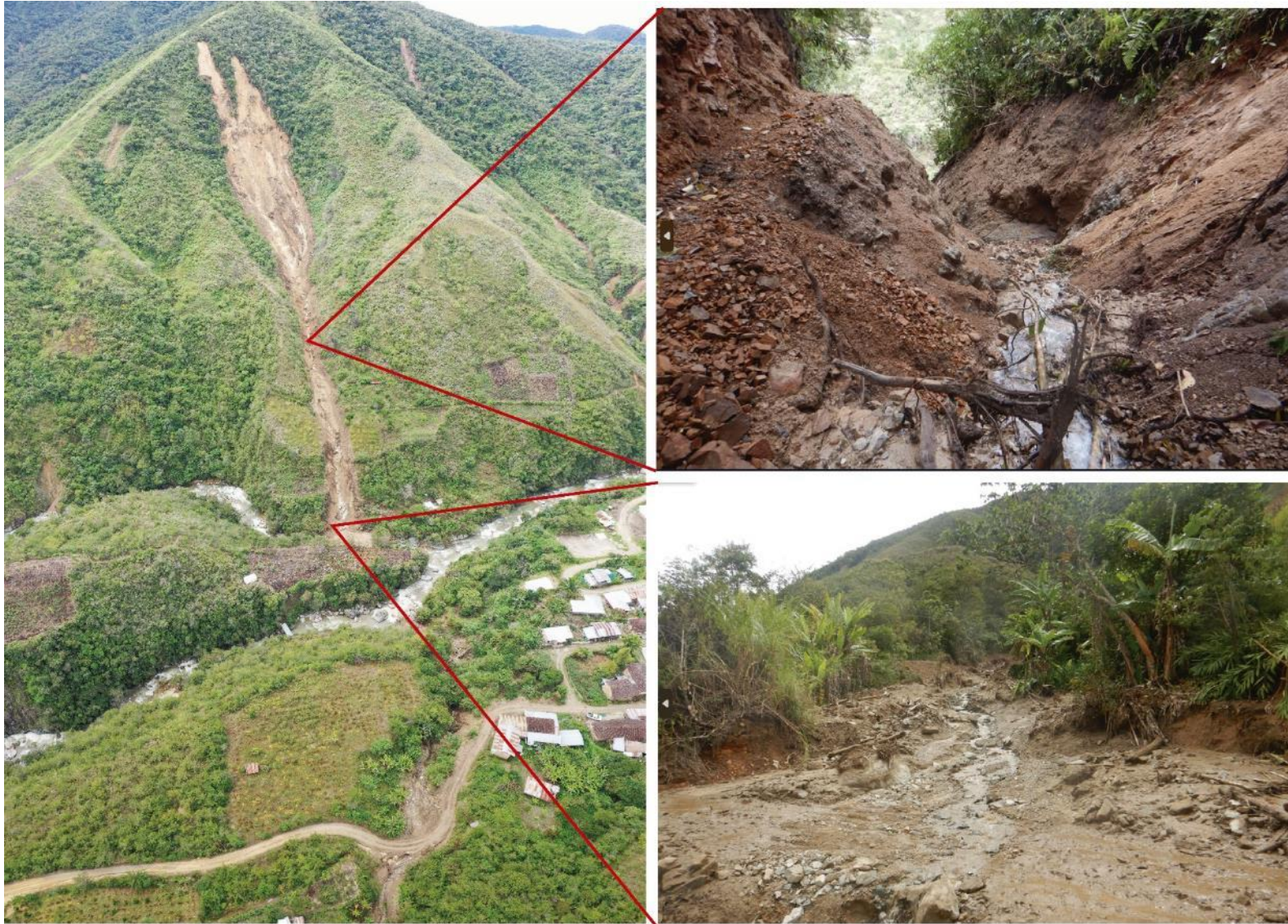
Figura 31. Flujo de detritos (Fr-11) desencadenado en la quebrada S/N 3 .
