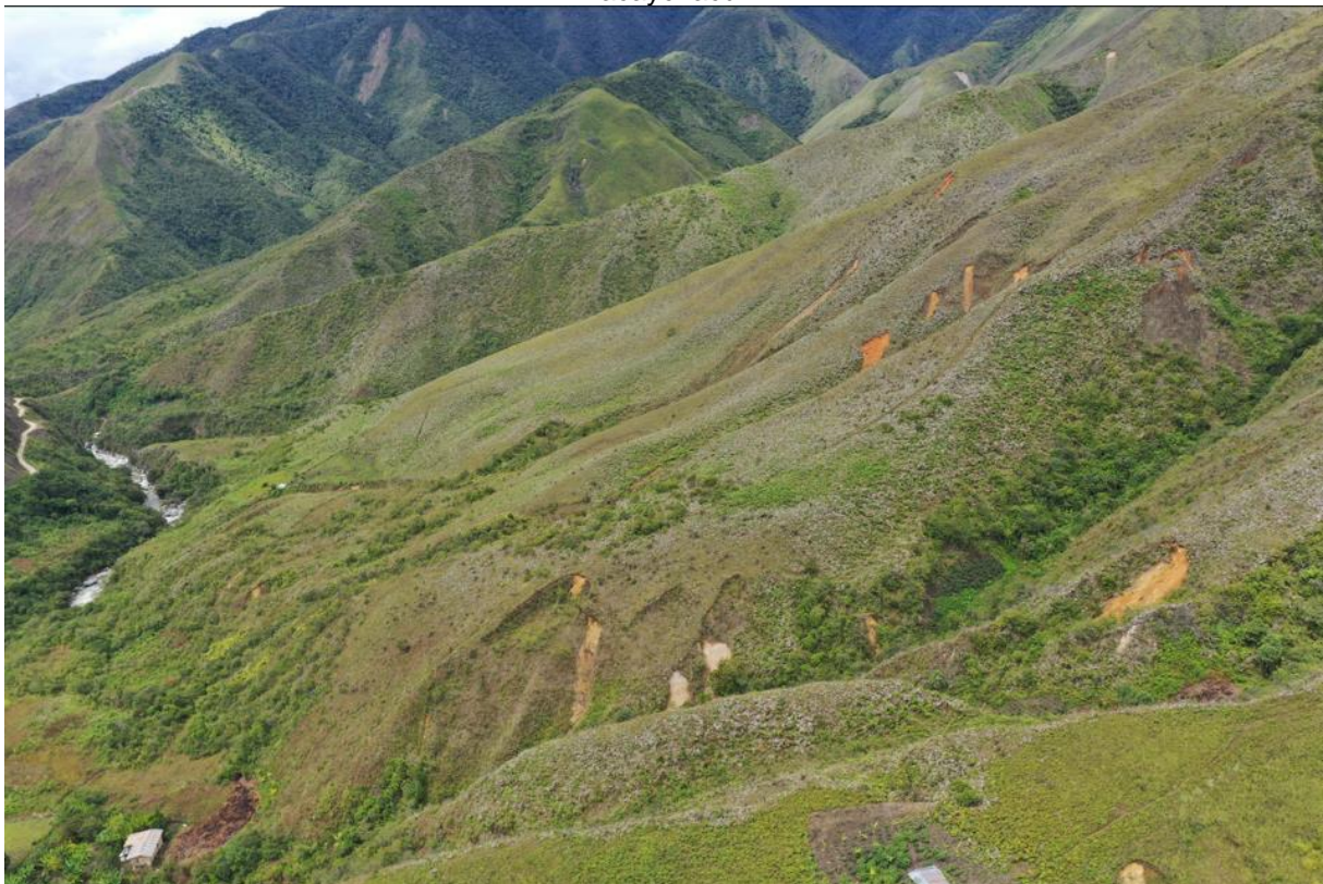
fotografía 3. Flujo de detritos desencadenados en la margen derecha del río Pacaychacu, aguas abajo del caserío Uctubamba.
