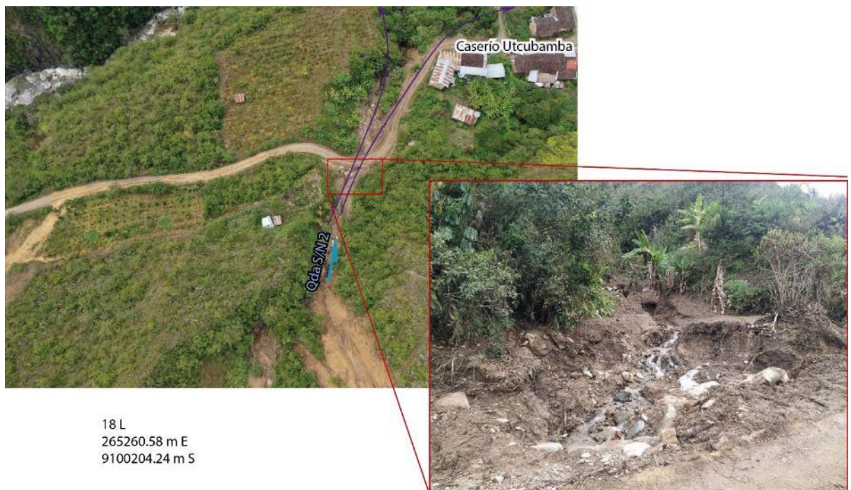
Figura 32. Flujo de detritos (Fr-5) desencadenado en la quebrada S/N 1 .
