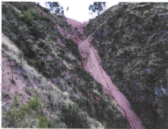
Flujo de Detritos: Flujos de lodos en el sector de Huancaro del distrito de Santiago.
