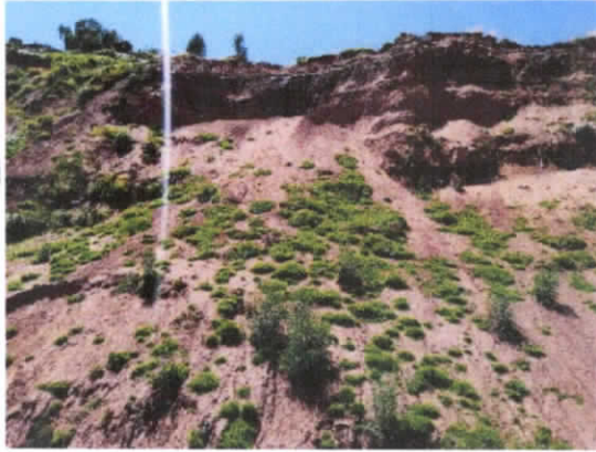
Deslizamientos: Deslizamiento y derrumbes en el sector de Arahuay del distrito de Santiago.
