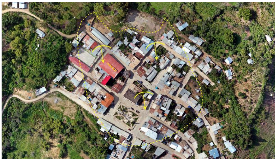
Figura 10. Vista del cuerpo de reptación, donde se aprecia el área urbana afectada por el movimiento.
