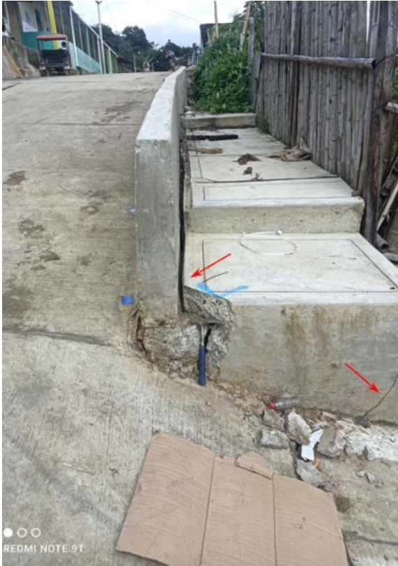
Figura 15. Afectación en veredas Localidad San Felipe.
