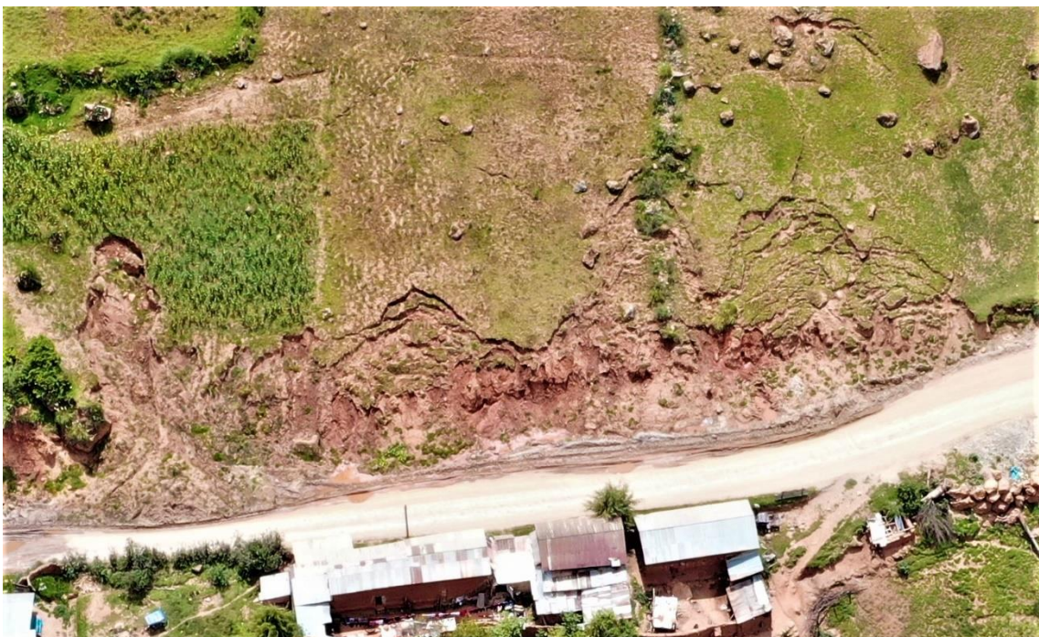
Fotografía 14. Vista frontal de los deslizamientos activos en el sector "C", talud superior de la carretera La Unión – Huánuco Coordenadas UTM: 303906 / 8921769, Zona 18
