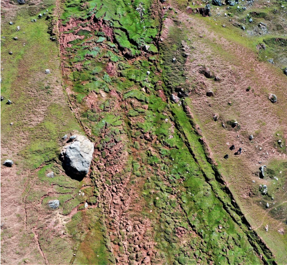
Fotografía 12. Vista del cuerpo central del deslizamiento en el sector "A", se muestran los agrietamientos del terreno Coordenadas UTM: 303529 / 8922558, Zona 18.
