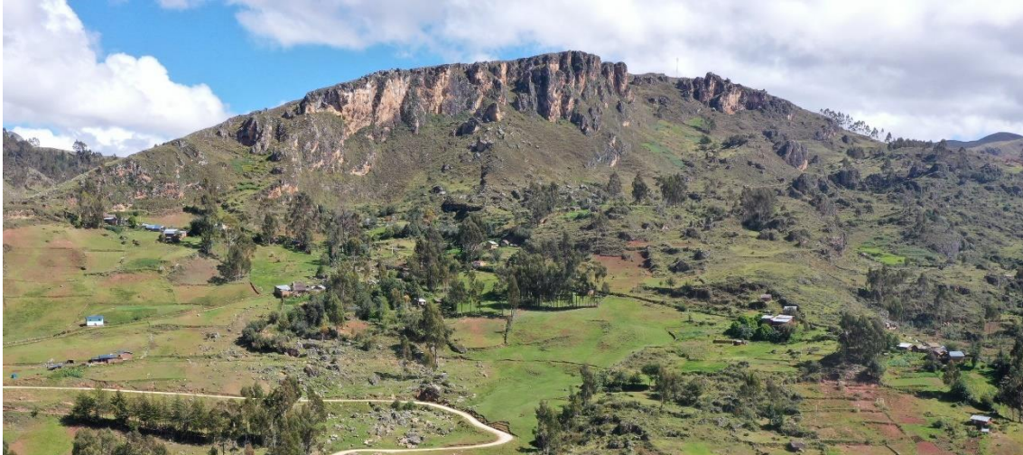
Fotografía 4. Macizo rocoso de los grupos Mitu y Pucara ubicados en la cabecera del área de evaluación, sector Huanac Coordenadas UTM: 303285 / 8922854, Zona 18.
