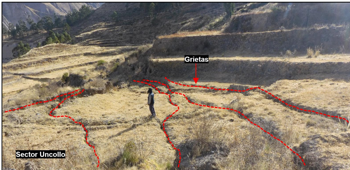
Figura 9. Sector Uncollo, Presencia de grietas en el terreno.
