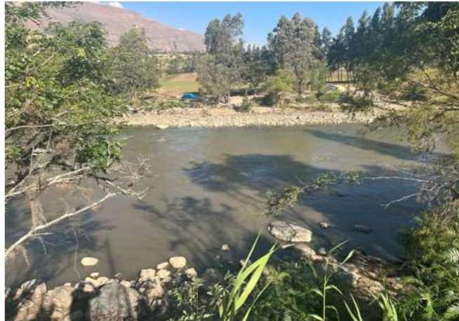
AL FINAL DEL TRAMO DEL RIO HUALLAGA, SE OBSERVA COLMATACION DE MATERIAL DE ACARREO, COMO ARENA GRUESA, FINA, PIEDRA Y ROCA
