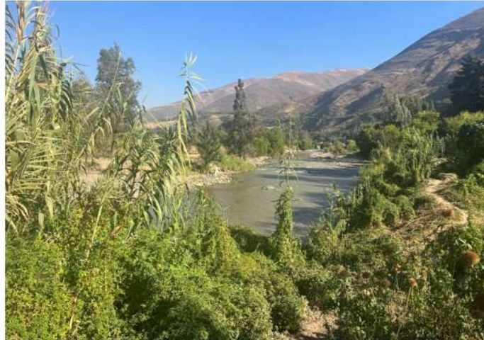
AL CENTRO DEL TRAMO DEL RIO HUALLAGA, SE OBSERVA COLMATACION DE MATERIAL DE ACARREO, COMO ARENA GRUESA, FINA, PIEDRA Y ROCA Y UN CANAL DE RIEGO RUSTICO EN LA MARGEN IZQUIERDA.
