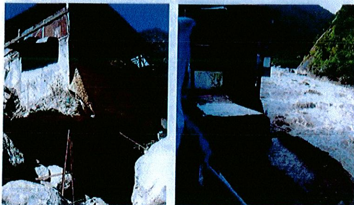
Foto 12: Viviendas destruidas por la erosión del río Vilcanota, luego del incremento de las precipitaciones pluviales y el posterior aumento del caudal (Delgado 2010).
