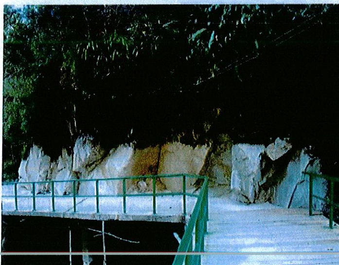
Foto 7: Afloramiento del macizo granítico en el puente de ingreso a los baños termales, se observa en líneas rojas los planos de diaclasamiento.
