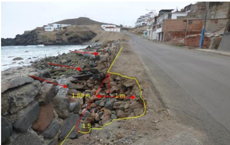
**Figura 21.** Playa Sur, se observa erosión marina, cuyo proceso, influenciado por el oleaje, ha generado desgaste, socavación y afectación del muro de contención.
