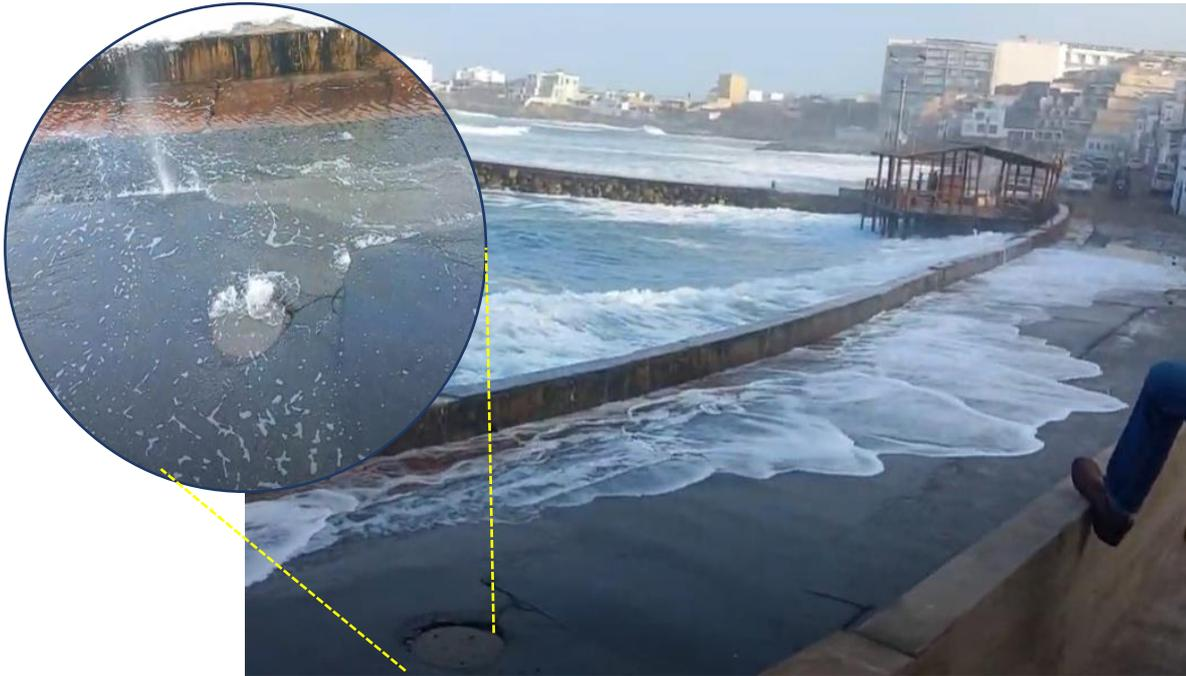
**Figura 24** El fuerte oleaje ha socavado las bases de los muros de contención y ha provocado la aparición de grietas en la vereda y pista por donde filtra el agua.
