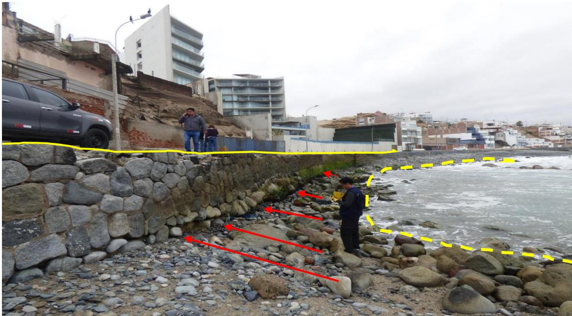
**Figura 22** Playa Norte. el oleaje ha socavado la base del muro de protección como lo señalan las flechas rojas. La distancia de la línea de costa (líneas punteadas amarillas) hacia el muro es de 1 m a 3 m.
