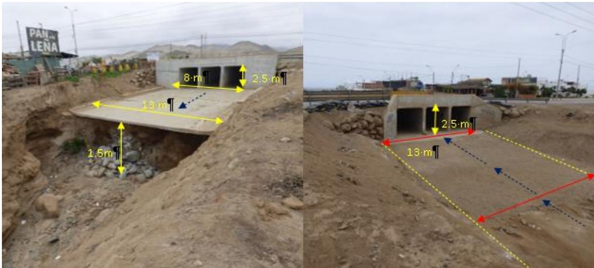
**Figura 14.** Ambos lados del Puente de la antigua Panamericana Sur, se observa socavación de 1.2 m de la base de la plataforma. Las 03 alcantarillas tipo cajón presentan un lado de 2.5 m en un ancho total de 13 m. En la margen derecha se puede observar viviendas a 2 m aprox. de dicha margen. Las flechas punteadas azules indican la dirección del flujo.
