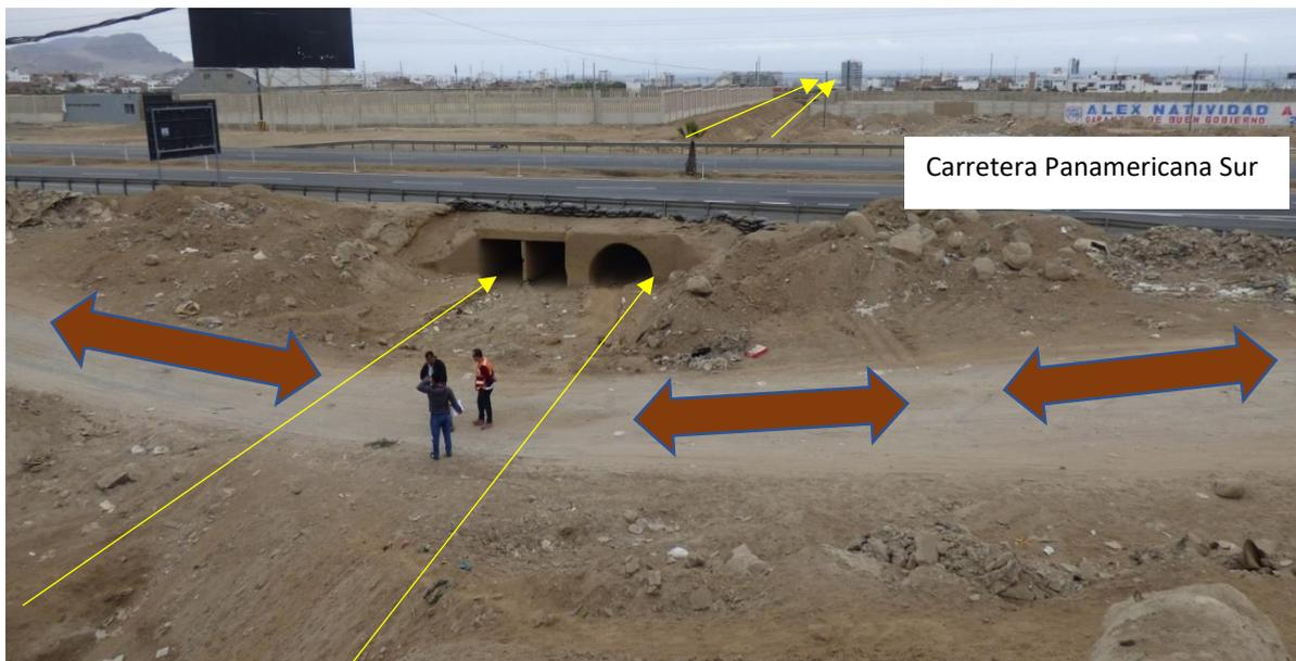
**Figura 16.** Puente de la carretera Panamericana Sur, las flechas amarillas indican el cauce (el cual se reduce en ancho y altura al llegar a la carretera panamericana a causa de las medidas de las alcantarillas bajo el puente) y la dirección del flujo. Las flechas marrones señalan una vía alterna que se elaboró rellinando el cauce de la quebrada, lo que podría generar desbordes a ambos lados de la quebrada y afectando tanto a la población de San Bartolo como a Punta Negra.
