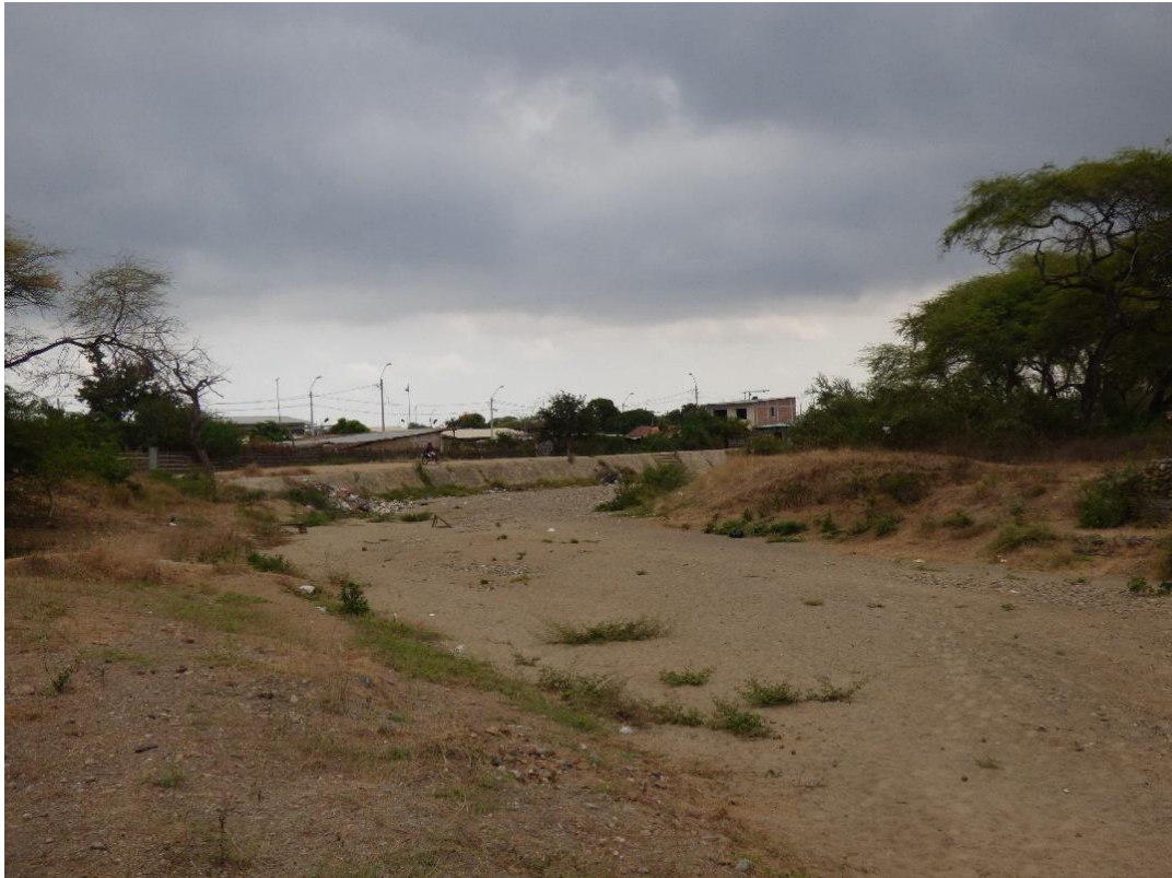
Fotografía 12. Quebrada Cristal (vista aguas abajo), Corrales. Presenta defensas ribereñas, en ciertos tramos, con muros y gaviones.
