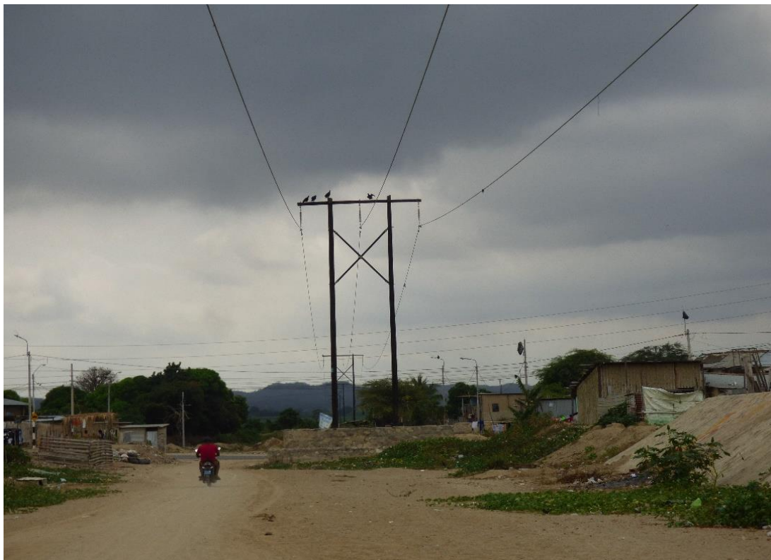
Fotografía 11. Vista aguas abajo de la quebrada Malval, Corrales. Se observa un poste de cableado eléctrico en el cauce de la quebrada, además de viviendas hacia los márgenes. Coordenadas UTM: 558733 / 9599848, Zona 17. Tomado el 23/08/2023.
