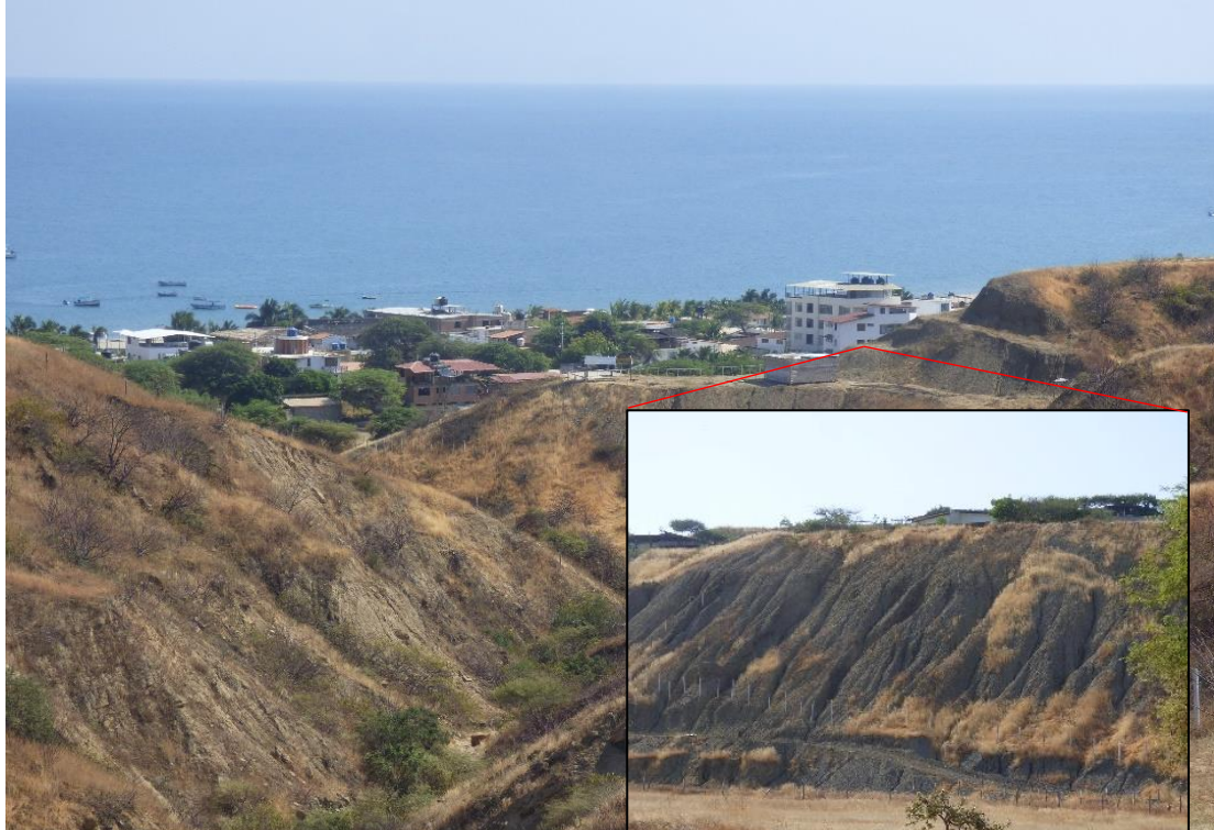
Figura 34. Quebrada Punta Sal (aguas abajo) en su paso por el balneario. Hacia las laderas de los cerros se presentan una marcada erosión en cárcavas que alimentan la quebrada principal.
