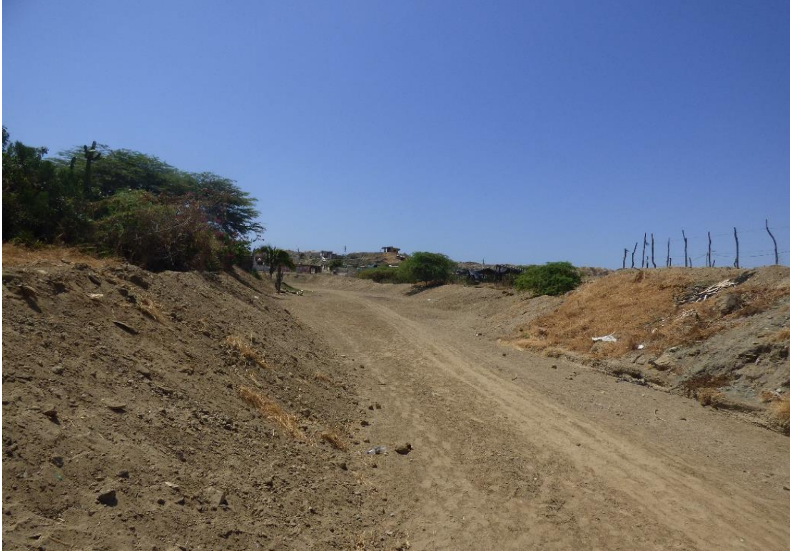
Fotografía 28. Quebrada Nuevo Cancas, distrito de Canoas de Punta Sal, con arrimado de material como defensa ribereña.
