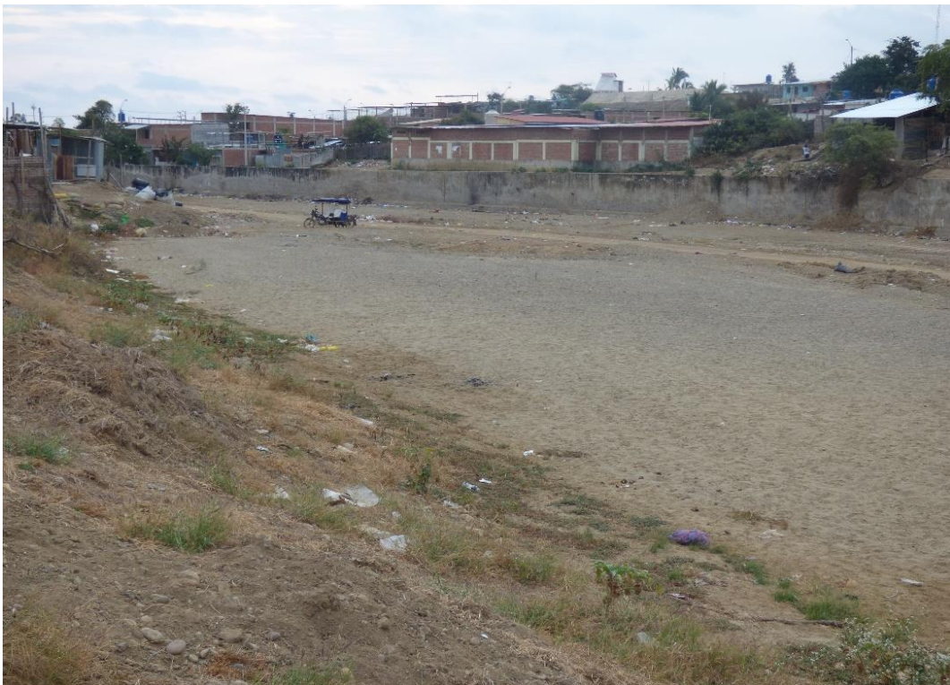
Fotografía 18. Quebrada Coloma (vista aguas abajo). Se presenta defensas ribereñas a la margen derecha, mientras que, hacia la margen izquierda, viviendas sin protección alguna, distrito La Cruz.
