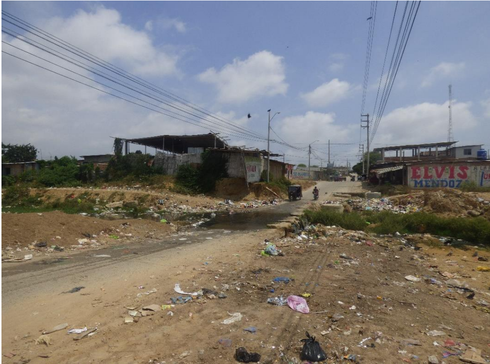
Fotografía 8. Quebrada Pedregal, en su paso por vía de Evitamiento por la ciudad de Tumbes. Presenta colmatación por basura y aguas servidas, además de asentamientos humanos cercanos a las riberas.
