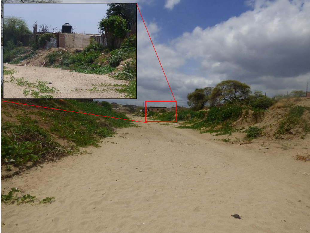
Figura 25. Quebrada Cruz Blanca (vista aguas arriba), Pampas de Hospital, colmatada, sin defensas ribereñas, erosión de laderas en las márgenes, además de viviendas sobre estas. Coordenadas UTM: 564317 / 9594457, Zona 17. Tomado el 24/08/2023.
