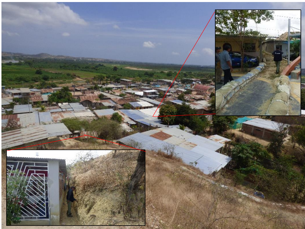
Figura 24. Centro poblado Cerro Blanco, San Juan de La Virgen, afectado por distintos peligros geológicos (flujos, erosión de ladera, derrumbes, inundación fluvial, etc.) durante eventos climáticos.
