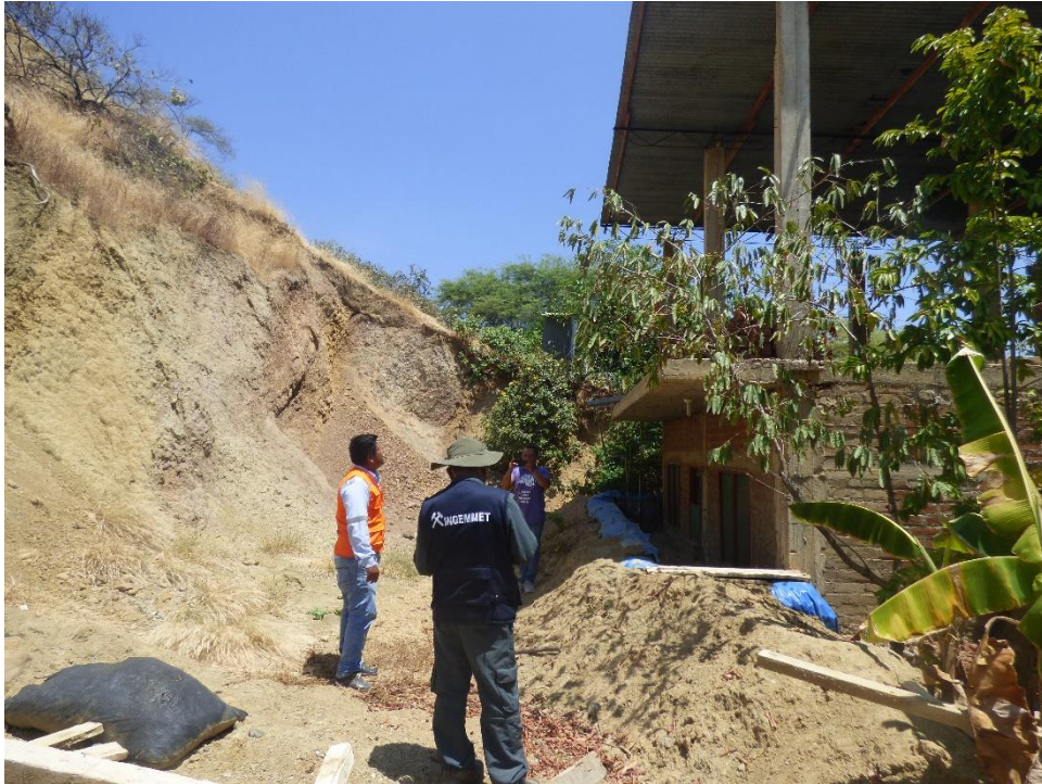
Fotografía 37. Visita a zonas críticas en el C.P. Bocapán, con autoridad de Indeci de la Municipalidad de Zorritos, provincia de Contralmirante Villar.
