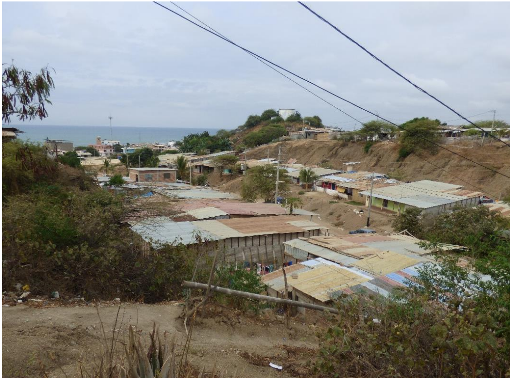
Fotografía 19. Sector Las Palmeras, distrito de La Cruz. Se aprecian viviendas situadas en el pie del talud donde se generan derrumbes. Se observa sustrato poco competente, pendiente muy fuerte. Coordenadas UTM: 545183 / 9597786, Zona 17. Tomado el 22/08/2023.
