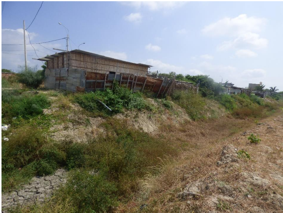
Fotografía 5. Viviendas al margen de la quebrada Quintiliano, que se encuentra colmatada y con procesos de erosión de ladera en la ribera. Sector Las Flores, Zarumilla.
