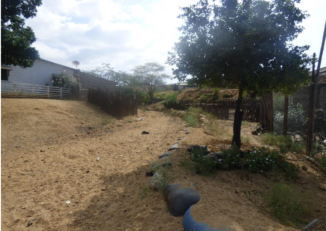
Fotografía 25. Caserío Cherrelique afectado por flujos provenientes de erosión de laderas. La población coloca sacos para evitar inundaciones de sus viviendas por los flujos.
