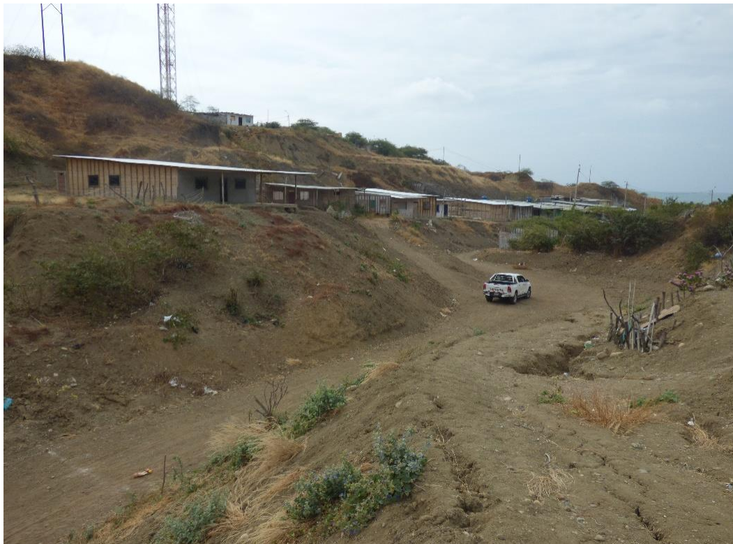
Fotografía 20. A.H. Los Ángeles, distrito de La Cruz. Se aprecian viviendas sobre depósito de relleno afectadas por erosión de laderas en las márgenes de la quebrada Bancharo Rossi. Coordenadas UTM: 544833 / 9597412, Zona 17. Tomado el 22/08/2023.
