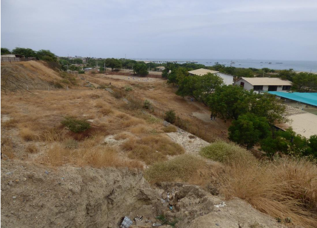
Fotografía 17. Centro Educativo afectado por un deslizamiento, además por procesos de erosión de laderas, A.H. Las Malvinas, La Cruz.
