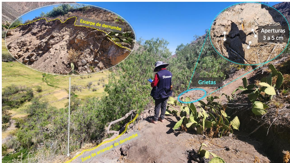
Figura 20. Vista de grietas con aperturas entre 3cm a 5cm y escarpe de derrumbe en el sector de Aguasana Chico. Coordenadas UTM E: 769164, N: 8263815.
