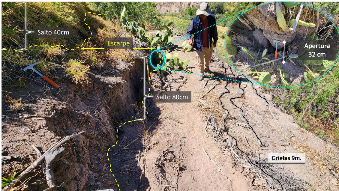
Figura 19. Vista de los escarpes con saltos de 40cm y 80cm con apertura de hasta 32cm y grietas con longitudes de hasta 9 metros en el sector de Aguasana Chico. Coordenadas UTM E: 769155, N: 8263792.
