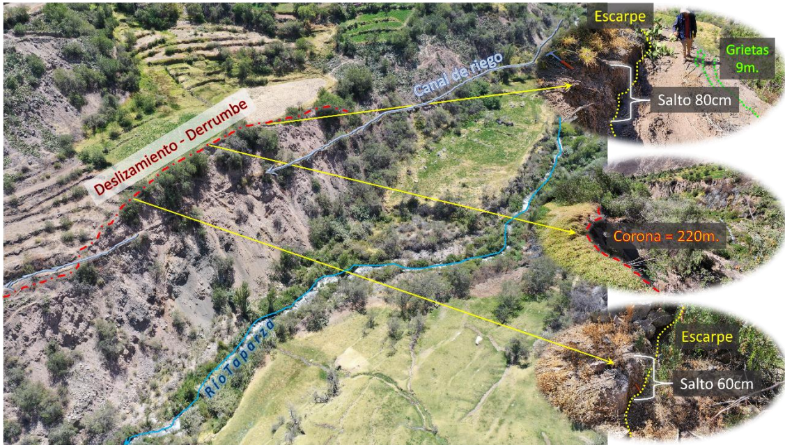
Figura 17. Se observa el movimiento complejo de tipo deslizamiento - derrumbe a la margen derecha del río Taparza.
