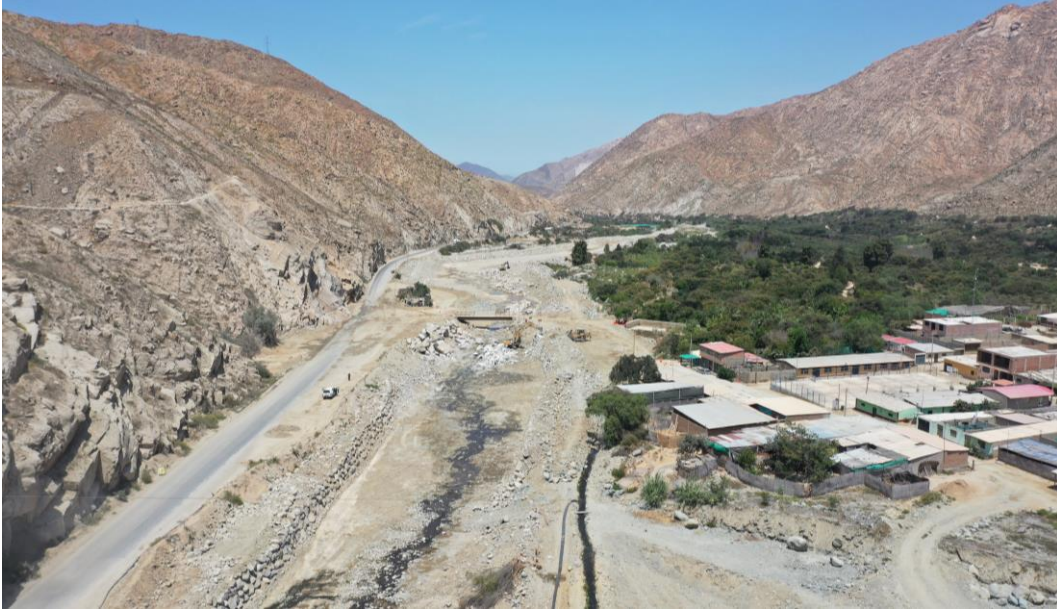
Fotografía 5. Vista de afloramientos rocosos de granitos, monzogranitos y aplitas; en la margen derecha del río Fortaleza. En algunos puntos se presentan altamente meteorizadas y muy fracturadas.
