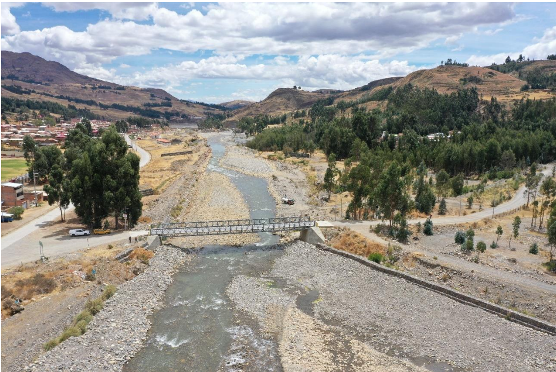
Fotografía 81. Zona crítica 02-103. Vista del puente de conexión entre los centros poblados de Recuay y Huancapampa. Aguas arriba del puente el cauce del río Santa presenta ancho de 20 m con una llanura de inundación de 112 m.
