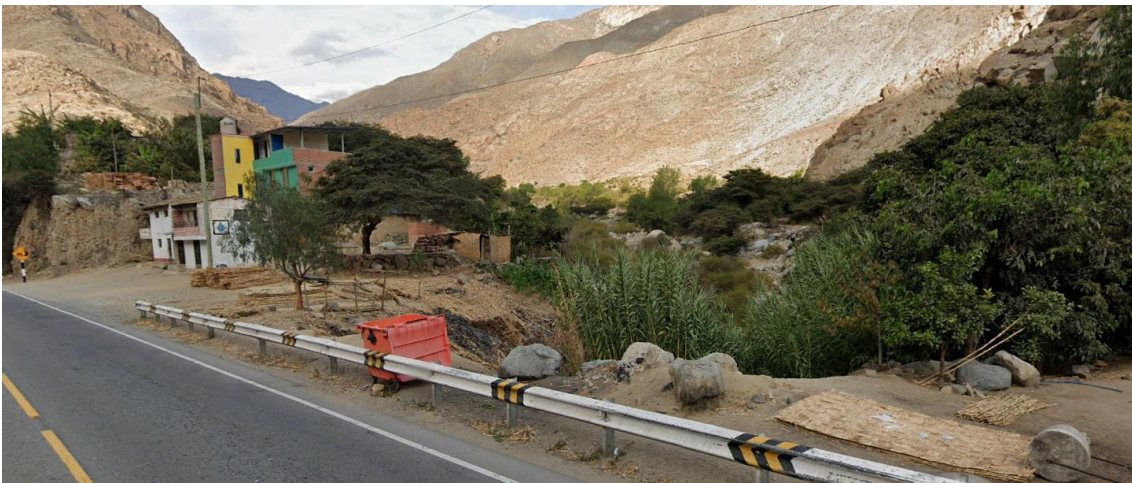
Fotografía 85. Zona crítica 02-107. Se encuentra en la margen izquierda del río Fortaleza, entre las quebradas Llama Rumi y Huich, la primera representa mayor antecedente por flujo de detritos. Está conformada por acumulación de grava, arena, limo y arcilla con bloques subangulosos a redondeados. Coordenada UTM: 8867355 / 218776, Zona 18 L. Tomada el 17-09-2023.
