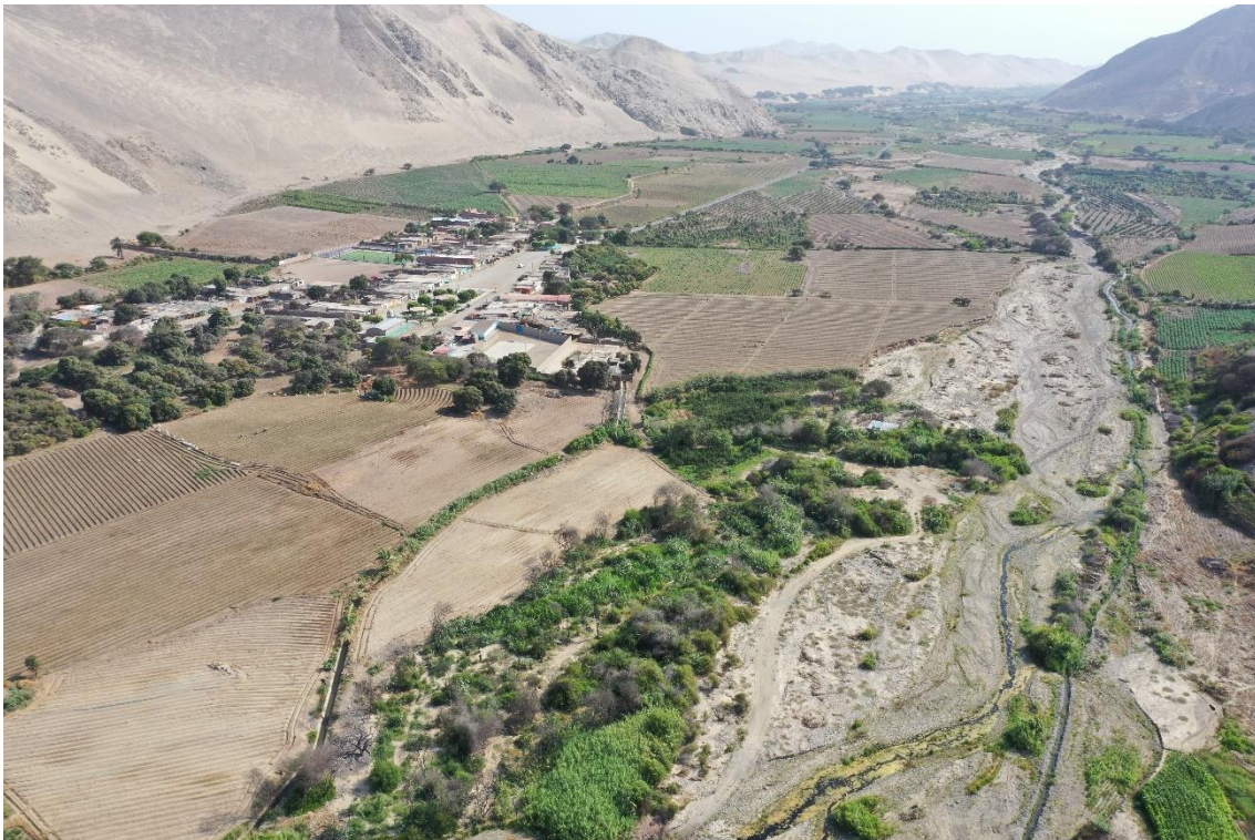
Fotografía 102. Zona crítica 02-133. La terraza aluvial donde se encuentra situado El Molino, está siendo erosionada por la dinámica fluvial del río Culebras, cuando este incrementa su caudal en temporada de lluvias intensas, afectando principalmente terrenos de cultivo. Coordenadas UTM: 8906343 / 816507, Zona 17 L. Tomado el 14-09-2023.
