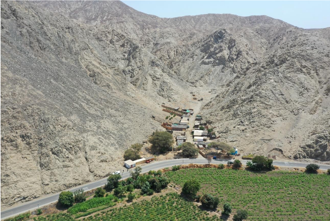
Fotografía 97. Zona crítica 02- 122. Tayca nuevo este situado en la margen derecha del río Huaramey, entre la zona de aporte de una quebrada seca (abanico proluvial) y la terraza aluvial del río Huaramey. Susceptible a flujo de detritos.
