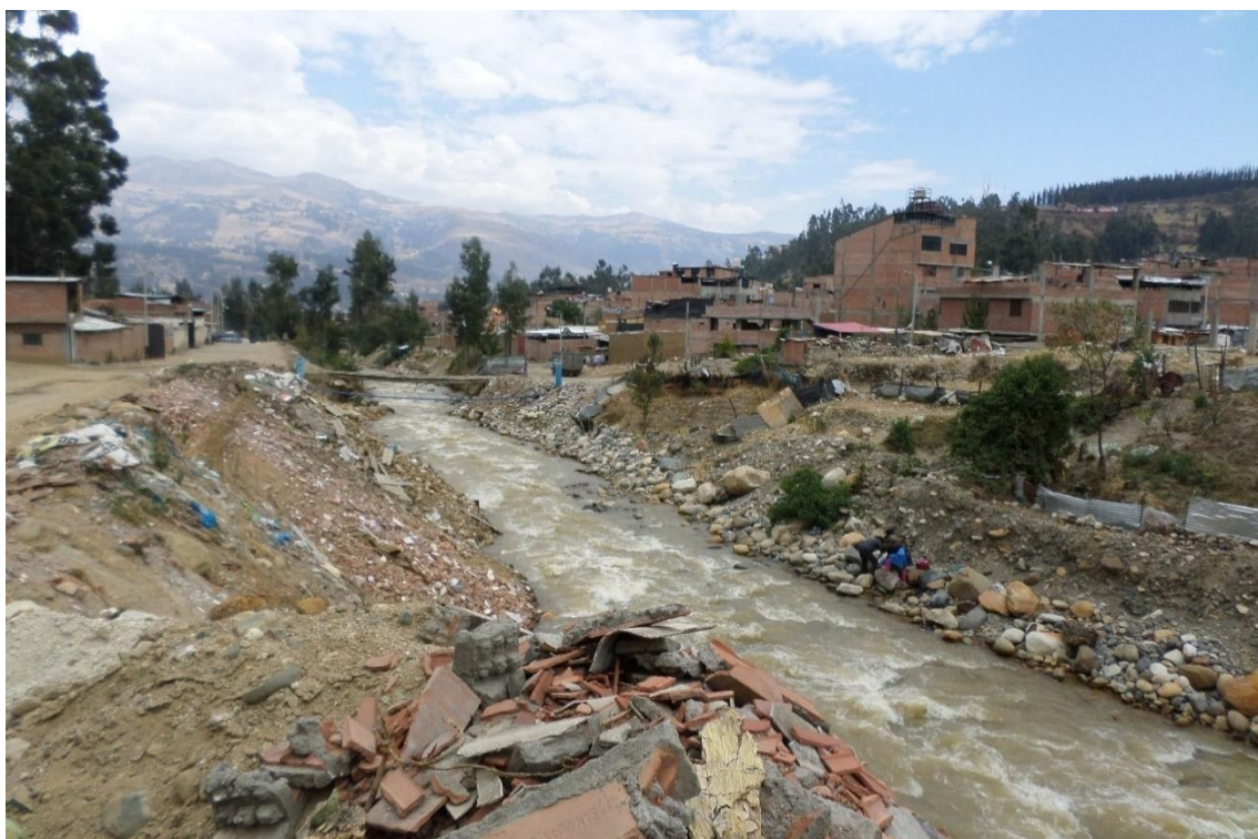
Fotografía 31. Zona crítica 02-008. Cauce del río Auqui, se evidencia reducción del ancho del cauce natural por los depósitos de desmontes en ambas márgenes del río, desencadenando aguas abajo flujo de detritos. Coordenadas UTM: 8945720 / 224343, Zona 18. Tomada el 13-09-2023.
