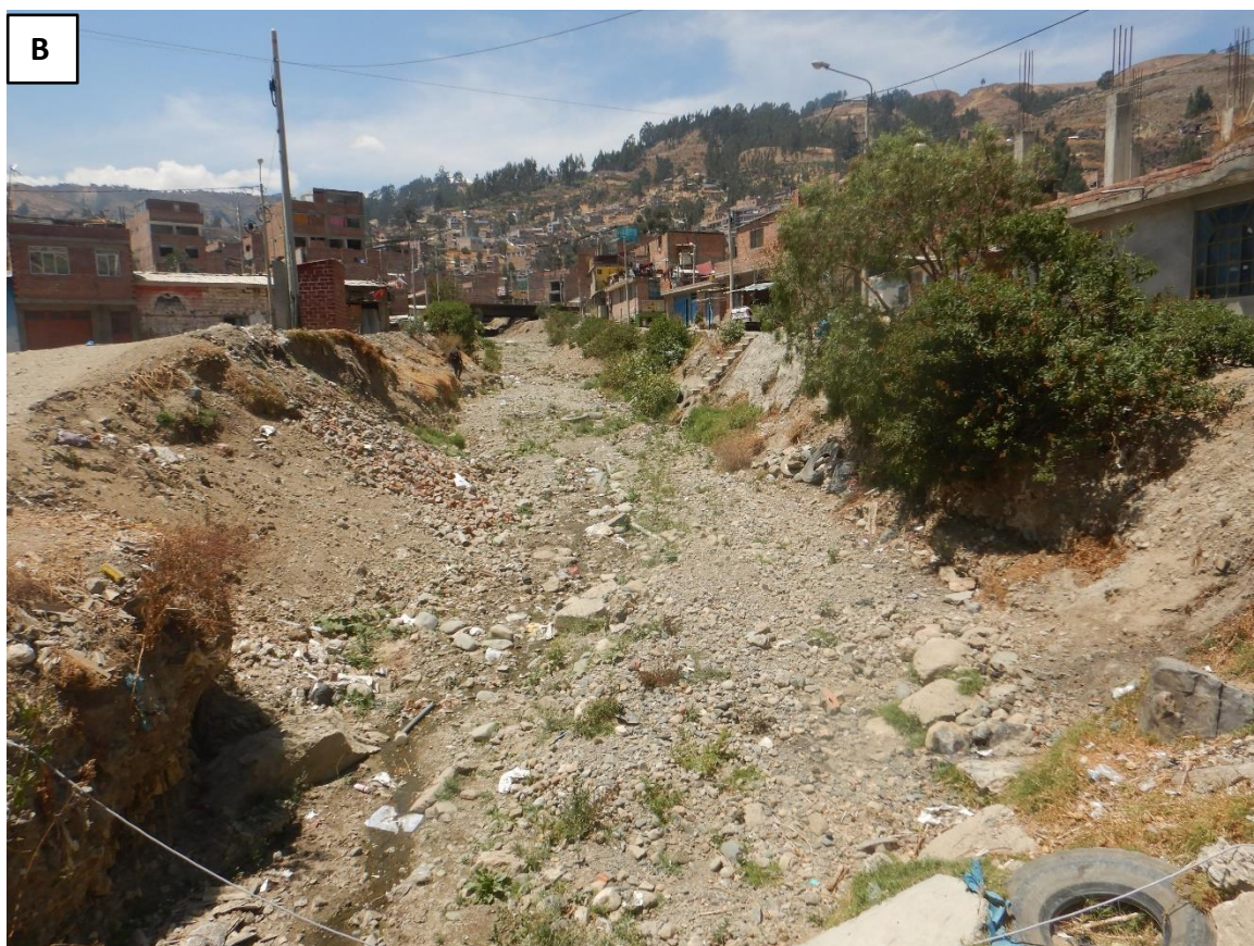
Figura 5. Zona crítica 02-001. Zona afectada por erosión fluvial y flujo de detritos A) Viviendas asentadas al borde de la margen izquierda del río Santa, afectado por erosión fluvial. B) flujos de detritos compuestos por diferentes tamaños de bloques arrastrados a lo largo de la quebrada Río Seco que confluye al río Santa.
