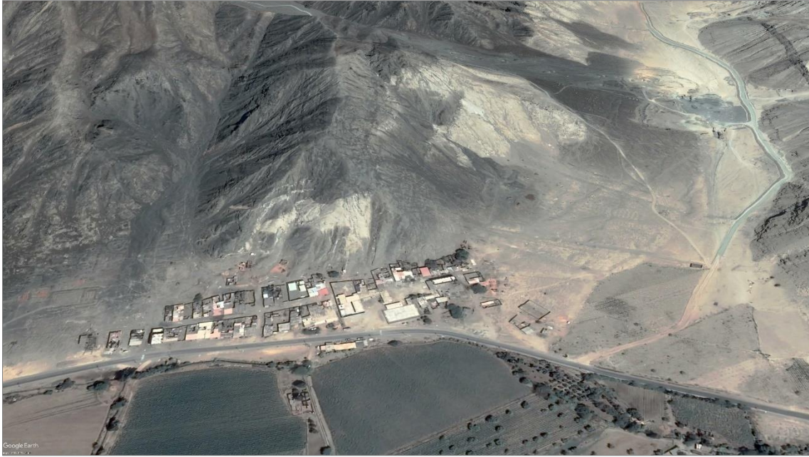
Figura 22. Zona crítica 02- 124. La población de Tayca antiguo, asentada al pie de ladera de una montaña modelada en roca volcánica y ubicada entre dos quebradas con evidencias de flujo de detritos pasados enfrenta una serie de problemas geodinámicos potenciales. Coordenadas UTM: 8891753 / 822237, Zona 17 L. Tomado del Google Earth.
