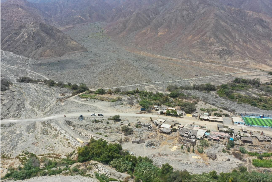
Fotografía 106. Zona crítica 02-138. Lagunas se encuentra en zona de susceptibilidad muy alta a flujo de detritos. Se conoce que los años 2017 y 2023 fue afectado por la activación de la quebrada Liplli, inundando parte de viviendas, terrenos de cultivo y vías de acceso. Coordenadas UTM: 8912322 / 171607, Zona 18 L. Tomado el 08-09-2023.
