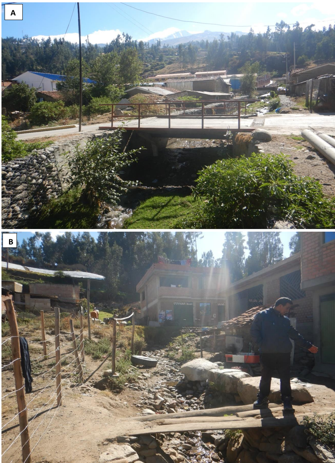
Figura 7. Zona crítica 02-022. Zona afectada por flujo de detritos A) viviendas asentadas en ambas márgenes de la quebrada Mesayacu, afectados por flujos de detritos, ubicado con coordenadas N: 8967744; E: 219562, B) Cauce de la quebrada Huerta Ruri, en temporada de lluvias ésta quebrada se desborda y afecta las viviendas ubicadas cerca al cauce, ubicado con coordenadas N:8967936; E:219481. Zona 18. Tomada el 21-09-2023.
