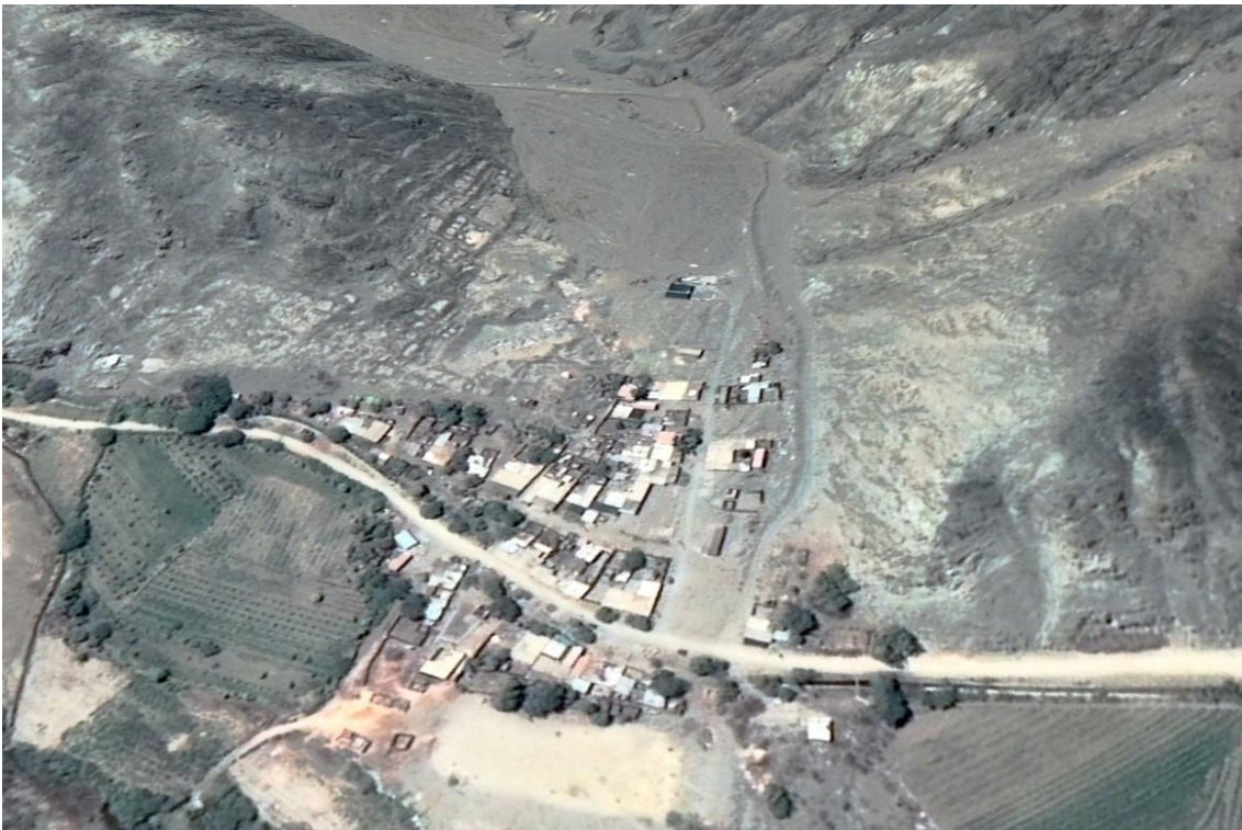
Figura 9. Zona crítica 02-029. Quebrada activada durante el ciclón Yaku en su paso por el sector Nivin afectó las viviendas asentadas dentro del cauce de la quebrada.
