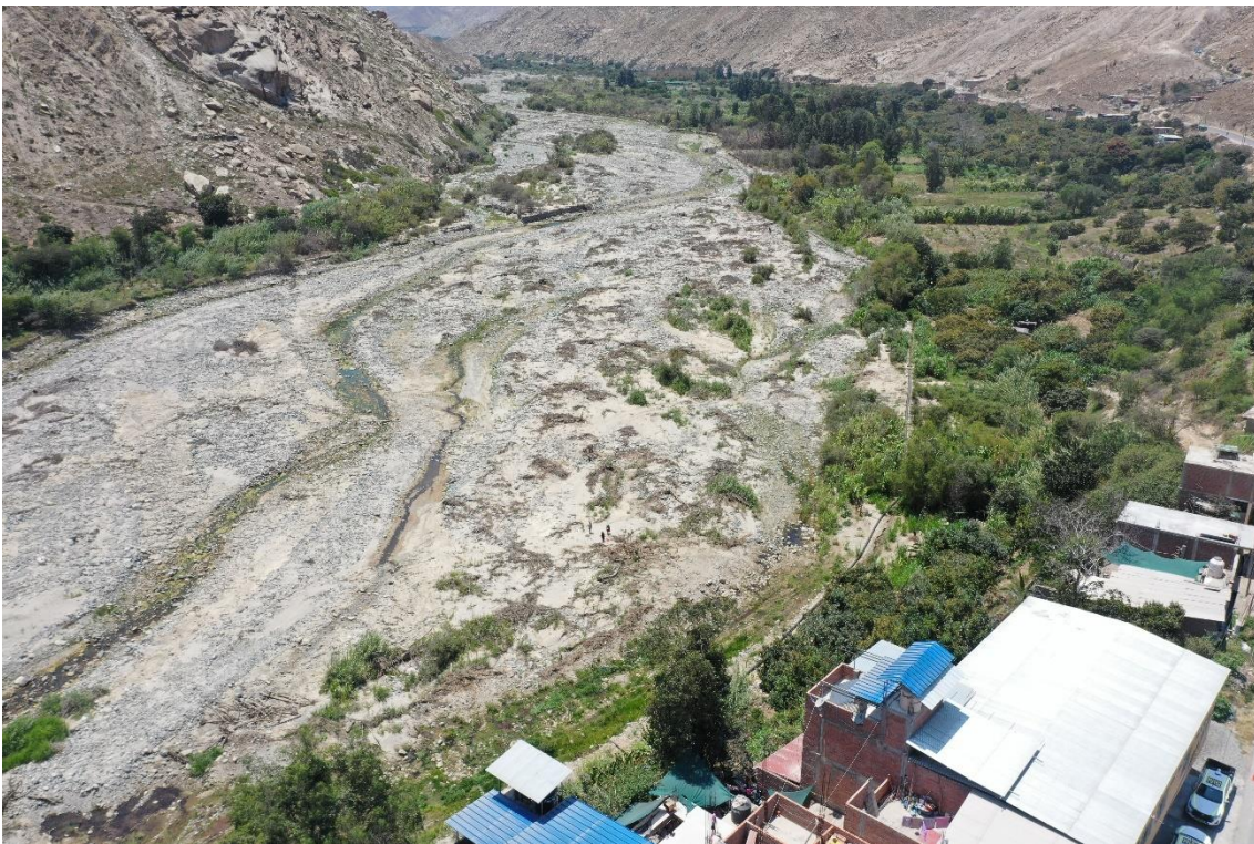
Fotografía 91. Zona crítica 02-114. Viviendas del poblado de Chasquitambo asentadas muy próximas a la margen izquierda del río Fortaleza, con muchas probabilidades de afectación por flujo de detritos y erosión fluvial del río referido. Coordenadas UTM: 8864352 / 217280, Zona 18 L. Tomado el 17-09-2023.
