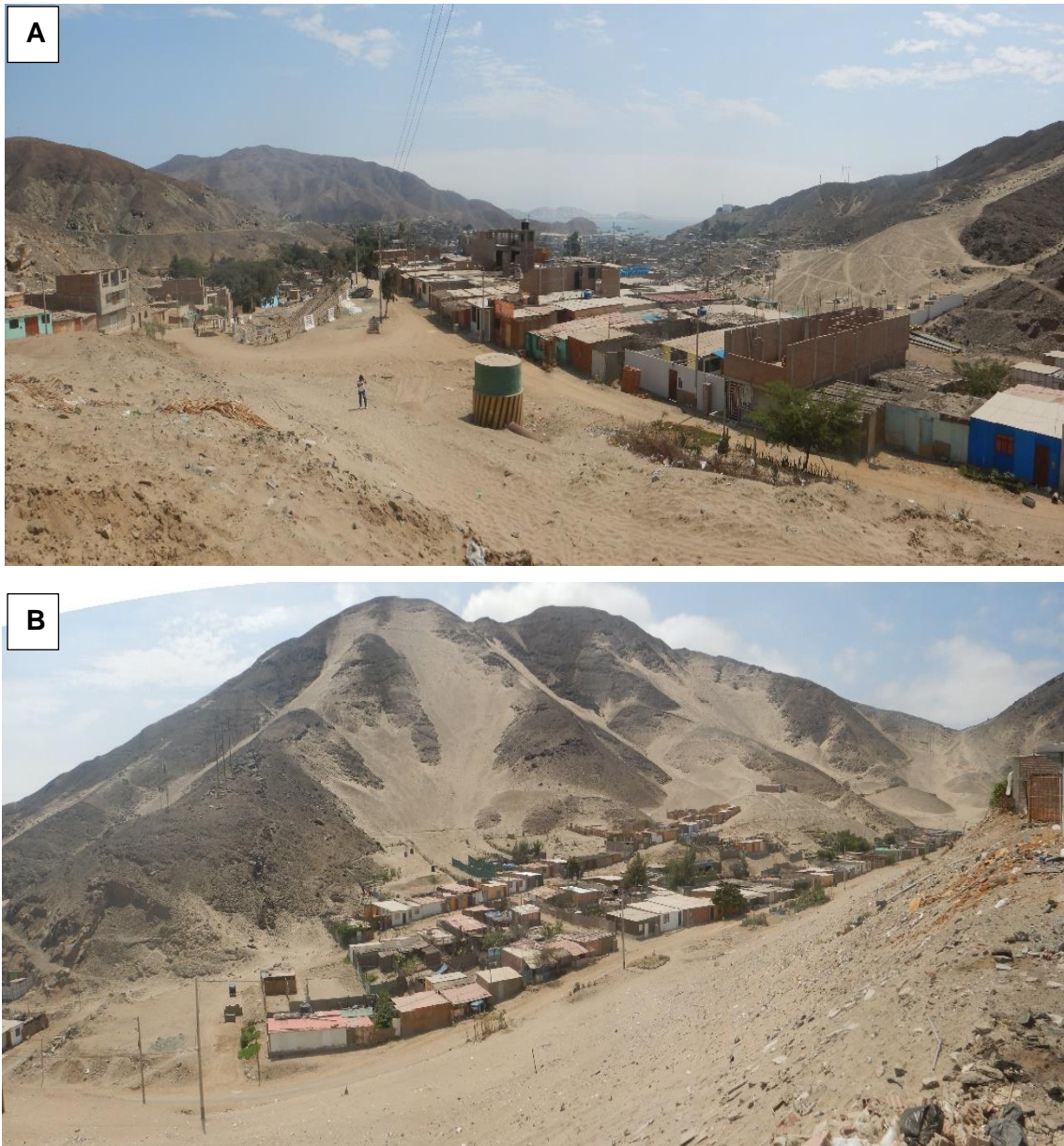
Figura 15. Zona crítica 02-071. Zona afectada por flujo de detritos, A) Viviendas del Barrio Chino y San Valentín asentadas dentro del cauce de la quebrada, B) Viviendas del A.H. Ollanta Humala asentadas dentro del cauce de la quebrada, se evidencia aporte de varios flujos canalizados y no canalizados.
