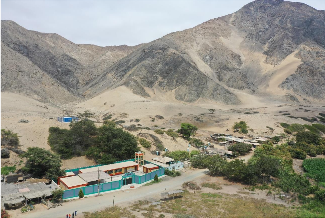
Fotografía 104. Zona crítica 02-136. Se encuentra ubicado en la margen izquierda del río Culebras y disectado por una quebrada secundaria, que acarreo huaicos antiguos, formando un abanico proluvial.
