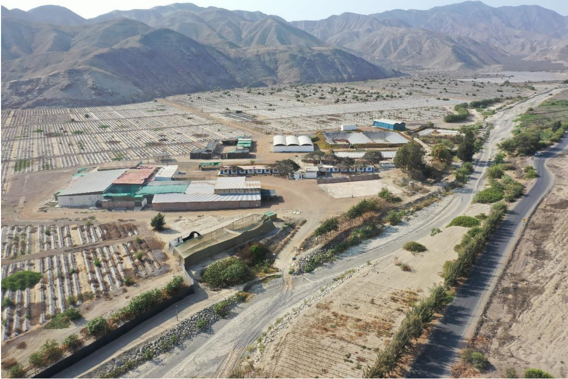
Fotografía 101. Zona crítica 02-130. Sector Ampanú asentado sobre extensas terrazas aluviales. En temporada de lluvias intensas, incrementa el caudal del río Culebras, generando erosión en ambas márgenes del río.
