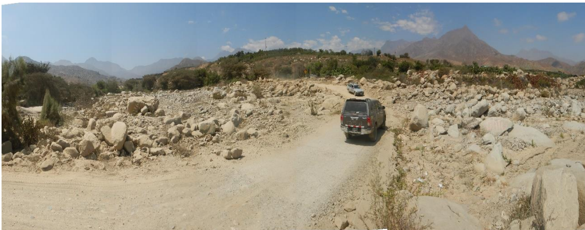
Fotografía 45. Zona crítica 02-031. La carretera Huanchu-Piedra parada en su paso por la quebrada Hualanyoc, es afectada periódicamente por flujo de detritos compuestos por diferentes tamaños de bloques arrastrados a lo largo de la quebrada.
