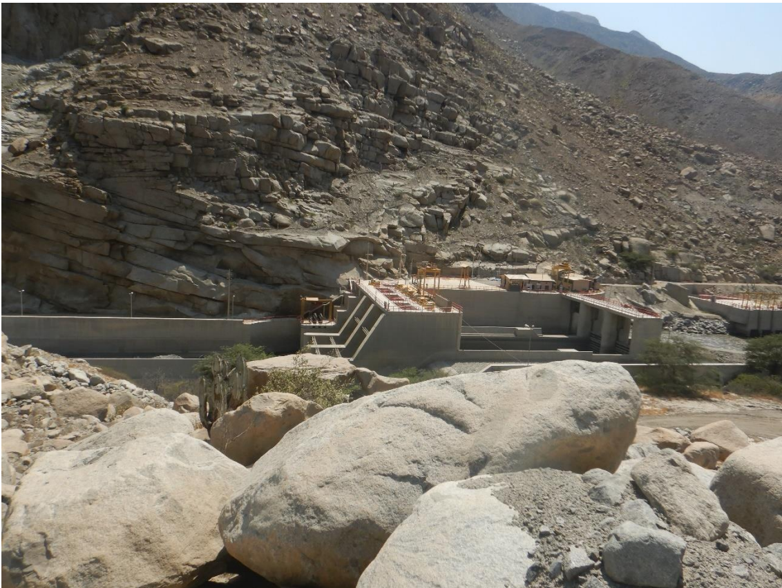
Fotografía 60. Zona crítica 02-055. Represa Chavimochic, es afectado por flujo de detritos en períodos de lluvias, además en las laderas aledañas se evidencian bloques sueltos que al ocurrir un sismo podrían rodar ladera abajo afectando la represa.
