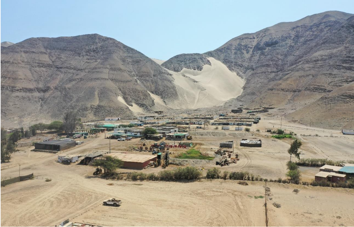
Fotografía 99. Zona crítica 02-128. Esta zona corresponde a un abanico de una quebrada descendiente de la margen derecha del río Pararin. Se encuentra circundada por colinas y lomadas en roca vulcano-sedimentaria, cubiertos por arenas, de origen eólico, la cuales de una manera u otra alimentan el cauce de la quebrada, generando flujo de lodo Coordenadas UTM: 8863139 / 824356, Zona 17 L. Tomado el 16-09-2023.
