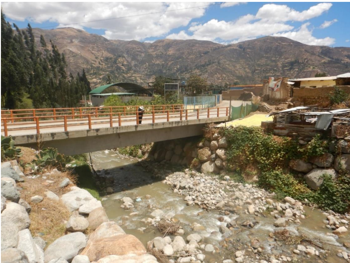
Fotografía 2. Encauzamiento de una quebrada.
