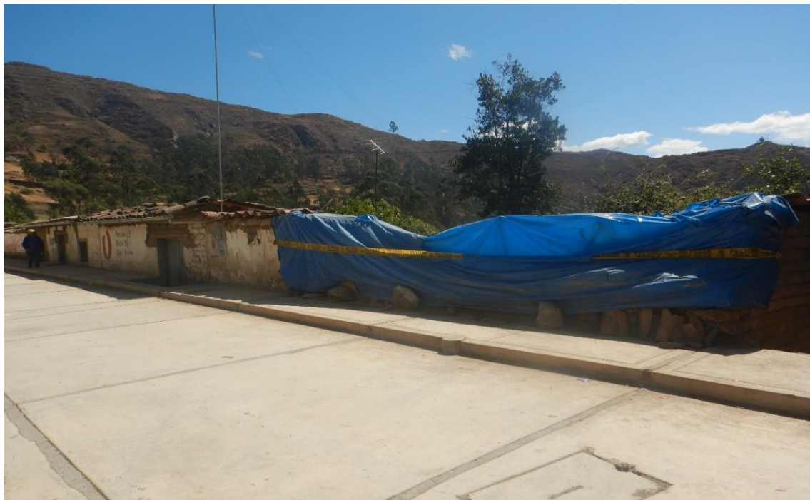
Fotografía 57. Zona crítica 02-050. Barrio Huayran, en período de lluvias se recargan los 04 puquiales ubicados alrededor de la zona, los cuales provocan inundaciones en la calle el triunfo, donde destruyó 01 vivienda.
