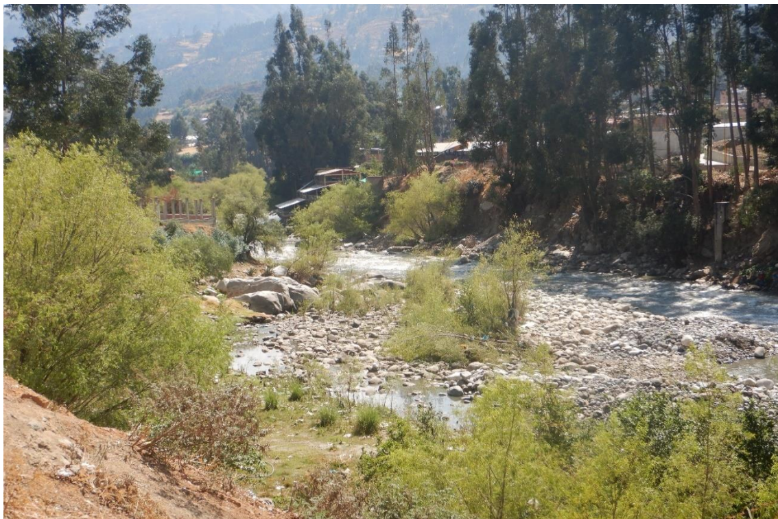
Fotografía 30. Zona crítica 02-006. Caserío Miraflores-Mashrapampa, afectado por erosión fluvial, el 2017 destruyó 02 viviendas y 600m de carretera. Coordenadas UTM: 8949512 / 220882, Zona 18. Tomada el 12-09-2023.
