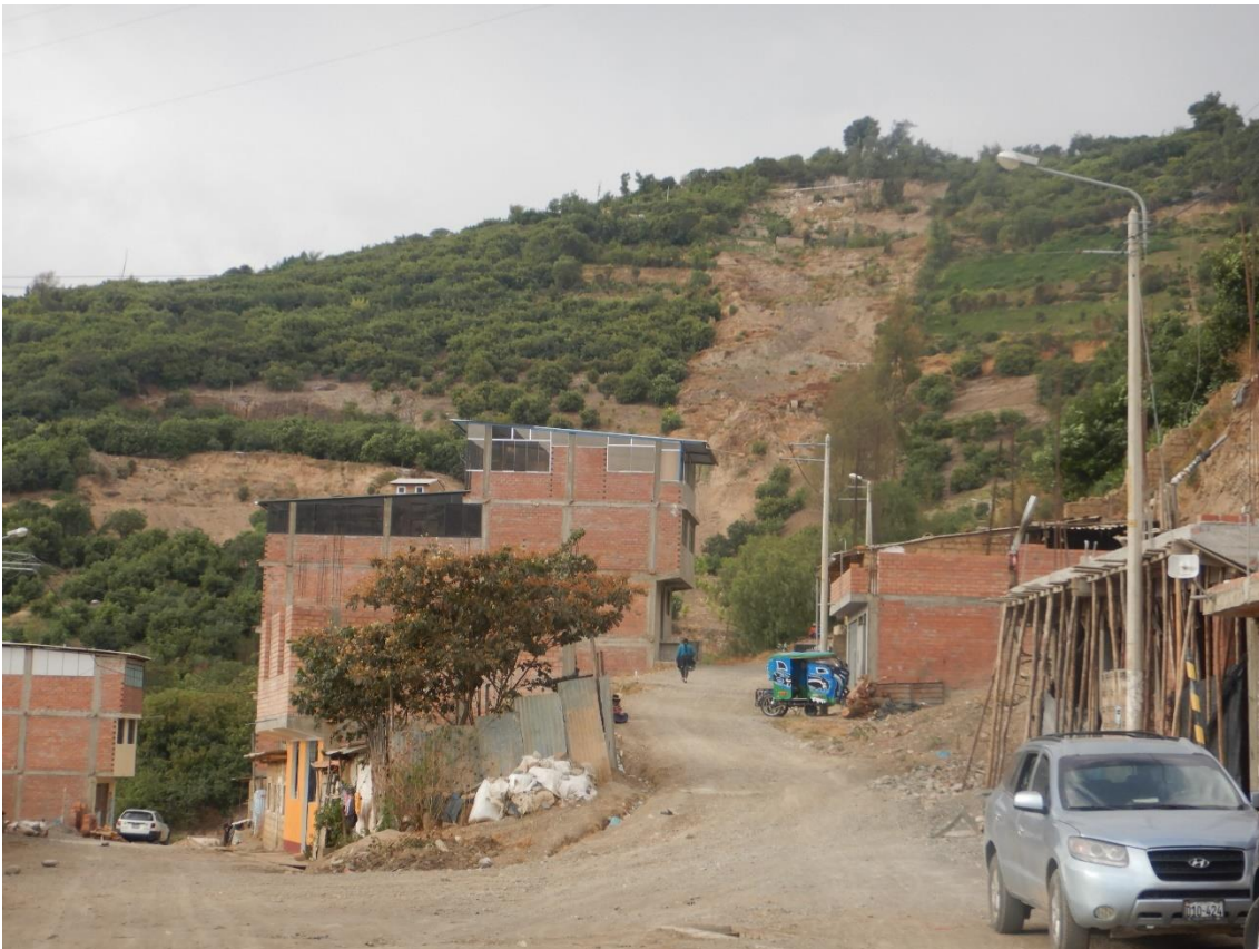
Fotografía 77. Zona crítica 02-093. Movimiento complejo (Derrumbe-flujo), este proceso es producto de una ruptura de canal de riego, ubicado en la parte alta del movimiento, en caso de reactivarse aguas abajo de la quebrada podría afectar viviendas del poblado Yungay.
