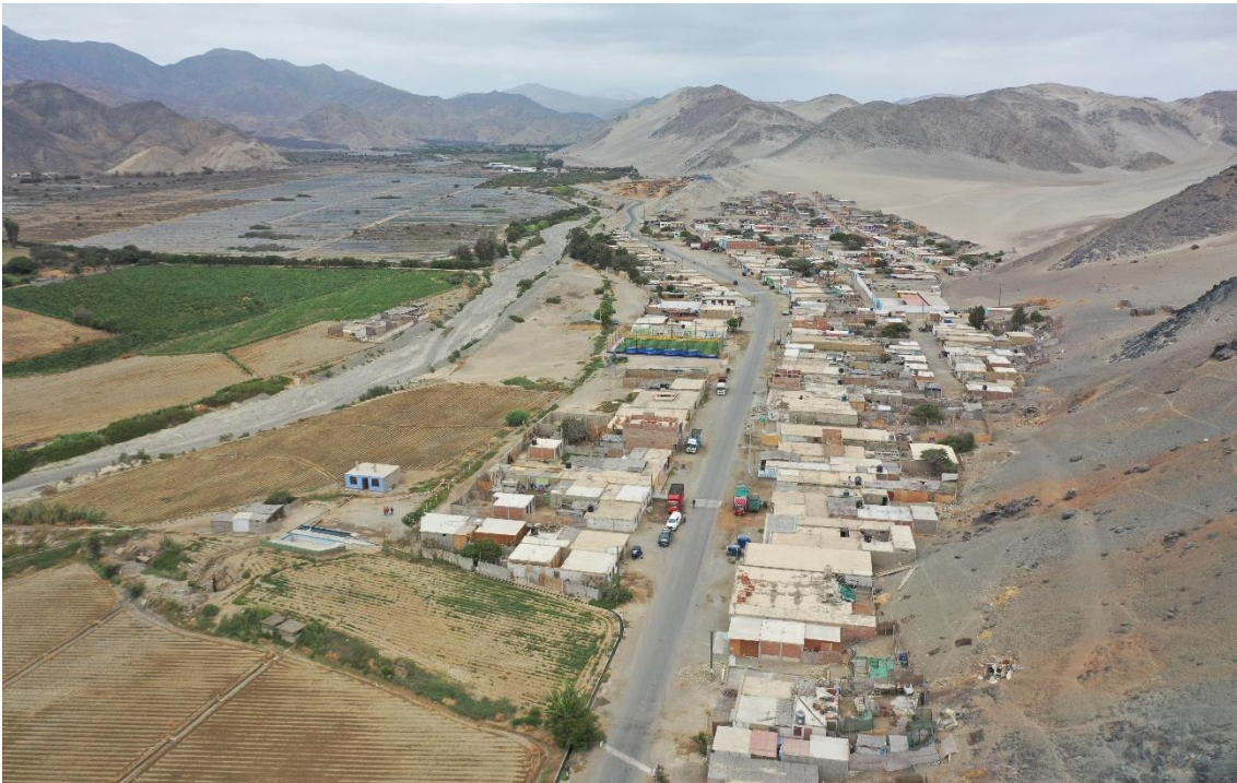
Fotografía 100. Zona crítica 02-129. Zona propensa a ser afectada por flujo de detritos y erosión fluvial, proveniente de la parte alta del río Culebras, sobre todo en períodos excepcionales de lluvias, como lo acontecido el año 2017 y 2023 ante El Fenómeno del Niño y el ciclón Yaku, que afectó viviendas y terrenos de cultivo. Coordenadas UTM: 8863139 / 824356, Zona 17 L. Tomado el 14-09-2023.
