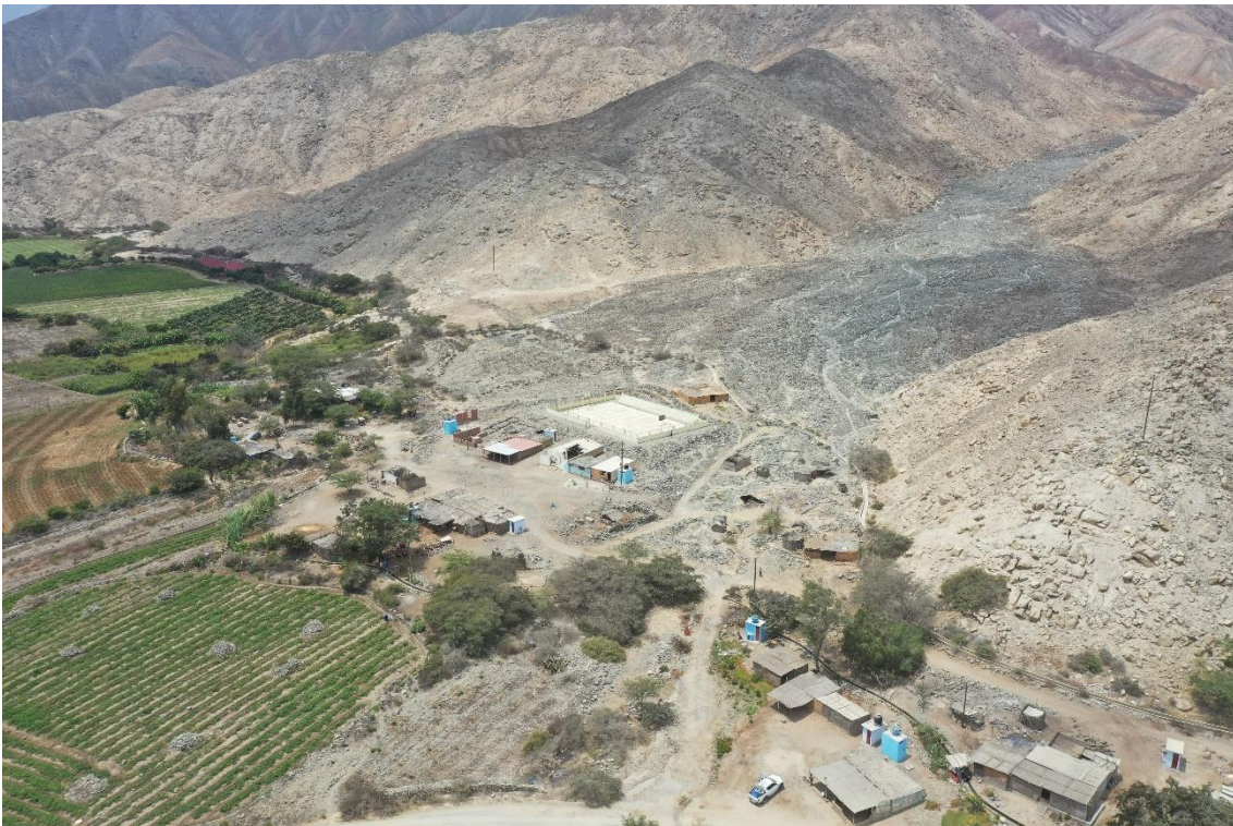
Fotografía 105. Zona crítica 02-137. Cuzmo se encuentra asentado sobre un abanico proluvial, donde los 1997 y 2023, fue afectado por flujo de detritos que afectó parte de las viviendas ubicadas en el cauce de la quebrada.
