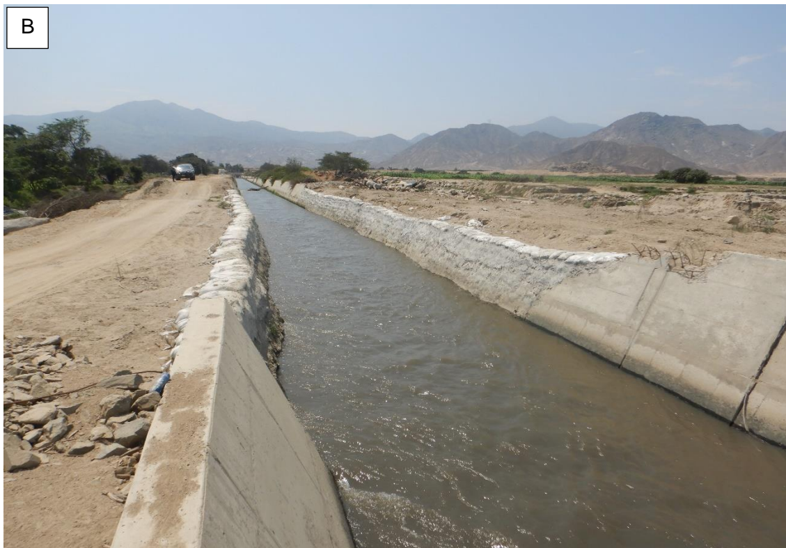
Figura 13. Zona crítica 02-067. Zona afectada por flujo de detritos, A) Enrocado socavado por el flujo de detritos y erosión fluvial, ubicado con coordenadas N:9016017, E:776842, B) Canal Chinalco afectado por el flujo de detritos, actualmente reconstruido con sacos térreos y cemento, ubicado con coordenadas N: 9015668; E: 776894. Zona 17. Tomada el 02-09-2023.
