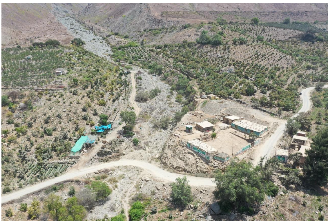
Fotografía 113. Zona critica 02-147. Sector Congon asentado en la desembocadura de la quebrada Congon, es afectado por flujo de detritos y erosión fluvial. Coordenadas UTM: 8830200 / 234572, Zona 18 L. Tomada el 19-09-2023.
