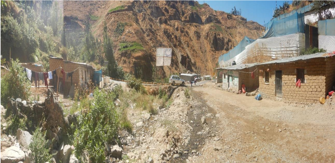
Fotografía 35. Zona crítica 02-013. Viviendas asentadas dentro del cauce de la quebrada Lameda y afectadas por flujo de detritos (huaicos).
