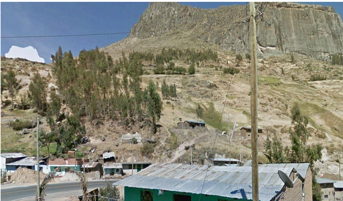
Fotografía 88. Zona crítica 02-110. Vista del poblado Santa Rosa, propensa a ser afectada por flujo de detritos proveniente de la quebrada Camaguisque y por deslizamientos provenientes de la ladera sur.
