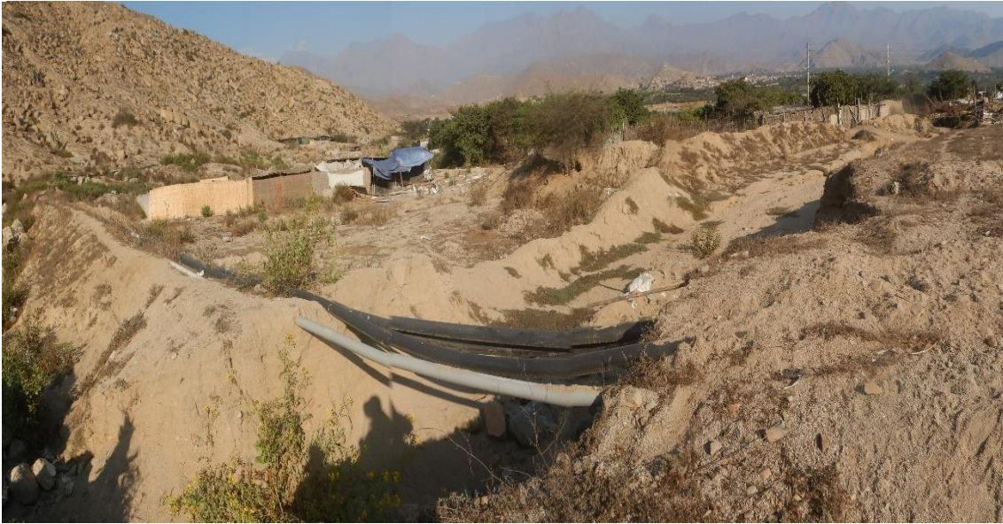
Fotografía 73. Zona crítica 02-088. El centro poblado San Juan es afectado por flujo de detritos periódicamente, posterior a lo ocurrido del fenómeno de El Niño 2017, construyeron un dique transversal, el cual fue construido por el material arrimado del mismo depósito de flujo de detritos. Coordenadas UTM: 8990924 / 808406, Zona 17. Tomada el 07-09-2023.
