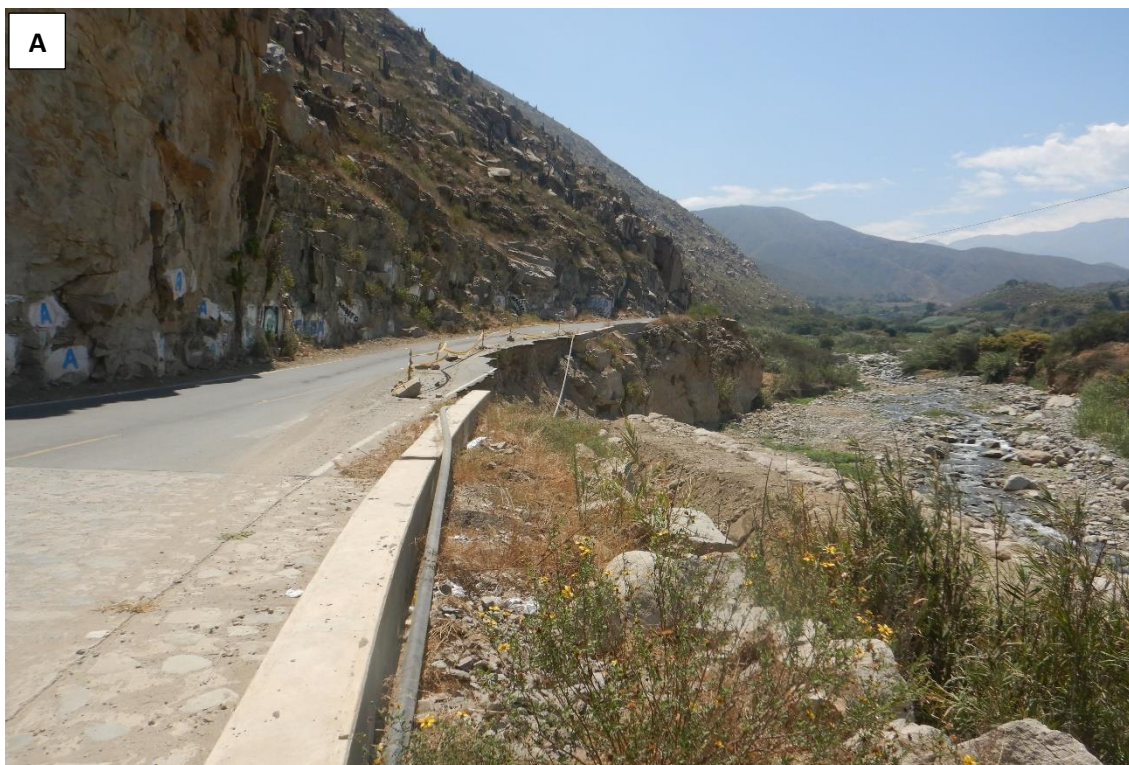
Figura 13. Zona crítica 02-067. Zona afectada por flujo de detritos, A) Enrocado socavado por el flujo de detritos y erosión fluvial, ubicado con coordenadas N:9016017, E:776842, B) Canal Chinalco afectado por el flujo de detritos, actualmente reconstruido con sacos térreos y cemento, ubicado con coordenadas N: 9015668; E: 776894. Zona 17. Tomada el 02-09-2023.
