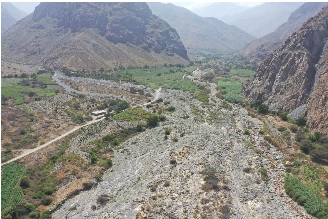
Fotografía 110. Zona crítica 02-143. La quebrada Monsalve representa peligro por flujo de detritos, esto debido a la cantidad de material detrítico en su cauce, baja pendiente, que afectaría viviendas, vías de comunicación y postes de tendidos eléctricos.
