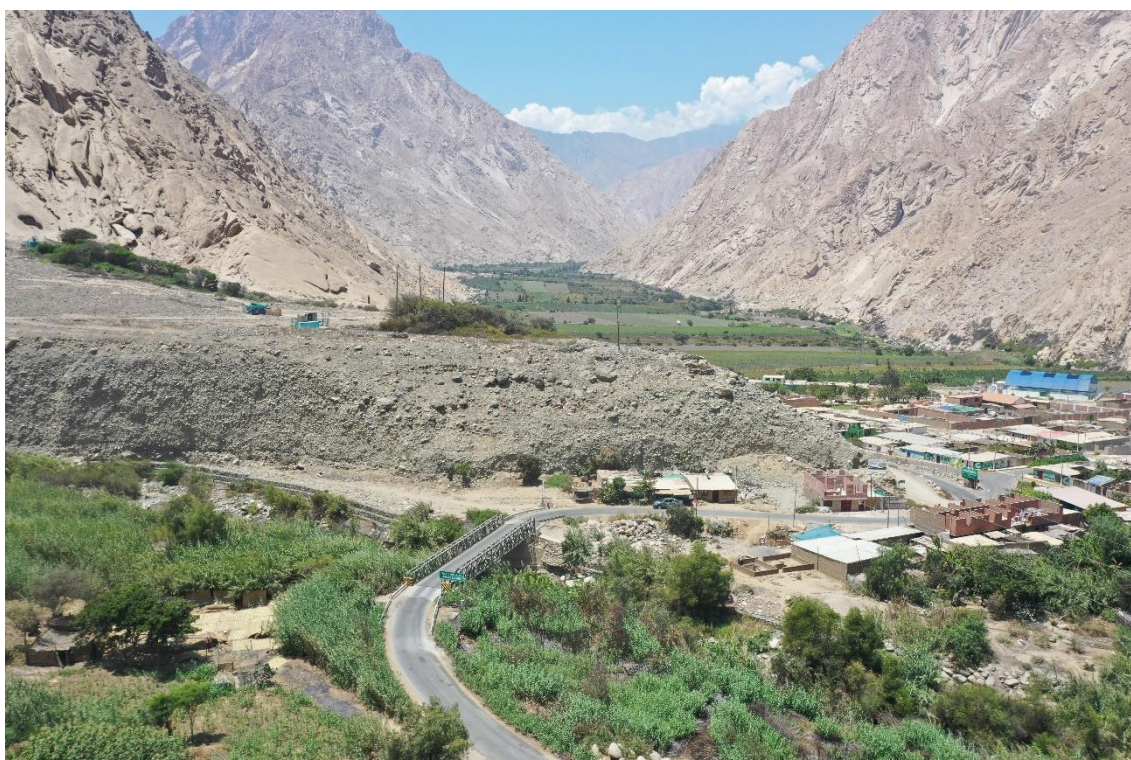
Fotografía 112. Zona crítica 02-145. Sector LLamachupan afectado por flujo de detritos proveniente de la quebrada Huanchay. Coordenadas UTM: 8826320 / 234688, Zona 18 L. Tomado el 18-09-2023.
