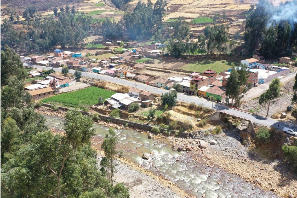
Fotografía 37. Zona crítica 02-099. Vista del sector Acos afectado por flujos de detritos (huaicos) que descienden de manera periódica de la quebrada Lloclla, la cual confluye por la margen derecha al río Santa, afectando viviendas, iglesia y terrenos de cultivo.
