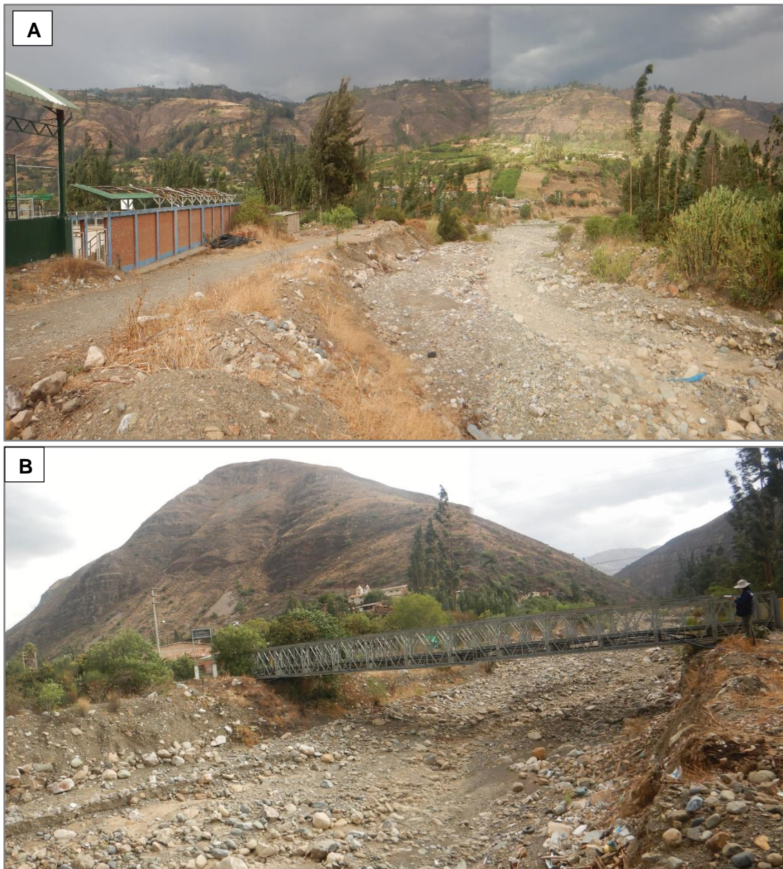
Figura 18. Zona crítica 02-098. Zona afectada por flujo de detritos, A) Vista de la quebrada Santo Toribio, el cual se reactiva en temporadas de lluvias, B) En la parte alta del poblado de Shupluy, se observa un deslizamiento antiguo, que de reactivarse podría afectar parte del poblado. En el cuerpo de este deslizamiento se observa depósitos de canchales, que podrían caer ante un sismo. Coordenadas UTM: 8980231 / 203967, Zona 18. Tomada el 20-09-2023.
