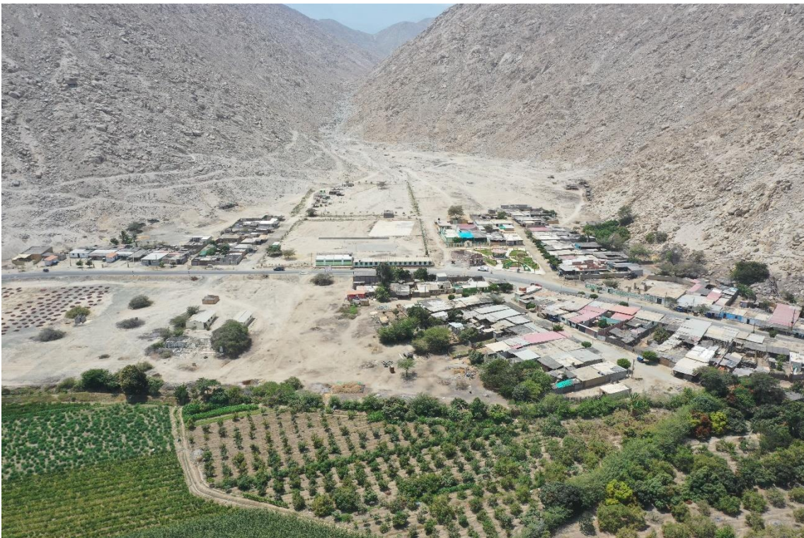
Fotografía 93. Zona crítica 02-117. Quebrada Seca con una acumulación significativa de material detrítico es susceptible de generar flujo de detritos que pueden afectar la población de María Cristina. Coordenadas UTM: 8892345 / 180333, Zona 18 L. Tomado el 12-09-2023.
