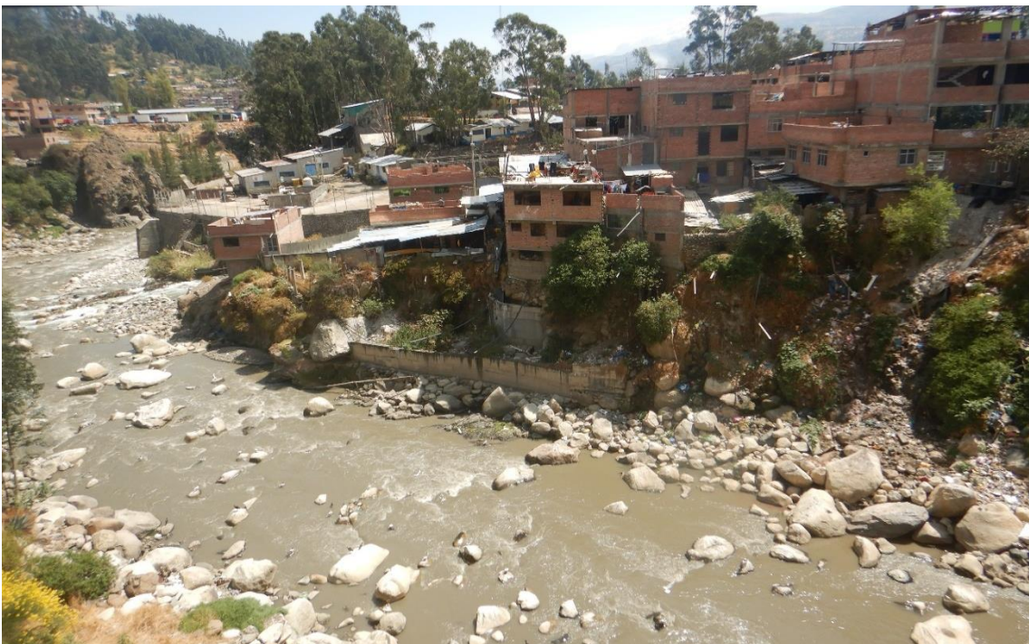
Fotografía 29. Zona crítica 02-005, Viviendas asentadas al borde del cauce del río Santa (margen derecha), estas viviendas son afectadas por erosión fluvial en períodos de lluvias por el incremento del caudal del río. Coordenadas UTM: desde 8946107 / 220456 hasta 8946628 / 221539, Zona 18. Tomada el 11-09-2023.
