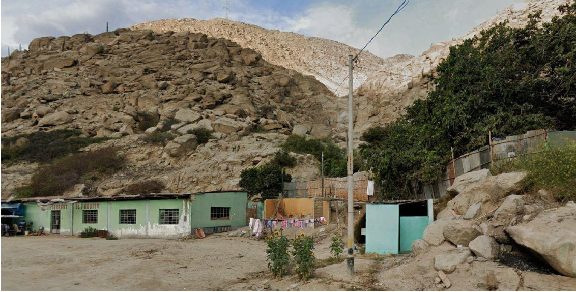
Fotografía 90. Zona crítica 02-113. Vista del sector Paraíso, asentado en la desembocadura de una quebrada, con altas probabilidades de afectación ante la ocurrencia de flujo de detritos. Coordenadas UTM: 8860530 / 215134, Zona 18 L. Tomado el 17-09-2023.
