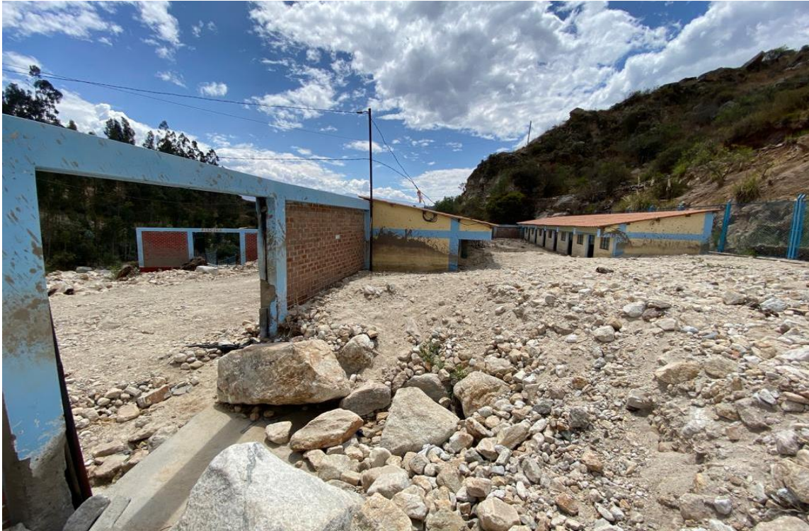
Fotografía 56. Zona crítica 02-049. Muestra un flujo de detritos de material heterogéneo, esta quebrada se activa en temporadas de lluvia, con el ciclón Yaku 2023, afectó parte de 02 piscinas ubicadas en la margen derecha de la quebrada Los Baños.
