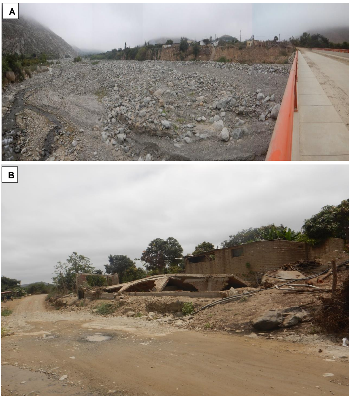
Figura 16. Zona crítica 02-079. Sector Tambar afectado por erosión fluvial y flujos de detritos, A) viviendas afectadas por la erosión fluvial, las cuales se encuentran asentadas sobre la margen izquierda del río Loco, B) Viviendas destruidas por el paso del flujo de detritos en el poblado Tambar.
