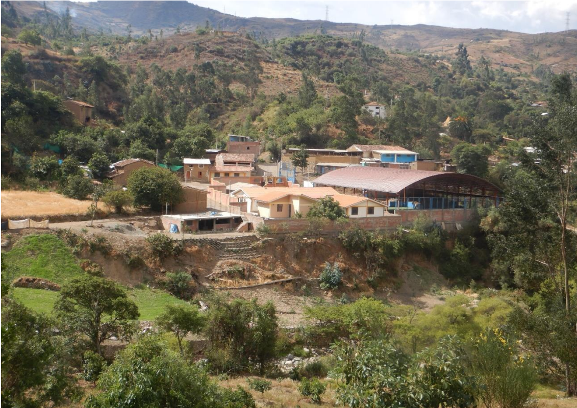
Fotografía 78. Zona crítica 02-094, Puesto de salud, loza deportiva y vivienda afectados por procesos de erosión fluvial que socaba la base del talud, en una longitud de 50 m, ubicado en la margen izquierda de la quebrada Santo Toribio.
