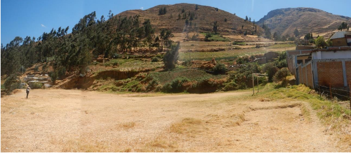
Fotografía 36. Zona crítica 02-014. I.E. Hermilio Valdizán (centro poblado Jirac) asentado dentro del cuerpo del deslizamiento rotacional.
