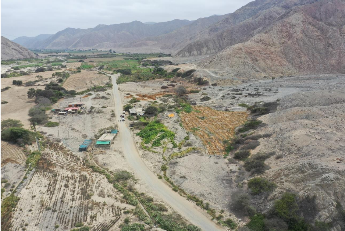
Fotografía 103. Zona crítica 02-134. El poblado de Turripampa el año 2017, durante el Fenómeno de El Niño, fue afectado por activación de la quebrada, afectando viviendas, terrenos de cultivo y vías de acceso.
