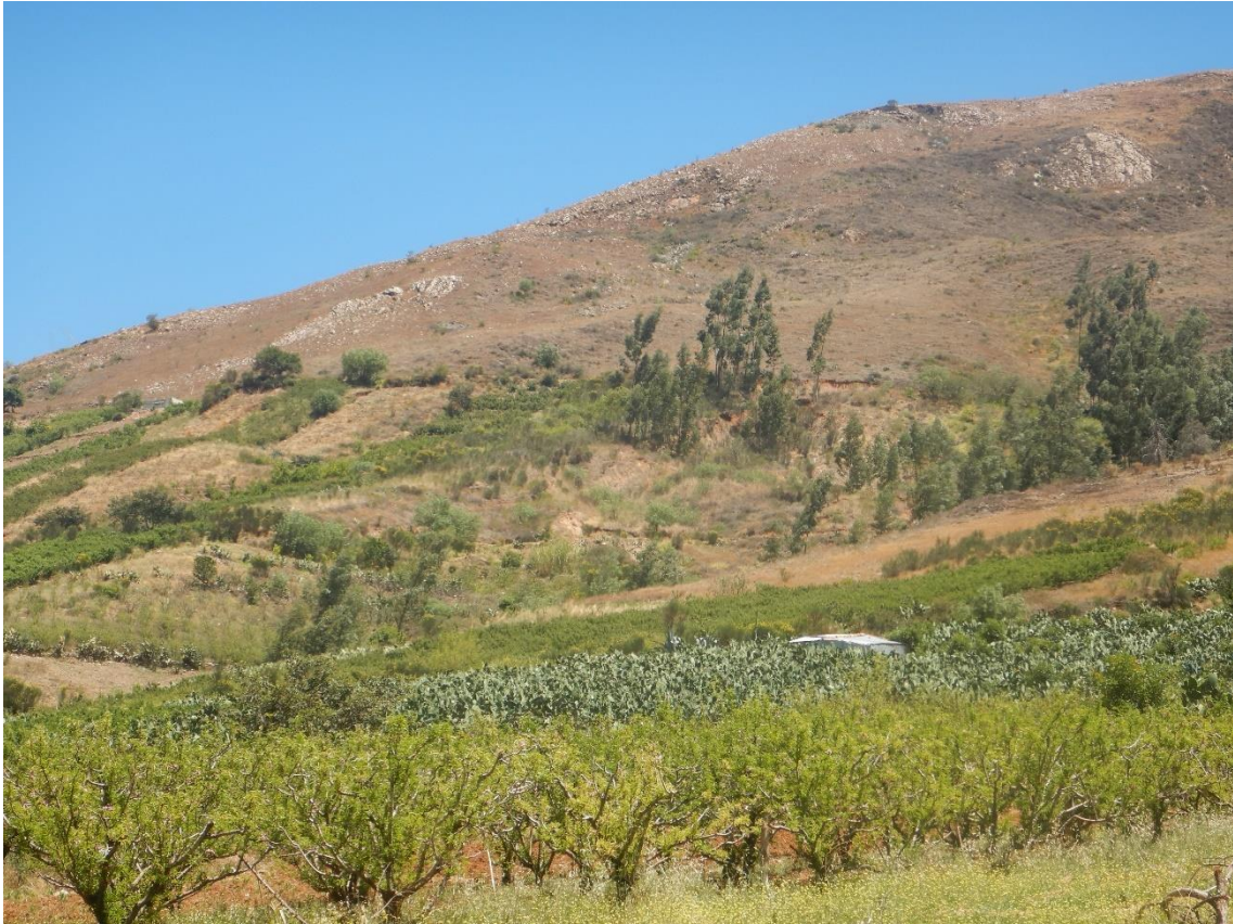
Fotografía 43. Zona crítica 02-027. Caserío Mishqui afectado por un deslizamiento rotacional, el cual podría reactivarse en temporada de lluvias y generar un flujo de detritos, canalizándose por la quebrada, lo que afectaría a las poblaciones asentadas aguas abajo. Coordenadas UTM: 8975549 / 207364 Zona 18. Tomada el 22-09-2023.
