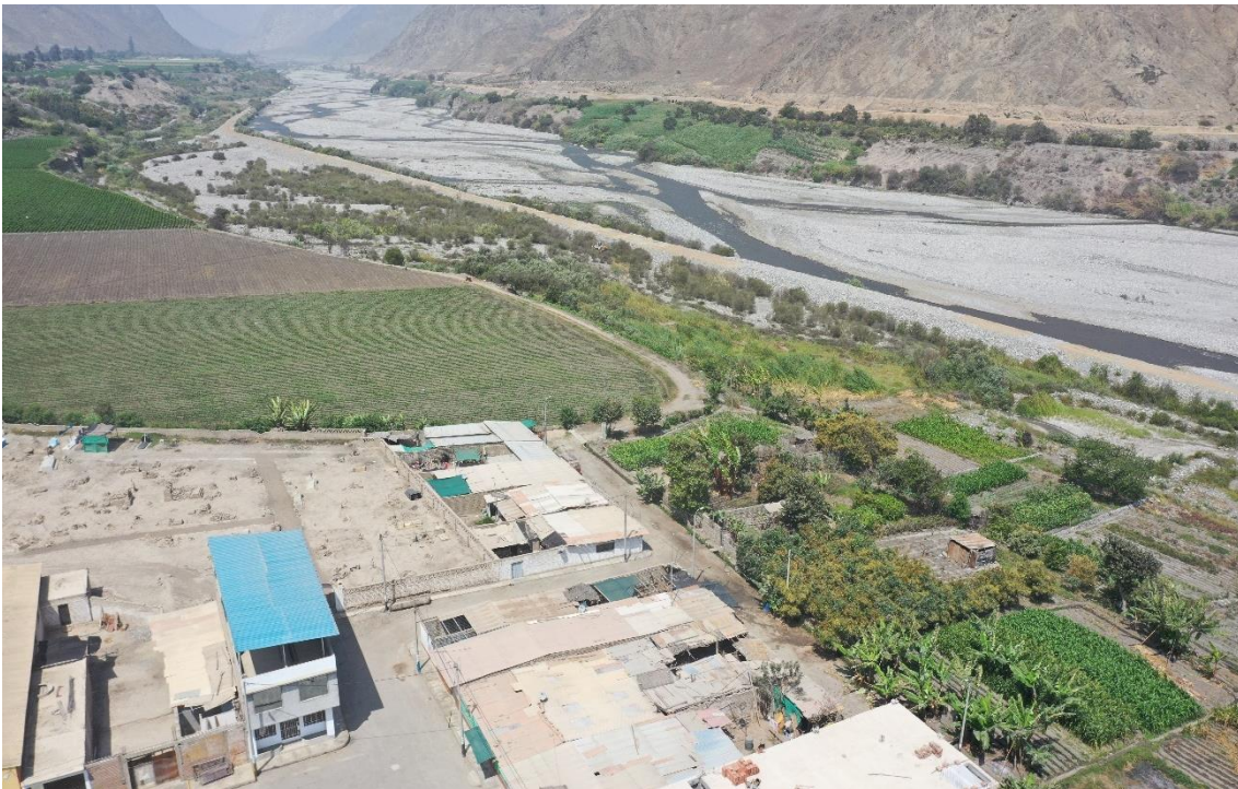
Fotografía 115. Zona crítica 02-149. Sector Cochas, asentado en la margen derecha del río Pativilca, sobre una terraza aluvial. En temporada de lluvias intensas es afectado por flujo de detritos y erosión fluvial. Coordenadas UTM: 8822317 / 222017, Zona 18 L. Tomada el 20-09-2023.
