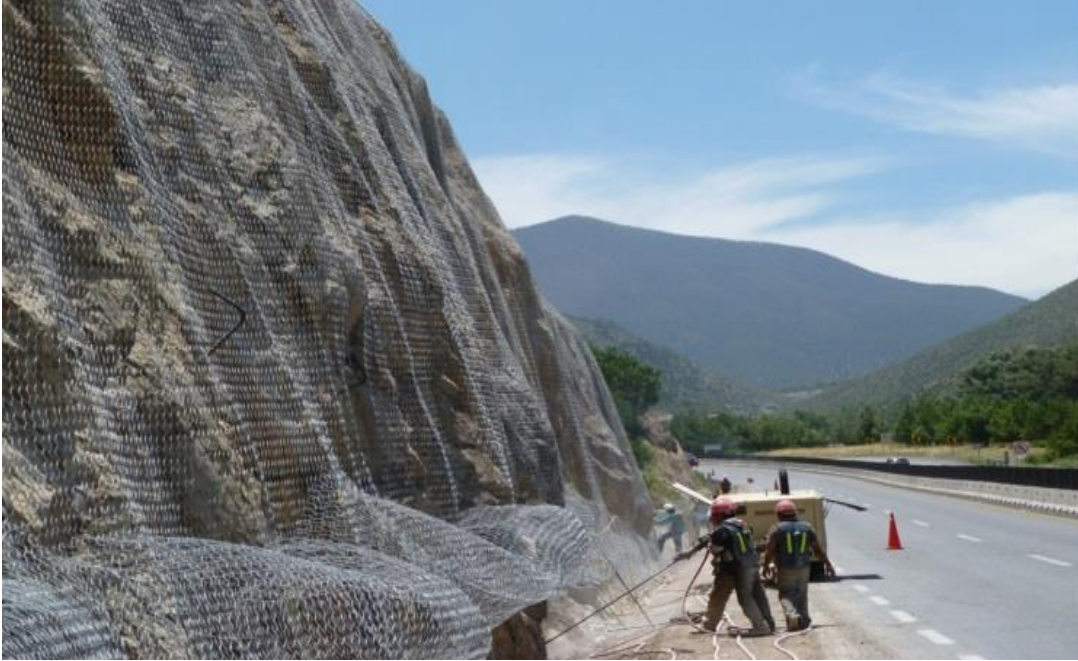
Fotografía 1. Mallas de protección con anclajes para caída de rocas o derrumbes tanto en detritos como roca alterada.
