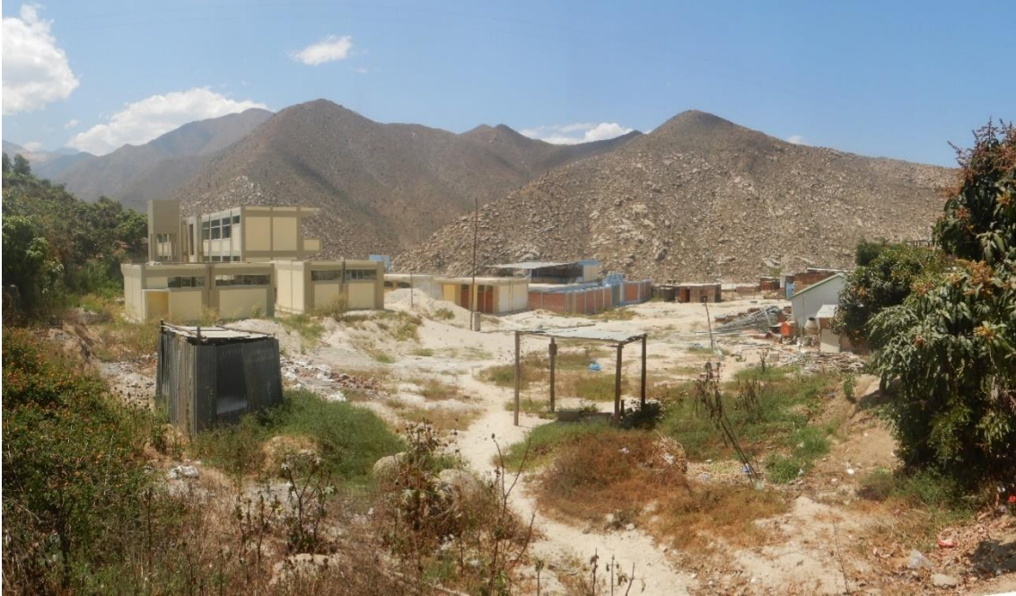
Fotografía 50. Zona crítica 02-036. El poblado Cerro El Castillo, afectada periódicamente por flujo de detritos afectando la escuela N° 88311 y colegio del poblado. Coordenadas UTM: 8950051 / 173066, Zona 18. Tomada el 23-09-2023.
