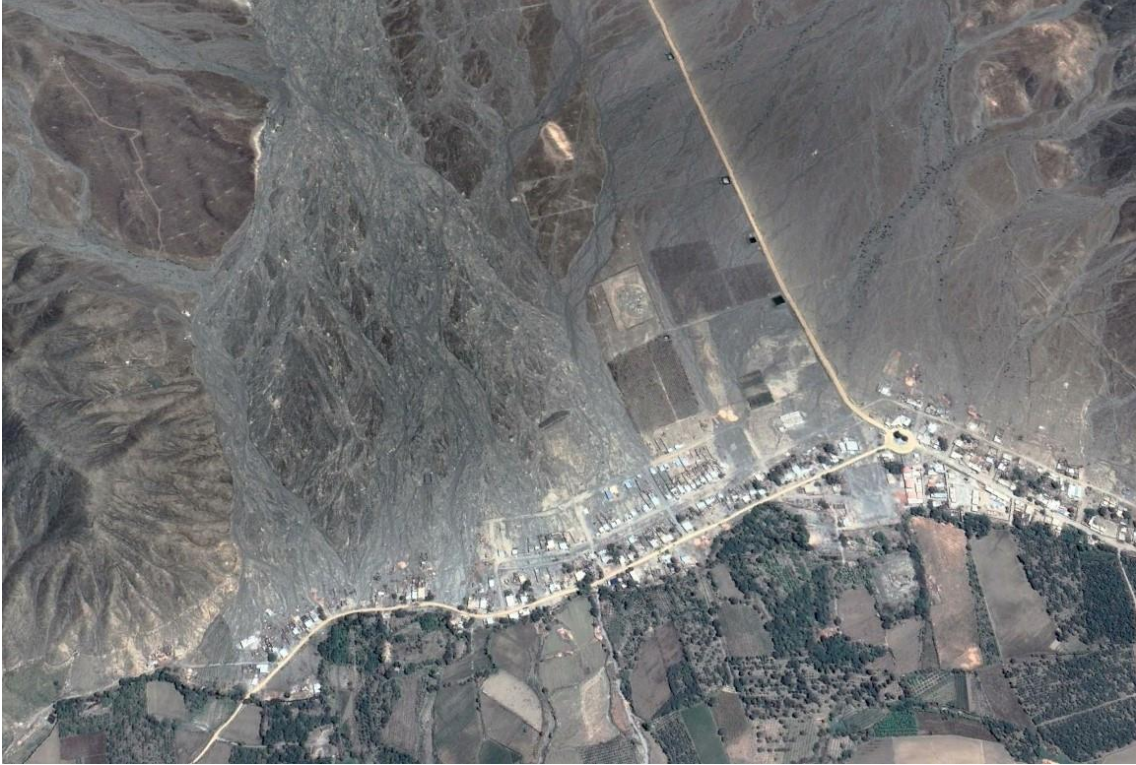
Figura 11. Zona crítica 02-038. Quebrada activada durante el ciclón Yaku en su paso por el sector Casa Blanca afectó más de 20 viviendas asentadas dentro del cauce de la quebrada. Coordenadas UTM: 894673 / 815541, Zona 17.
