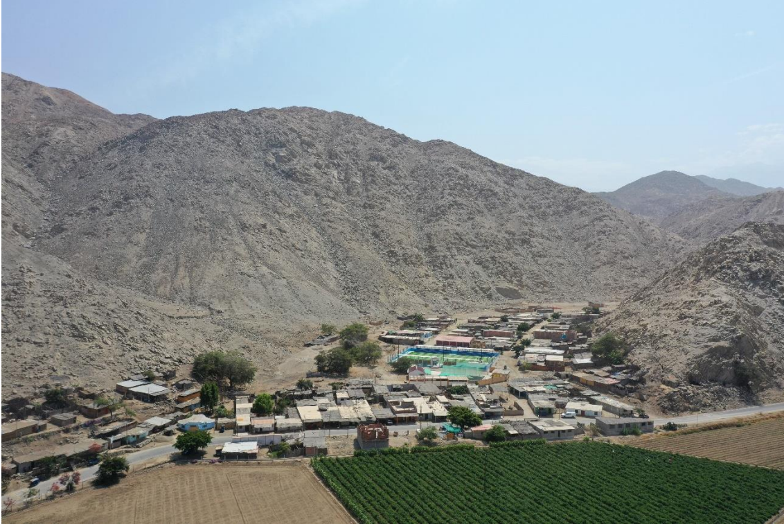
Fotografía 94. Zona crítica 02- 118. Sector Garlero asentado sobre una terraza proluvial, a la margen derecha del río Huarmey, es afectado por flujo de detritos. Coordenadas UTM: 8892417/ 177182, Zona 18 L. Tomado el 15-09-2023.
