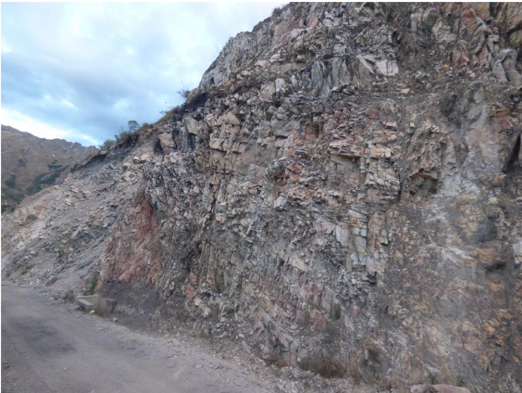
Fotografía 10. Areniscas cuarzosas muy fracturadas y meteorizadas de la Formación Casapalca.
