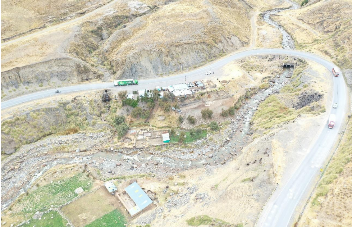
Fotografía 82. Zona crítica 02-104. Desembocadura de la quebrada Pachacoto (afluente al río Santa por la margen derecha), se observa procesos de erosión fluvial, a partir de la ocurrencia de flujo de detritos.
