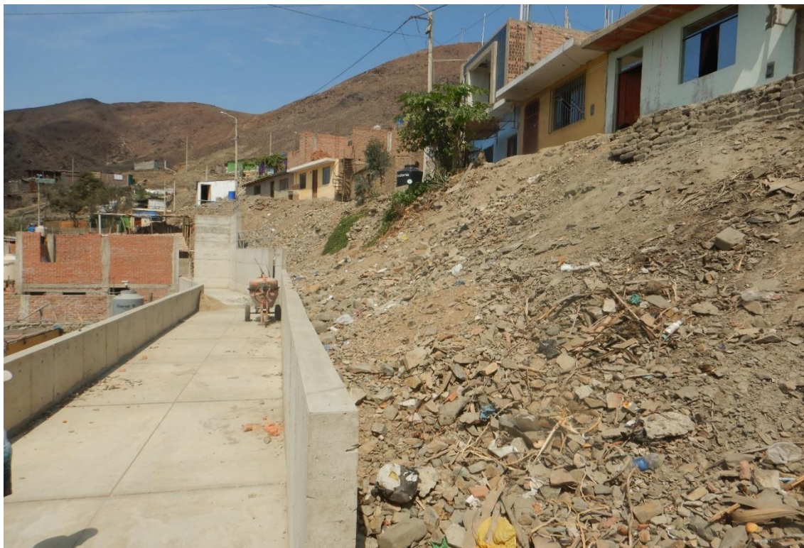
Fotografía 69. Zona crítica 02-072. Viviendas asentadas sobre laderas que son afectadas periódicamente por caída de rocas, en la parte alta se evidencia viviendas asentadas sobre pircas que son muy inestables.
