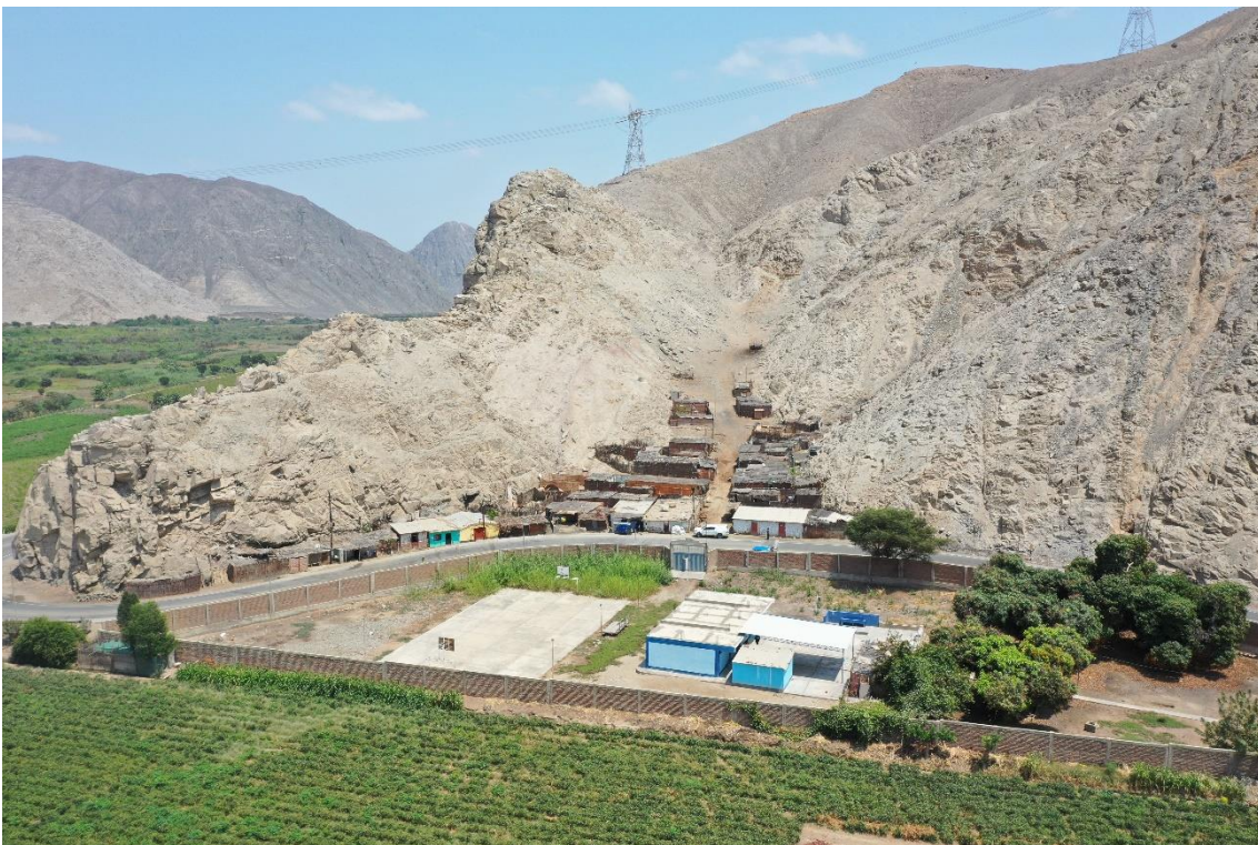
Fotografía 98. Zona crítica 02- 123. Chical, está ubicado en la desembocadura de una pequeña quebrada que no supera los 200 m de longitud desde su cabecera. Zona susceptible a caída de rocas y flujo de detritos.
