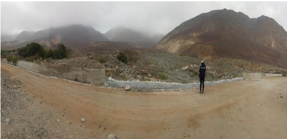
Fotografía 62. Zona crítica 02-059. Flujo de detritos de material heterogéneo, canalizado con 35% de bloques, 55% gravas y 10% de limos, forma un abanico, con el ciclón Yaku 2023 destruyó 20 m del canal Chinecas. Coordenadas UTM: 9029264 / 772428, Zona 17. Tomada el 02-09-2023.
