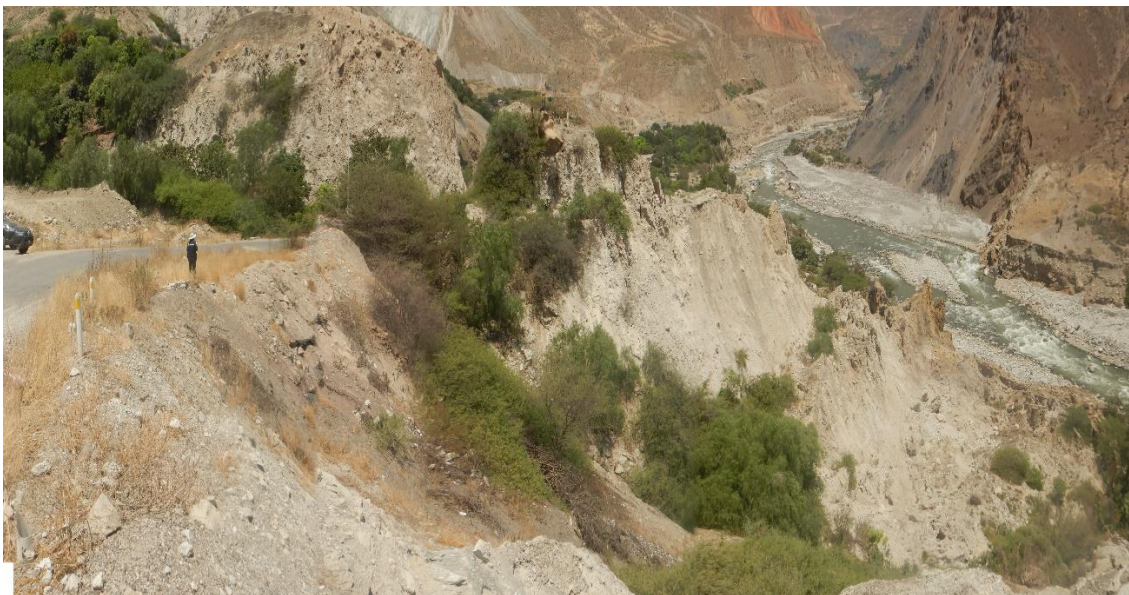
Fotografía 58. Zona crítica 02-052. Aguas abajo de la quebrada en confluencia con el río Santa ocurre procesos de erosión fluvial en ambas márgenes, en especial la margen izquierda, en el retroceso podría afectar la carretera Yuracmarca - Yungay pampa. Coordenadas UTM: 9030635 / 181906, Zona 18. Tomada el 14-09-2023.
