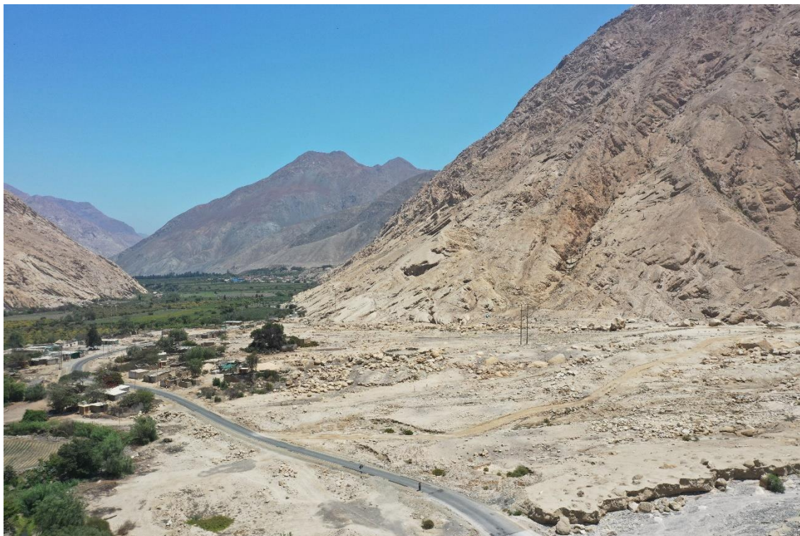
Fotografía 111. Zona crítica 02-144. Sector La Florida asentada sobre un abanico proluvial, es afectada por constantes flujo de detritos que descienden de la quebrada Llamachupan. Coordenadas UTM: 8826845 / 236434, Zona 18 L. Tomado el 18-09-2023.
