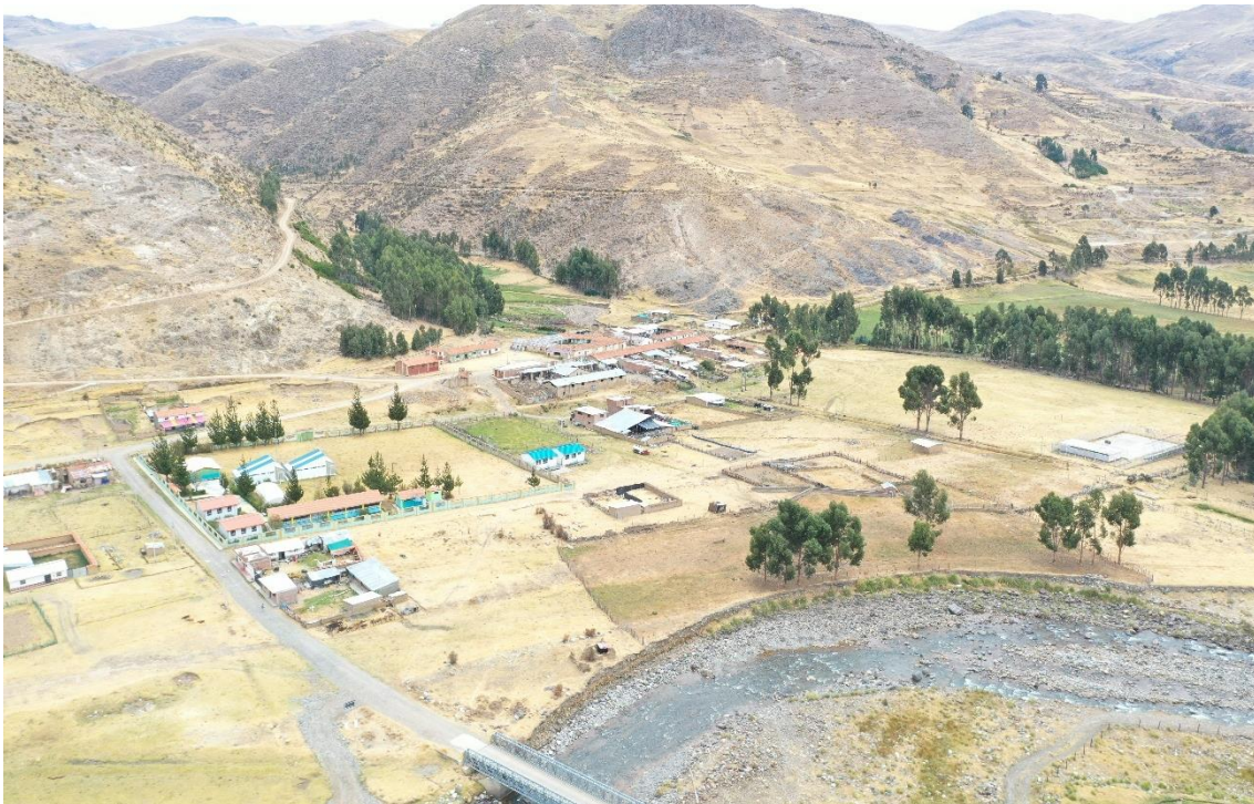
Fotografía 83. Zona crítica 02-105. Vista del sector Utcuyacu, asentado sobre depósitos proluviales, acumulado por flujo de detritos antiguos. Asimismo, se evidencia procesos de erosión fluvial en ambas márgenes del río Santa, además registros pasados indican inundaciones en las terrazas aluviales, produciendo la pérdida de áreas de cultivo.
