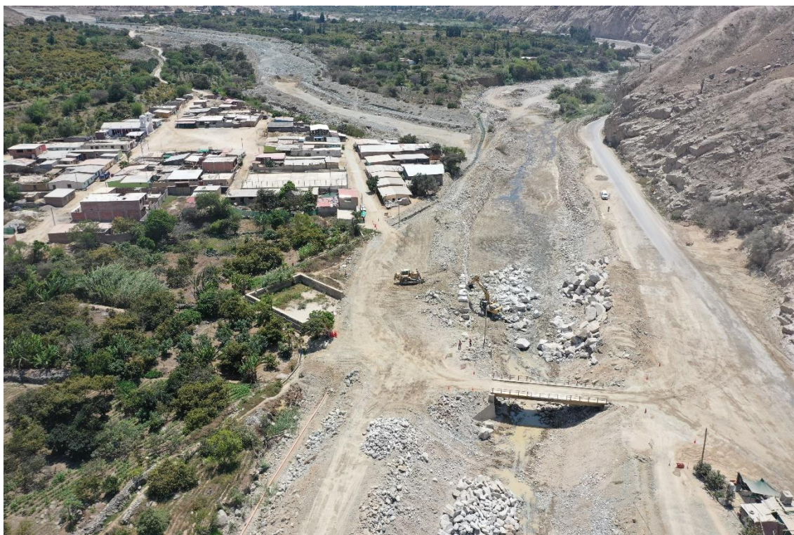
Fotografía 89. Zona crítica 02-112. Vista del poblado de Huaquish asentado sobre un depósito proluvio aluvial, propenso a ser afectado ante la ocurrencia de un flujo de detritos proveniente del río Fortaleza.
