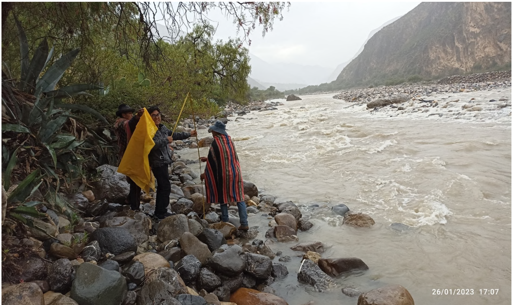
FIGURA N° 03 ALTURA DEL TALUD DE 2.50 m - 4.0 m PROMEDIO
