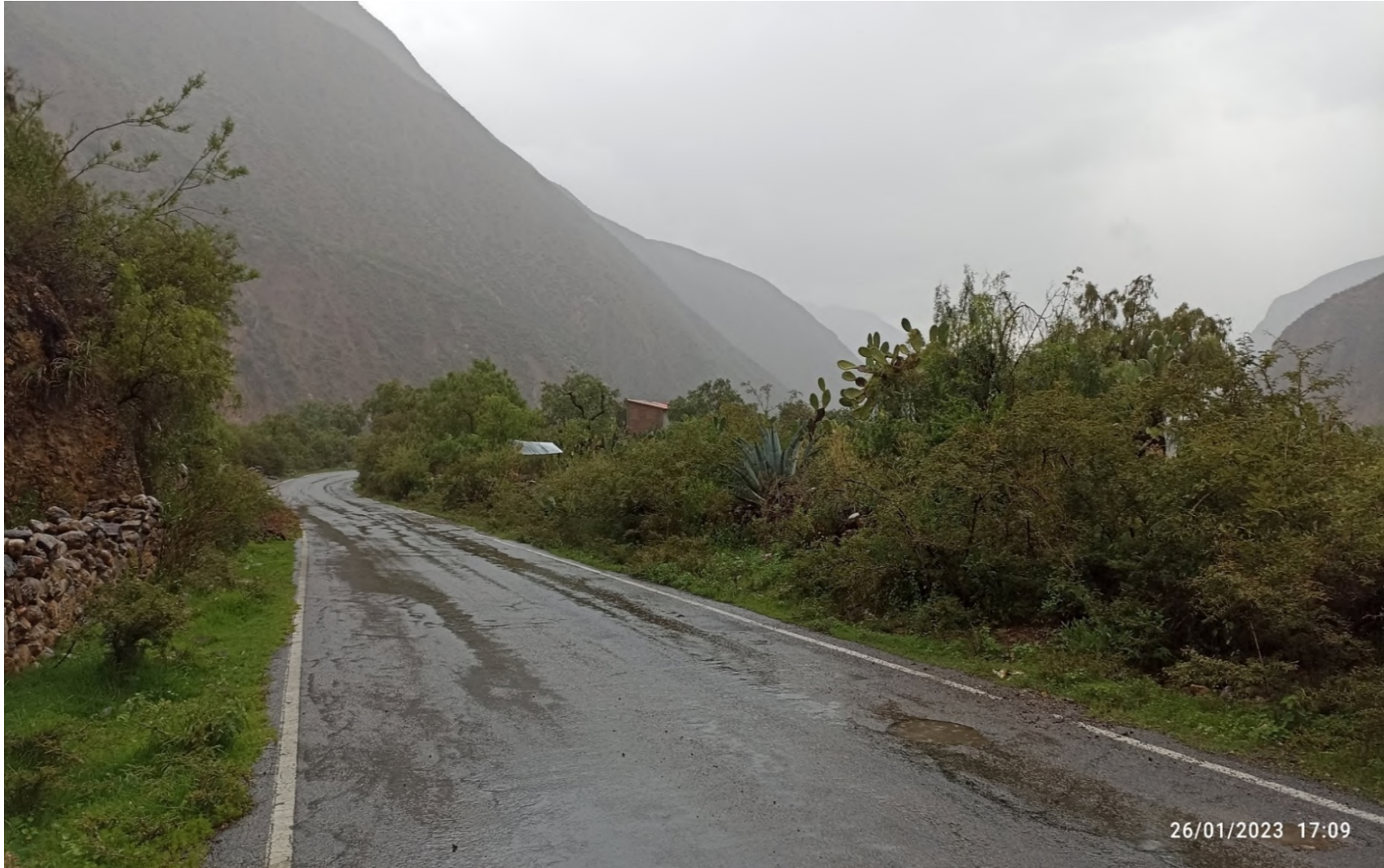
FIGURA N°02: CARRETERA AYACUCHO - PROV HUANCASANCOS EXPUESTOS ANTE UNA CRECIDA Y DESBORDE DEL RÍO CARACHA EN LA MARGEN IZQUIERDA ASI COMO LA POBLACIÓN DE LA LOCALIDAD DE TINCCOC
