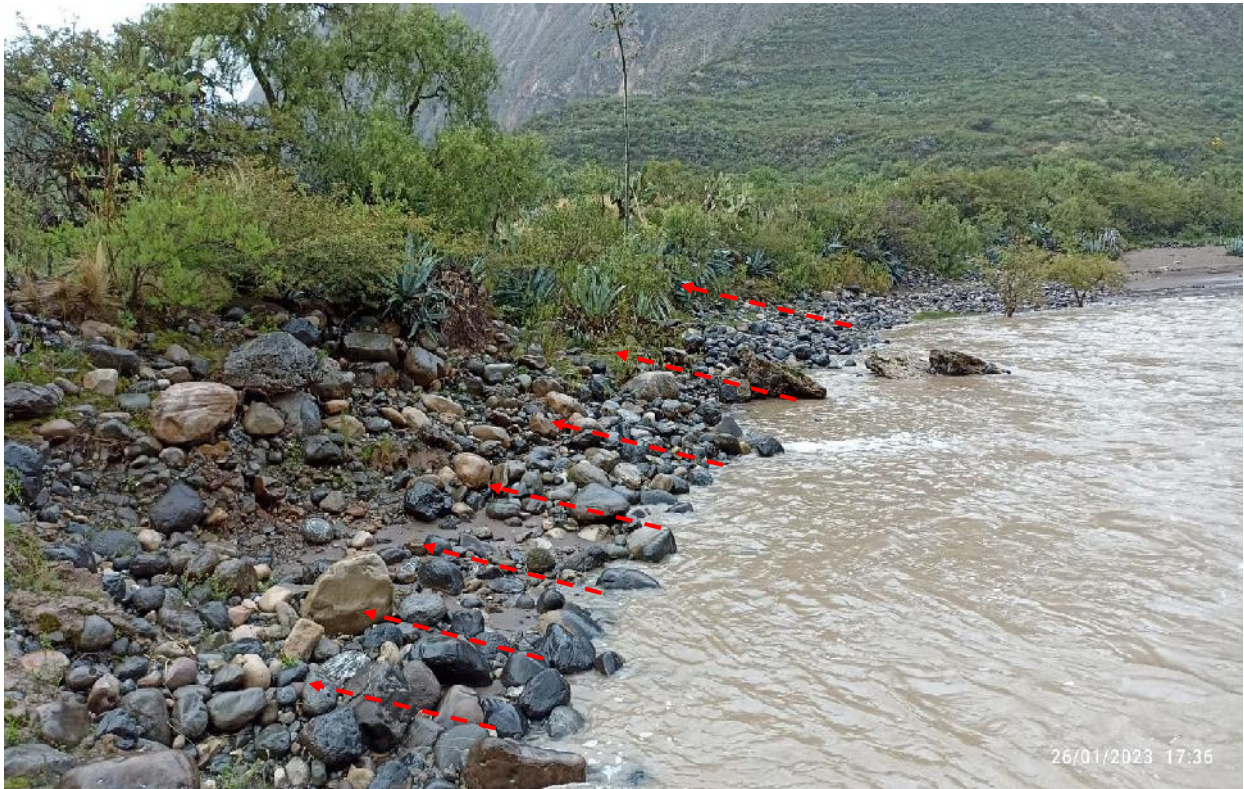
FIGURA N°02 AREAS AGRICOLAS Y VIVIENDAS EXPUESTOS ANTE UNA CRECIDA Y DESBORDE DEL RÍO PAMPAS EN LA MARGEN DERECHO
