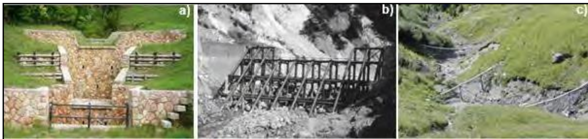
Figura 27. Presas tipo SABO de sedimentación escalonada para controlar la fuerza destructiva de los huacos, a) de control; b) tipo rejilla; c) barras flexibles, (Vilches, 2021)
