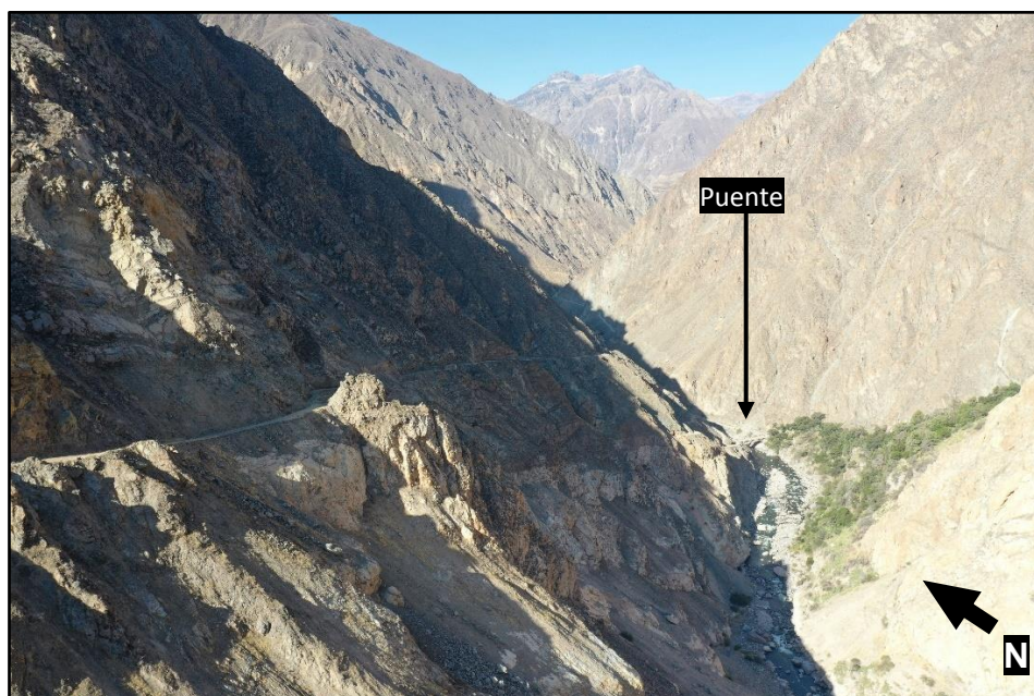
Figura 25. Zona de caída de rocas, carretera de acceso a Choco, margen derecha del río Colca.
