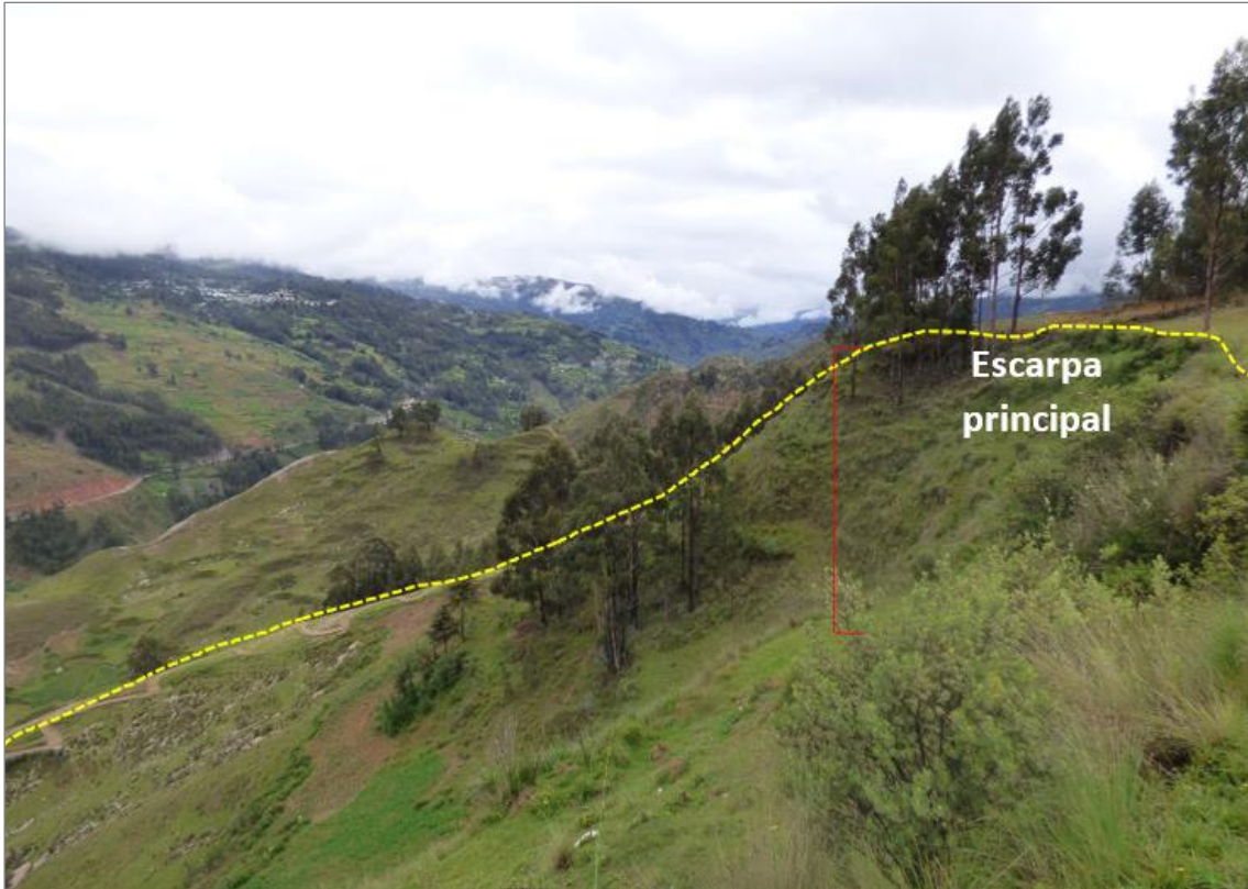
Figura 15. Vista de la escarpa principal del deslizamiento A.
