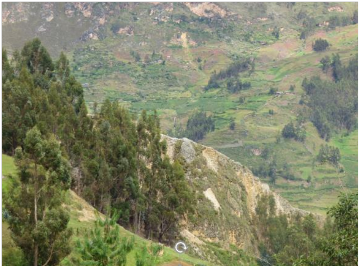
Fotografía 2. Afloramientos de conglomerados cerca al sector 1, donde se desarrolla el deslizamiento "B".
