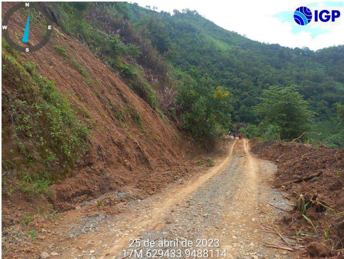
Figura 20.- Depósito coluvial conformado por materiales sueltos (arenas, limos y arcillas) que han sido depositados sobre la ladera y parte de la vía de acceso hacia quebrada La Loja
