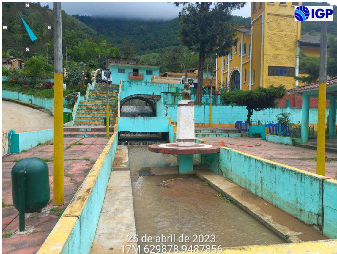
Figura 33.- Encauzamiento de la quebrada La Loja en las inmediaciones de la plaza de Montero que podría ser afectada por flujos de lodo
