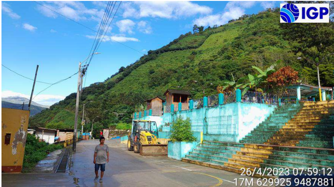
Figura 3.- Terraza aluvial sobre la que asienta la localidad de Montero
