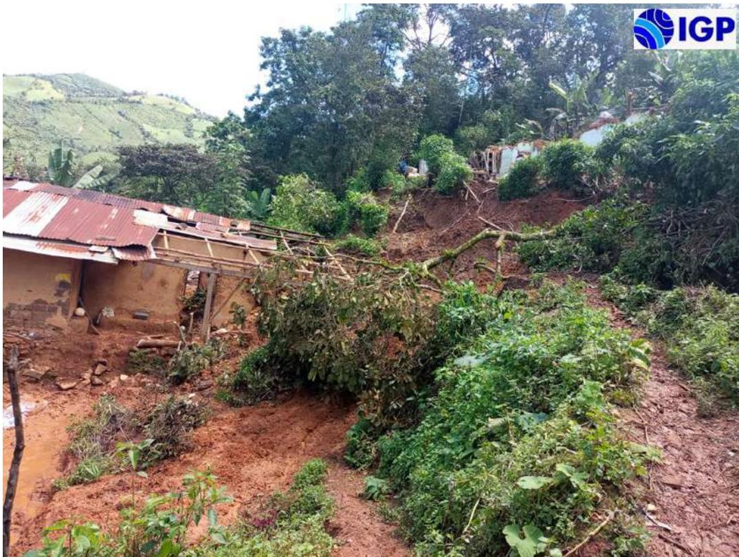
Figura 37.- Derrumbe ocurrido en el sector Anexo San José de Pite que afectó viviendas.
