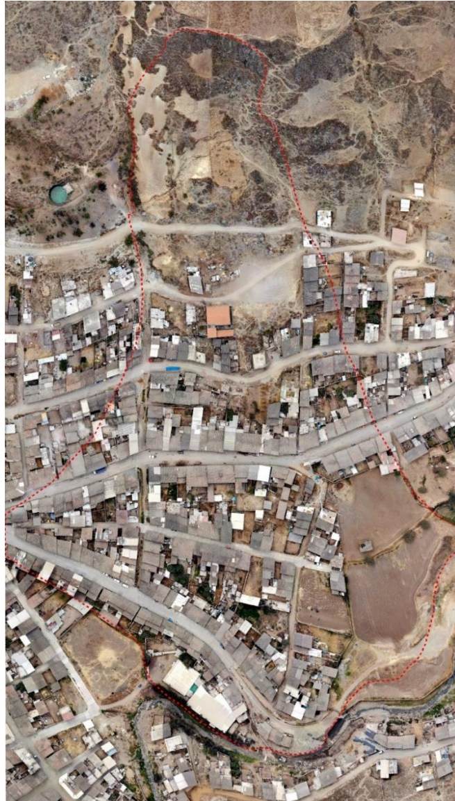
Figura 5. Delimitado con líneas discontinuas de color rojo se observa el movimiento complejo tipo deslizamiento-flujo reactivado.
