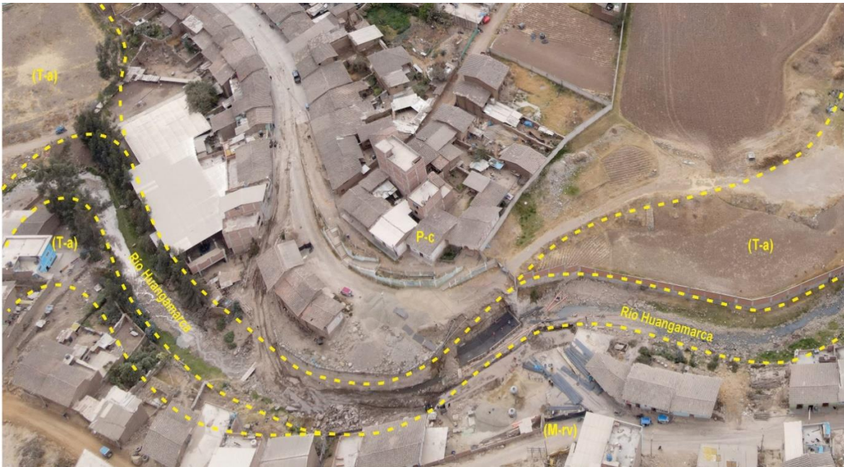
Figura 4. Se observa las subunidades distribuidas en las márgenes del río Huangamarca: terraza aluvial (Ta), piedemonte deluvial (P-d), principalmente.
