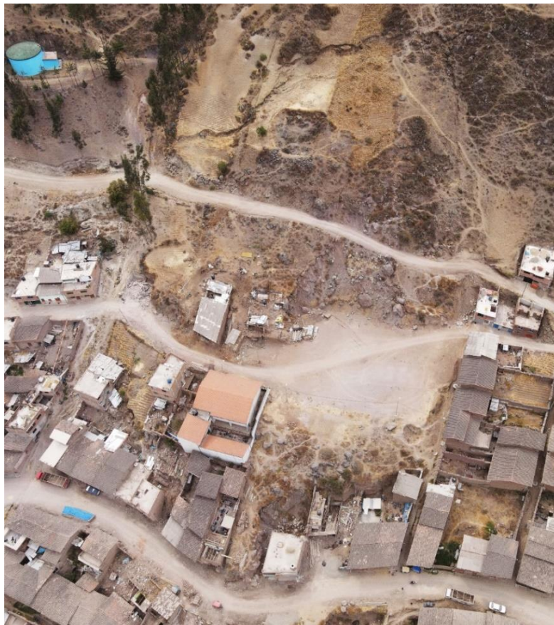
Fotografía 5. Vista panorámica de los cortes realizados en la ladera para la construcción de accesos y viviendas UTM: 769021 / 9125984, Zona 17.
