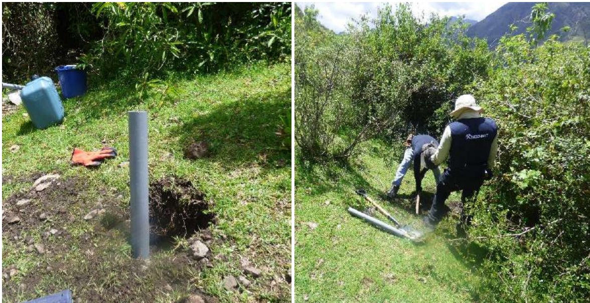
Figura 10. a) Instalación de tubería. b) Esquema del ensayo.
