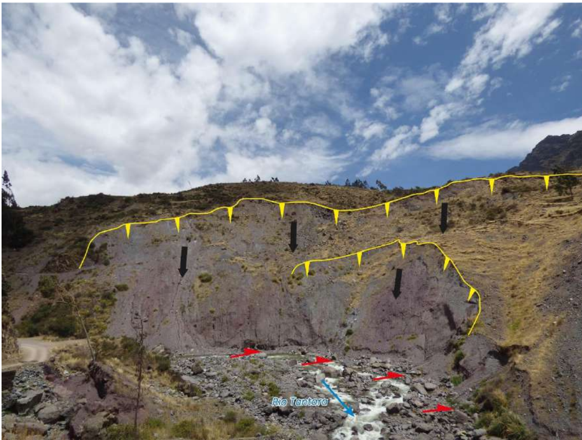
Figura 14. Derrumbes al pie del deslizamiento (líneas amarillas) reactivados debido a la acción erosiva del río Tantara (flechas rojas) que viene socavando la base del talud.
