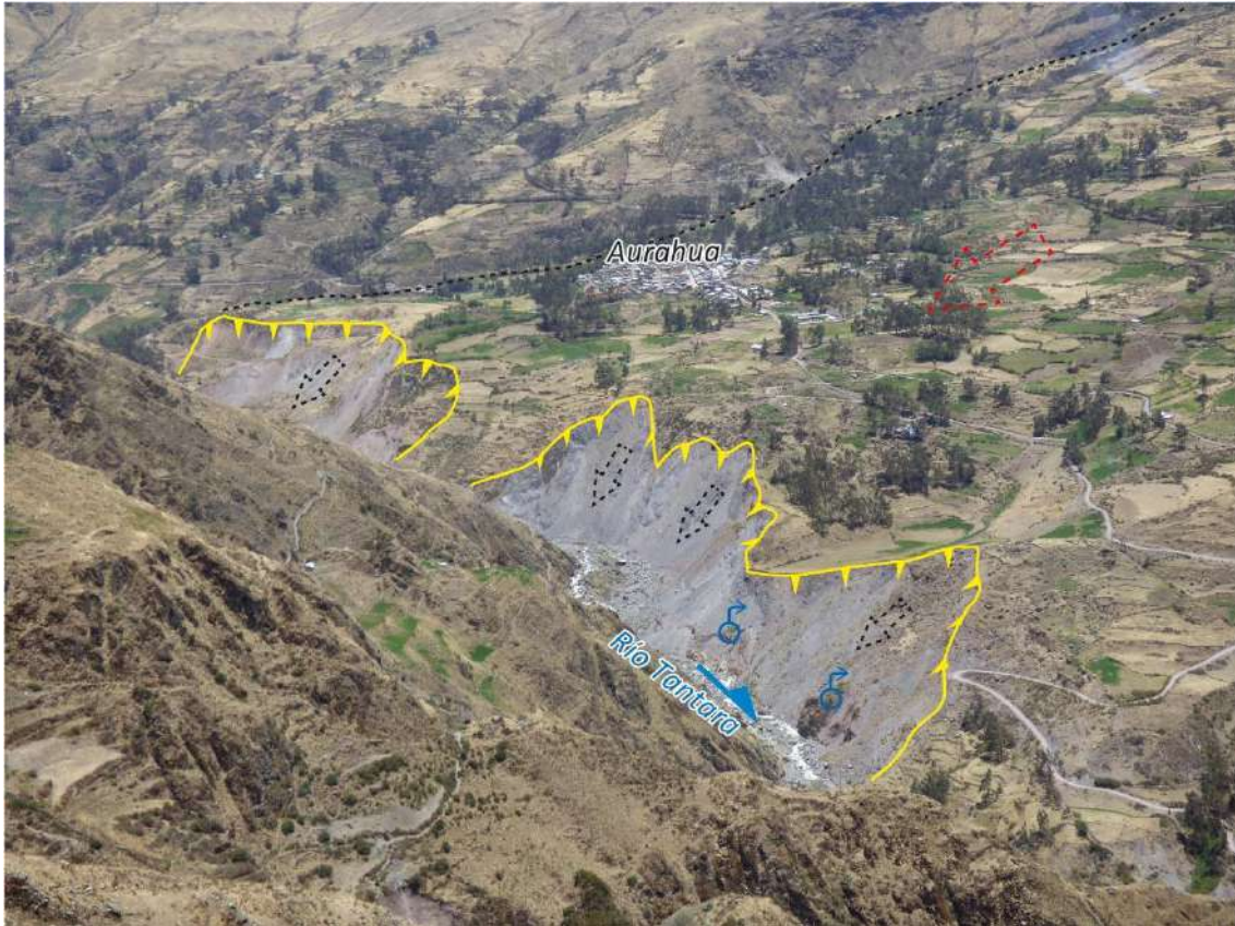
Figura 11. Reactivaciones en la base del deslizamiento Aurahúa, donde influye el tipo de material, la presencia de surgencias de agua en el talud y la acción erosiva del río Tantara.
