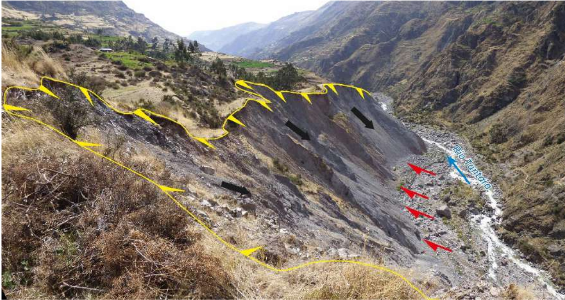
Figura 13. Derrumbes al pie del deslizamiento Aurahuá. Las líneas amarillas indican el escarpe con un movimiento retrogresivo, hacia el pie del talud se observa el socavamiento y erosión (flechas rojas) generada por el río Tantara.
