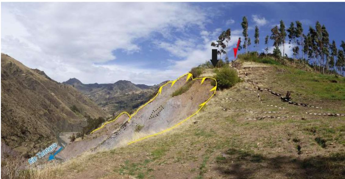
Figura 12. Reactivación en el pie del deslizamiento, el derrumbe debido a un proceso retrogresivo. Las líneas punteadas de color blanco, vienen a ser las grietas tensionales detrás del escarpe del derrumbe.
