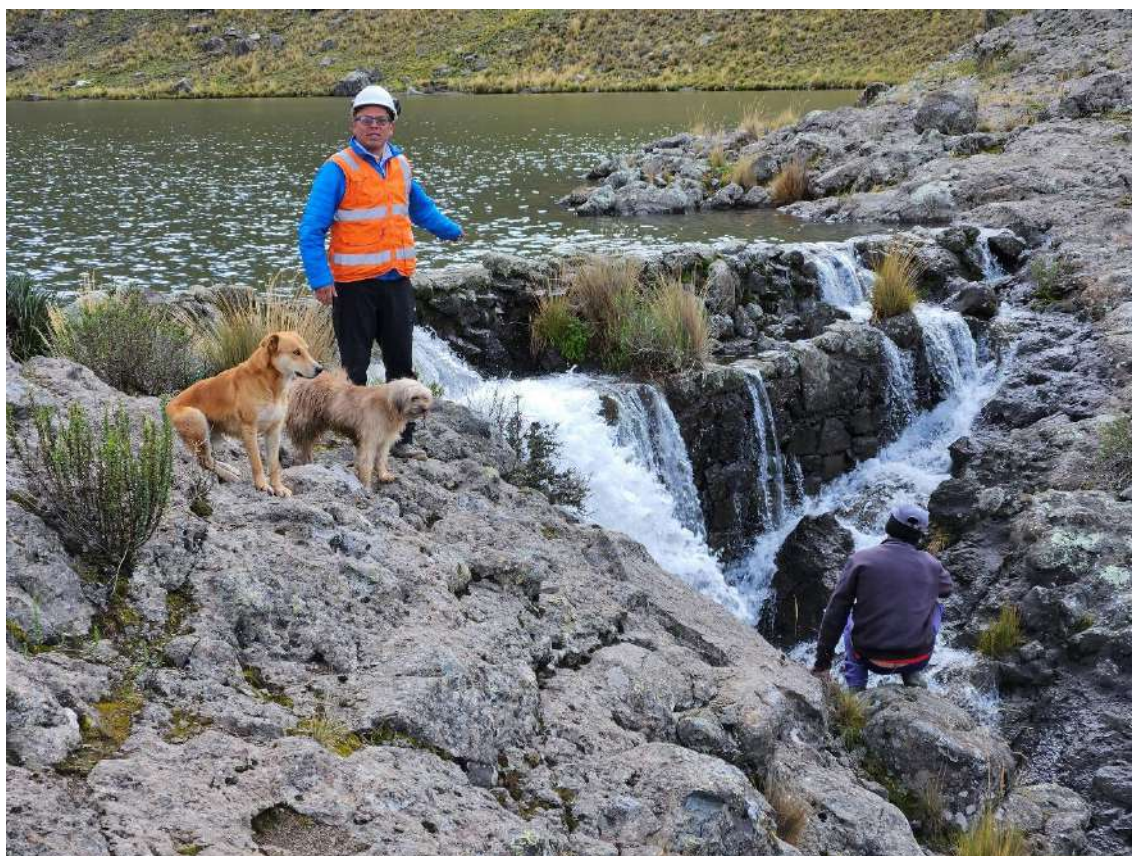
Figura N° 13: Sobrevertimiento y filtraciones de la presa Urcuncocha.
