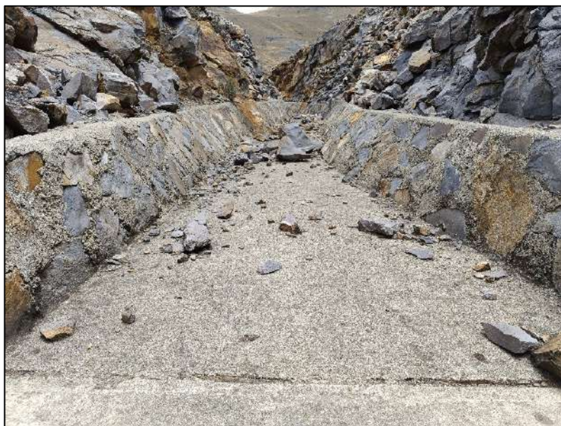
Fotografía N° 28: Vista de la entrada al canal de aliviadero
