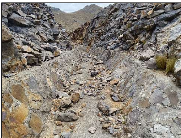
Fotografía N° 25: Vista del canal del aliviadero.
