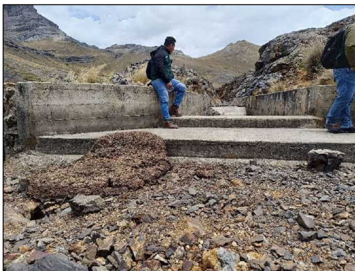
Fotografía N° 26: Vista de la entrada del aliviadero y el aforado que se ubica cerca del canal.
