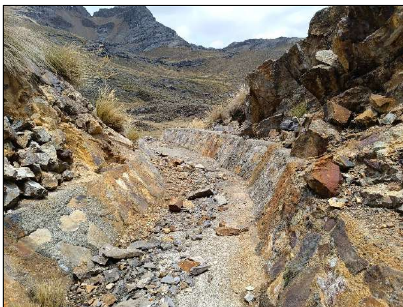
Fotografía N° 29: Vista del final del canal de aliviadero
