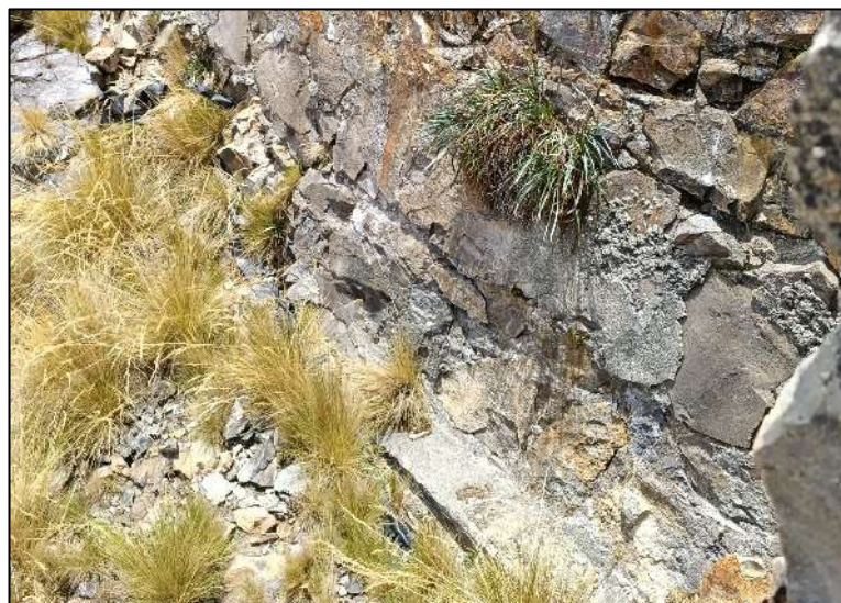
Fotografía N° 21: Vista de contacto pres-cimiento de lado derecho.
