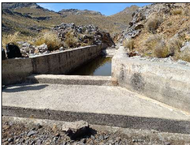
Fotografía N° 24: Vista de la entrada del aliviadero.
