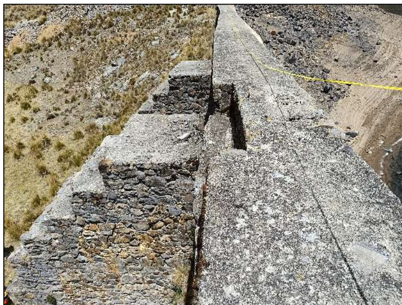
Fotografía N° 03: Vista de la corona desde la margen izquierda.
