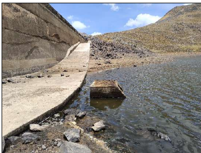
Fotografía N° 23: Vista de la entrada de la toma, agua arriba.
