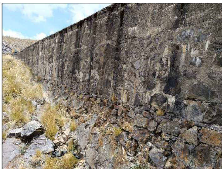
Fotografía N° 17 Fisuras y coloración cerca del cimiento, encontradas en la margen derecha.
