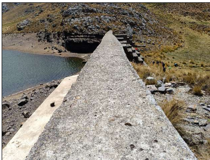
Fotografía N° 02: Vista de la corona desde la margen derecha.
