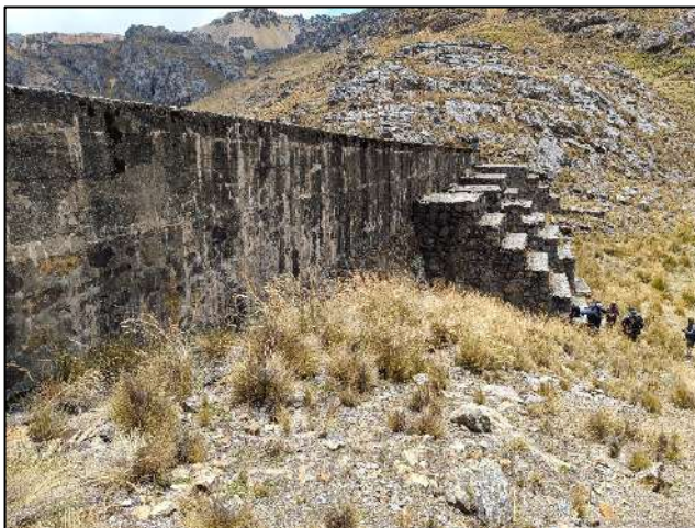
Fotografía N° 14: Vista desde la margen derecha, aguas abajo.
