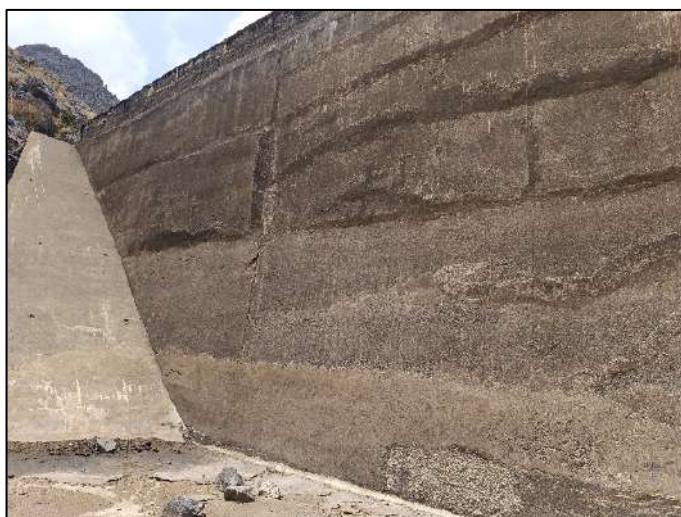
Fotografía N° 09: Vista aguas arriba de la presa desde la parte central.
