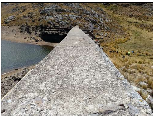
Fotografía N° 06: Fisuras encontradas en la parte central y derecha.
