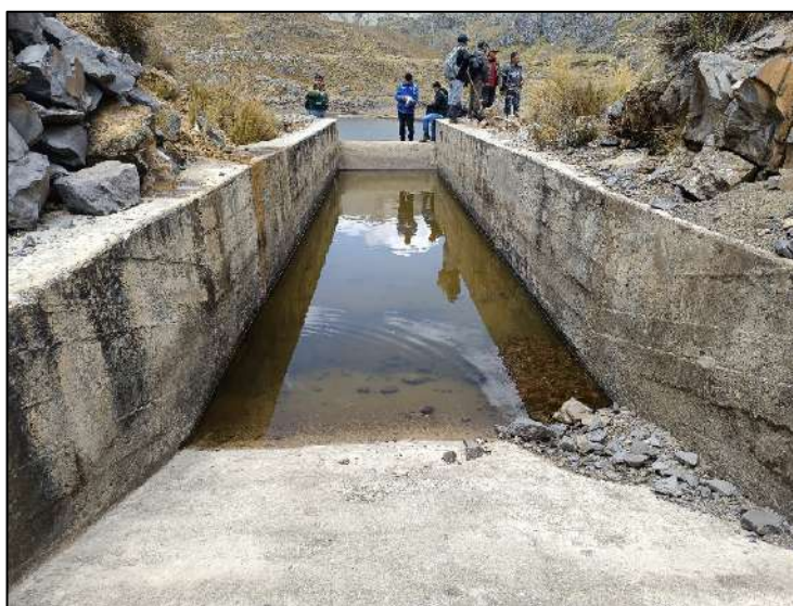
Fotografía N° 27: Vista de la poza disipadora del canal.
