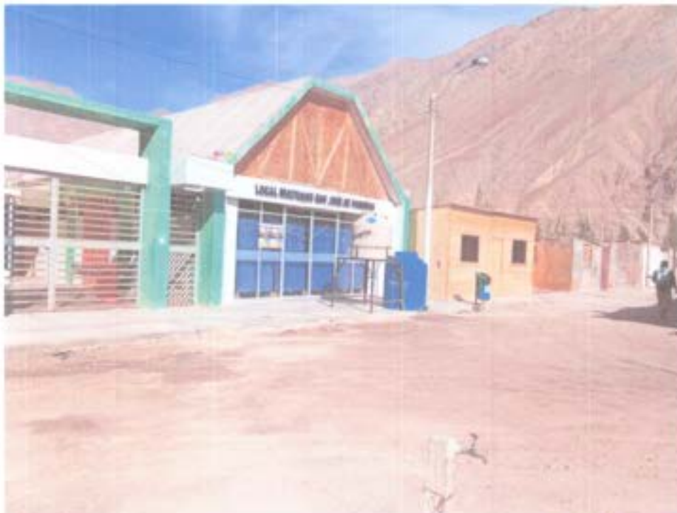
Fotografía 11 Trabajo de campo, local multiusos de concreto armado en San José de Poquera
