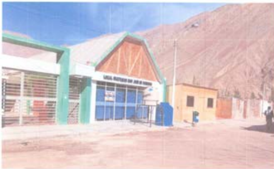
Fotografía 19 Red pública de alumbrado, en San José de Poquera
