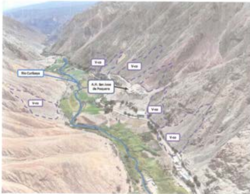
Fotografía 51 Vista de las vertientes Coluviales (V-co), en inmediaciones de la zona urbana del Anexo Poquera.
