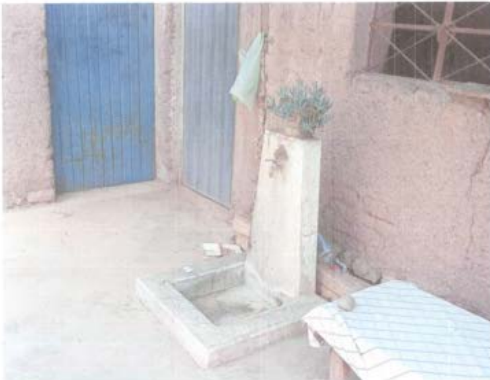
Fotografía 12 Pilón de agua para las viviendas ubicadas en la carretera a Curibaya.
