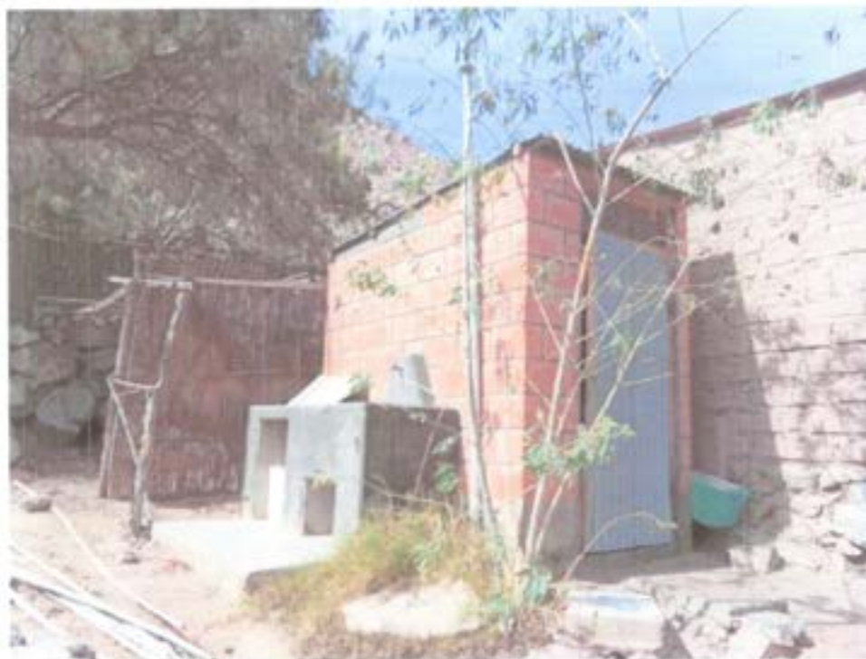
Fotografía 14 Pozo ciego/negro (letrina), ubicado en viviendas ubicadas en la carretera a Curibaya.
