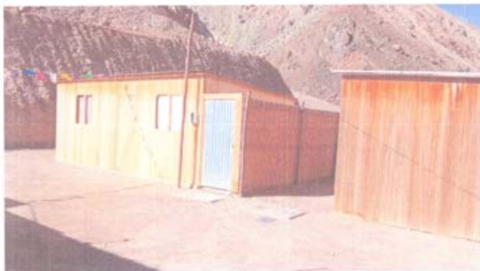
Fotografía 15 Viviendas en San José de Poquera con cajas de desagüe
