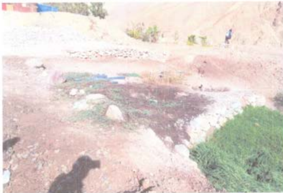
Fotografía 17 Red de alcantarillado conectado a biodigestores en San José de Poquera
