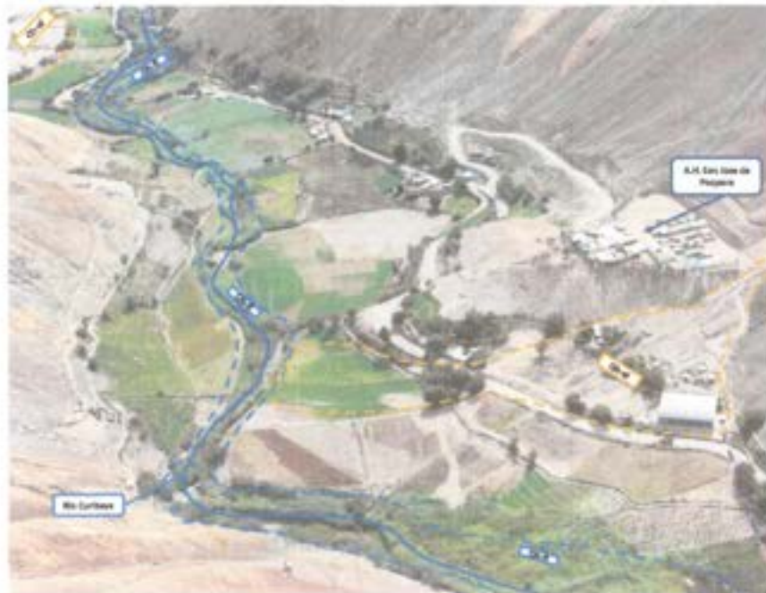
Fotografía 35 Vista área de los depósitos aluviales (Qh-al) depositados en la parte baja del A.H. San Jose de Poquera
