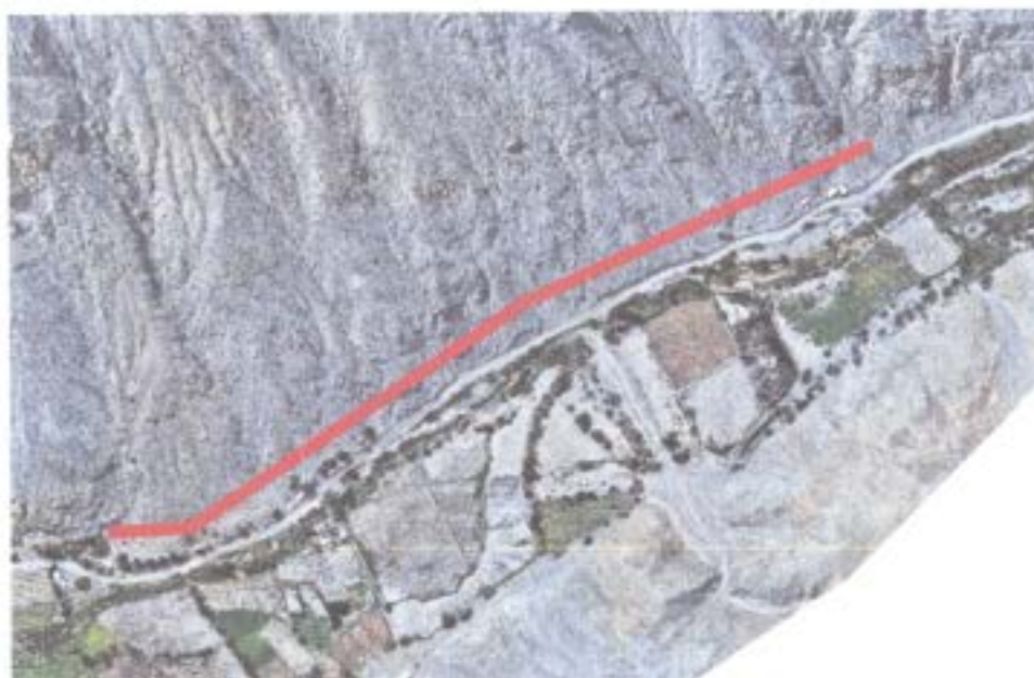
Fotografía 64 Zona afectada entre los lotes 2 y 11 en la carretera a Curibaya.
