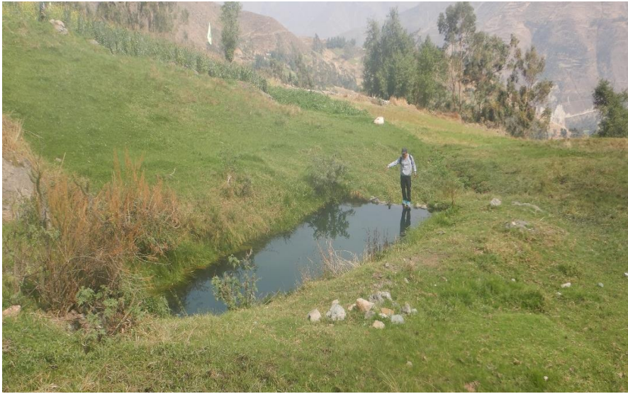
Fotografía 2. Vista de reservorio sobrecargados, que generan escurrimiento de agua en dirección norte.
