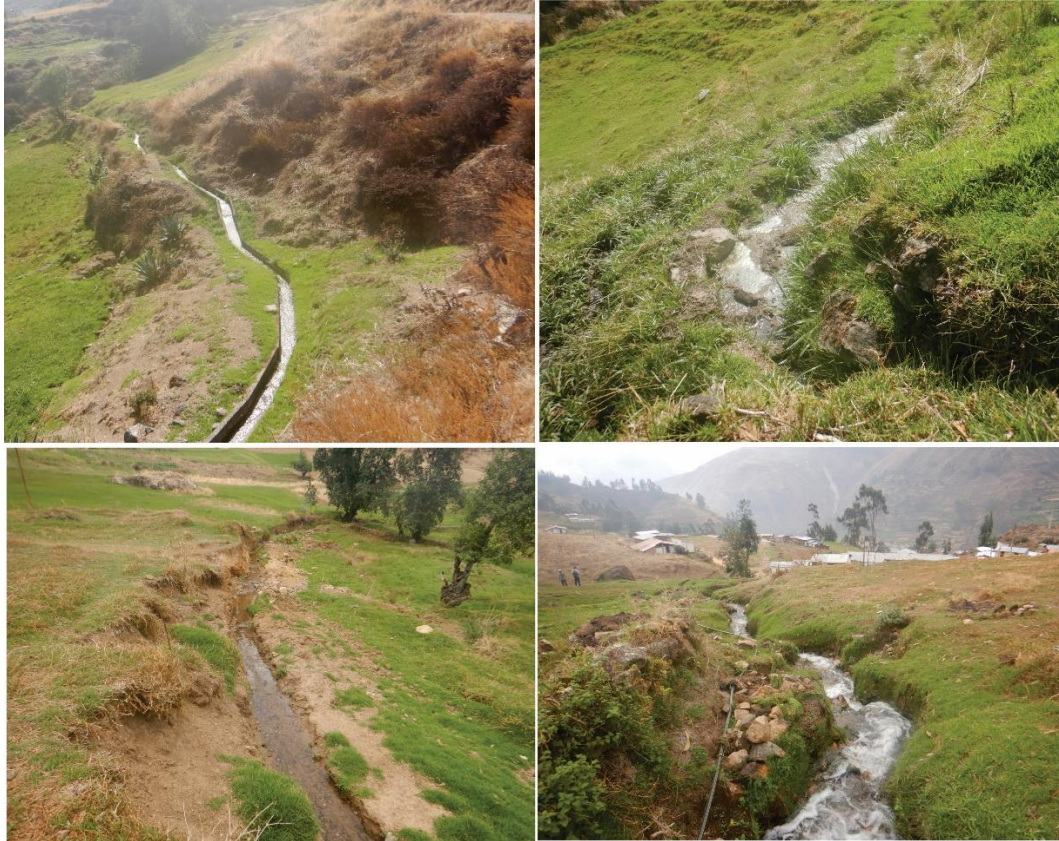
Figura 23. Vista de canales de riego, se identificaron algunas con revestimiento y otras no cuentan con revestimiento.
