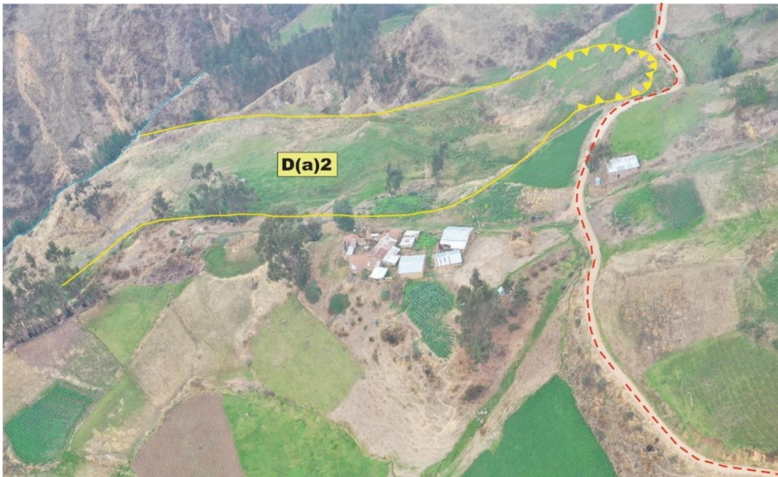
Figura 20. Vista con dirección noreste desde la plaza de Pichuta, donde se aprecia el deslizamiento de tipo rotacional próximos a la quebrada Colpa cucho.
