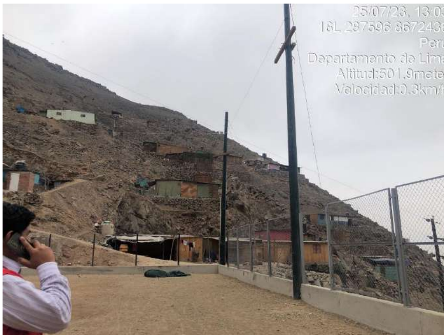
Zona crítica ante caída de rocas en Asociación Santa Rosa
