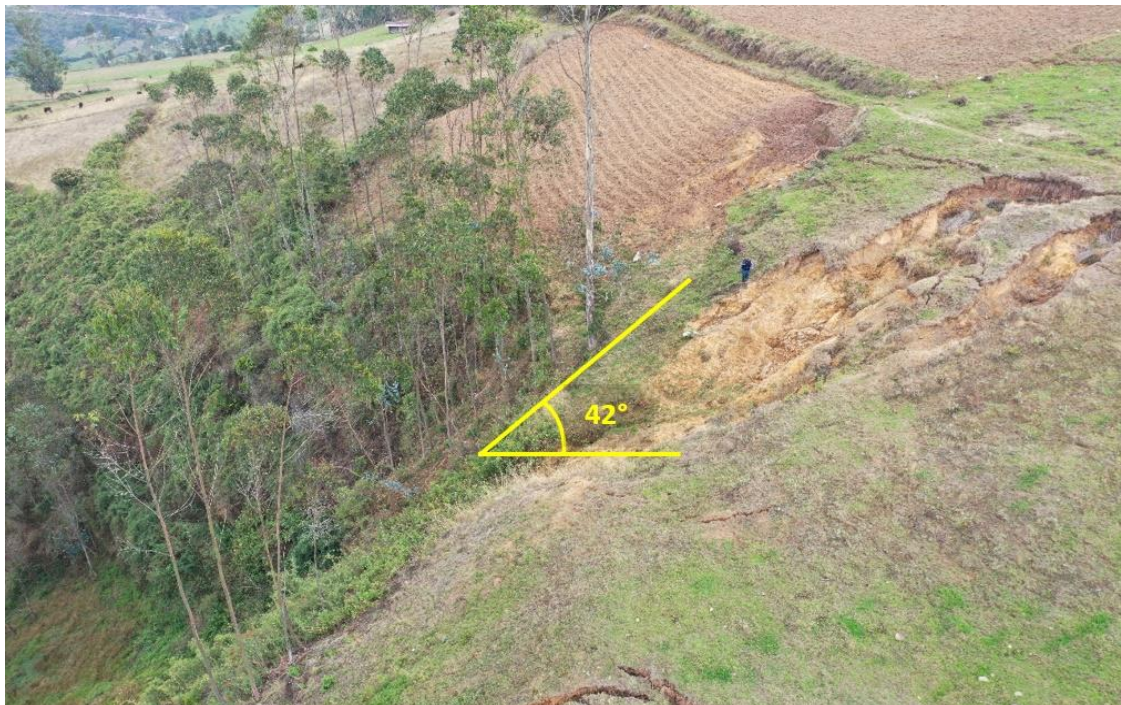
Figura 3. Deslizamiento se origina en laderas con pendiente muy fuerte ( 25^\circ a 45^\circ ).
