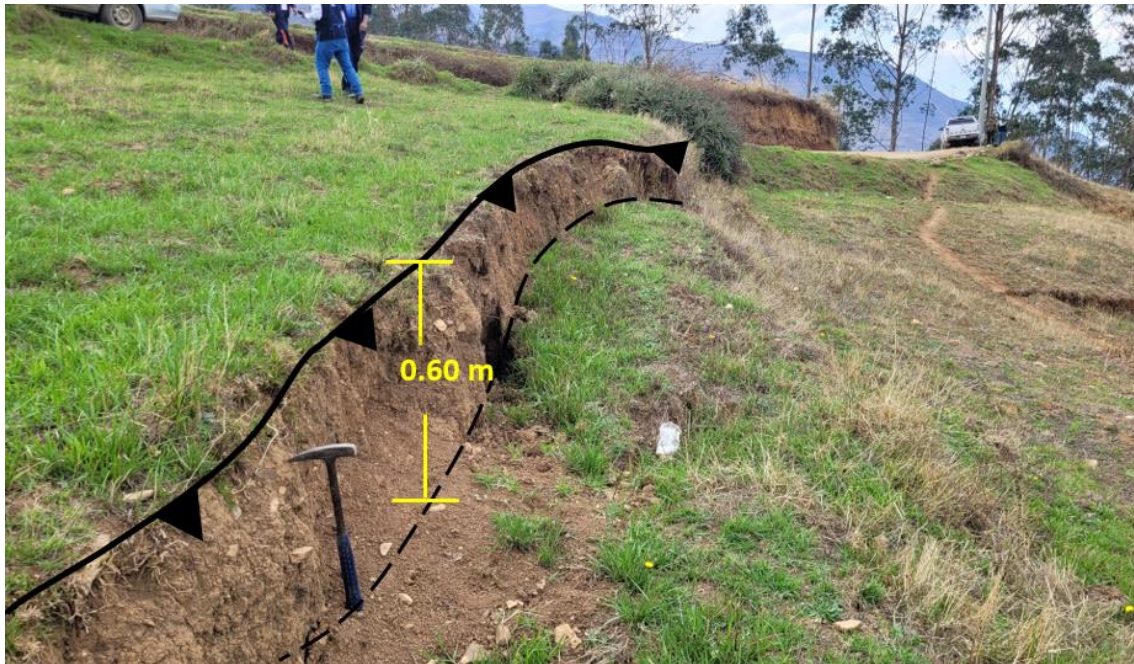
Figura 8. Escarpe secundario, con un salto vertical de 0.60 m.
