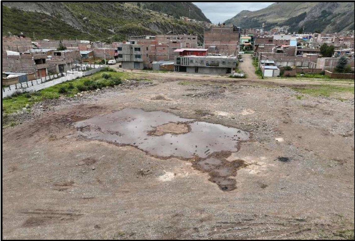
Fotografía N° 3: se evidencia acumulación de agua debido a que se encuentra montículos de materiales excedentes.
