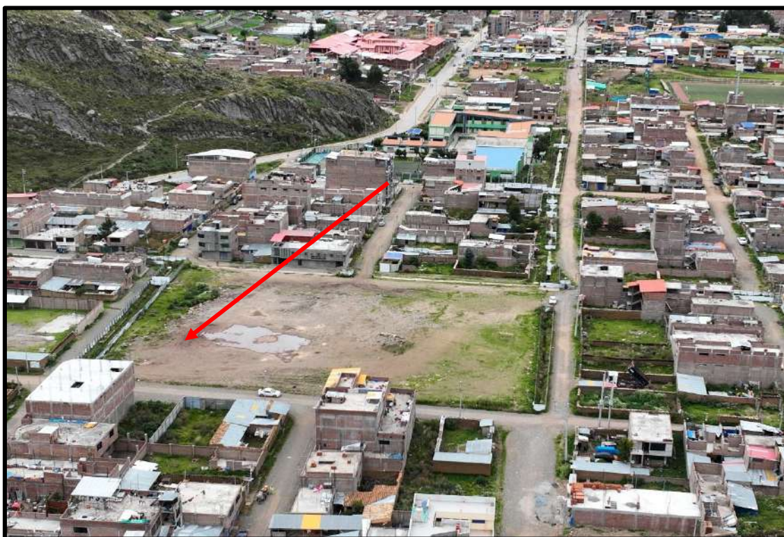
Fotografía N° 2: Vista panorámica de la ubicación de la zona de estudio.
