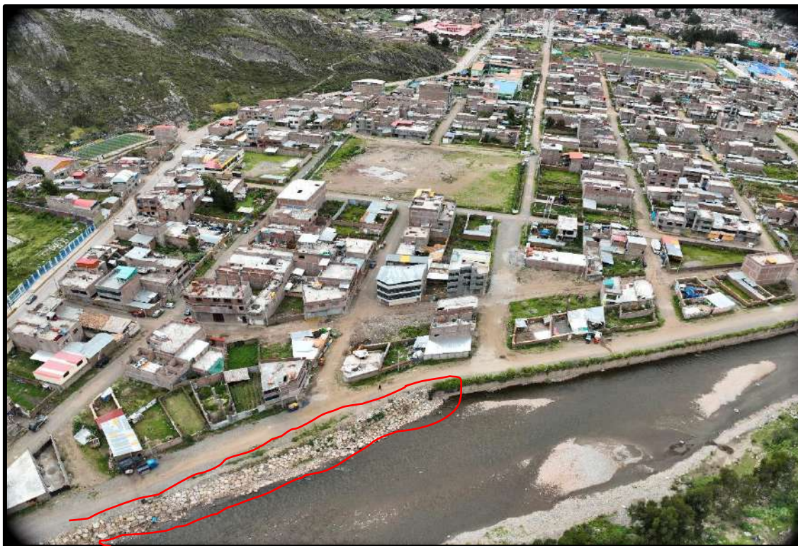
Fotografía N° 7: Se evidencia enrocado y muro de concreto armado para la protección, de desborde del rio ichu en temporadas de lluvias.
