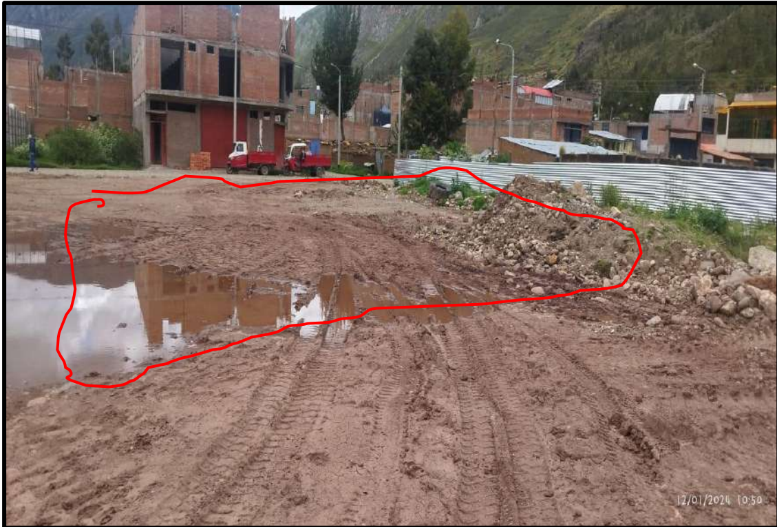
Fotografía N° 5: Acumulamiento de agua pluvial debido que el terreno se encuentra en una zona plana de poca pendiente.
