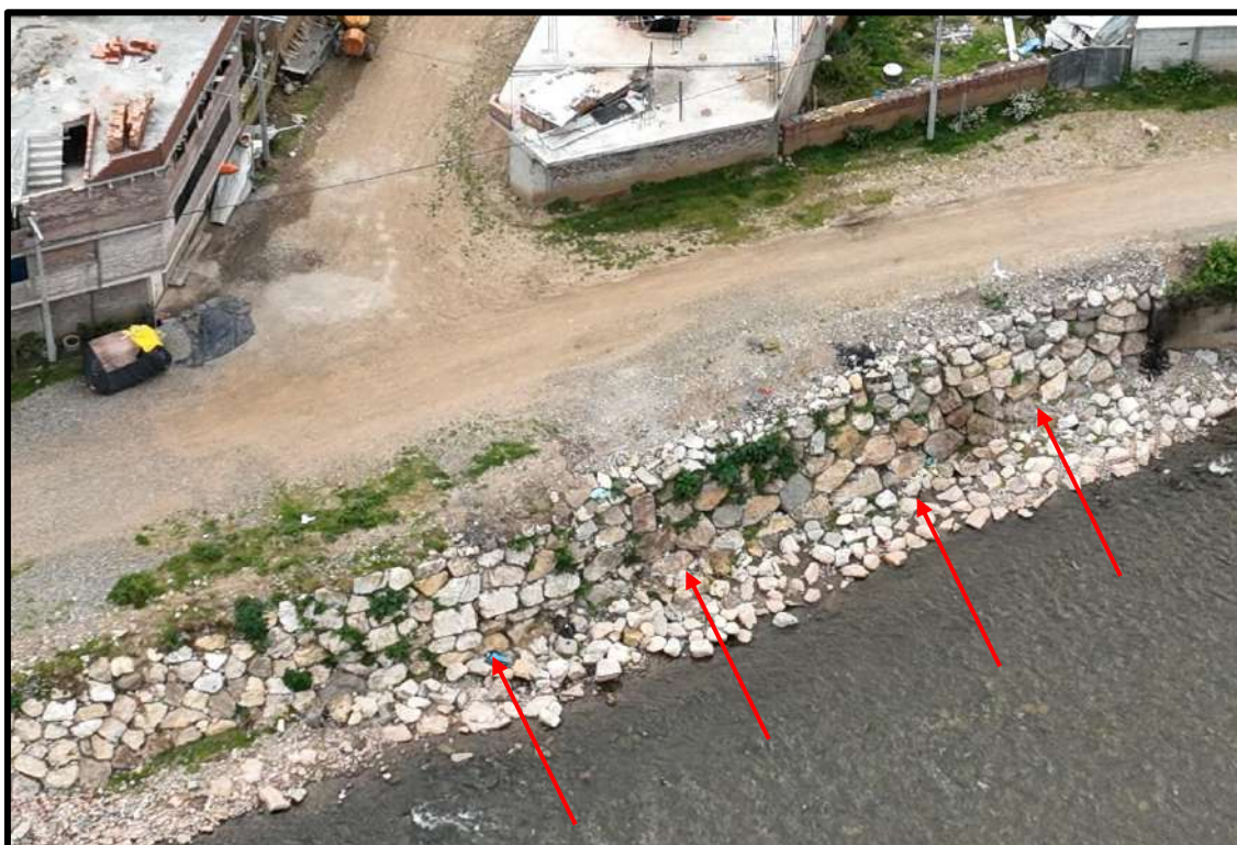
Fotografía N° 8: Se evidencia el enrocado en la margen del rio para la protección de un probable desborde del rio.
