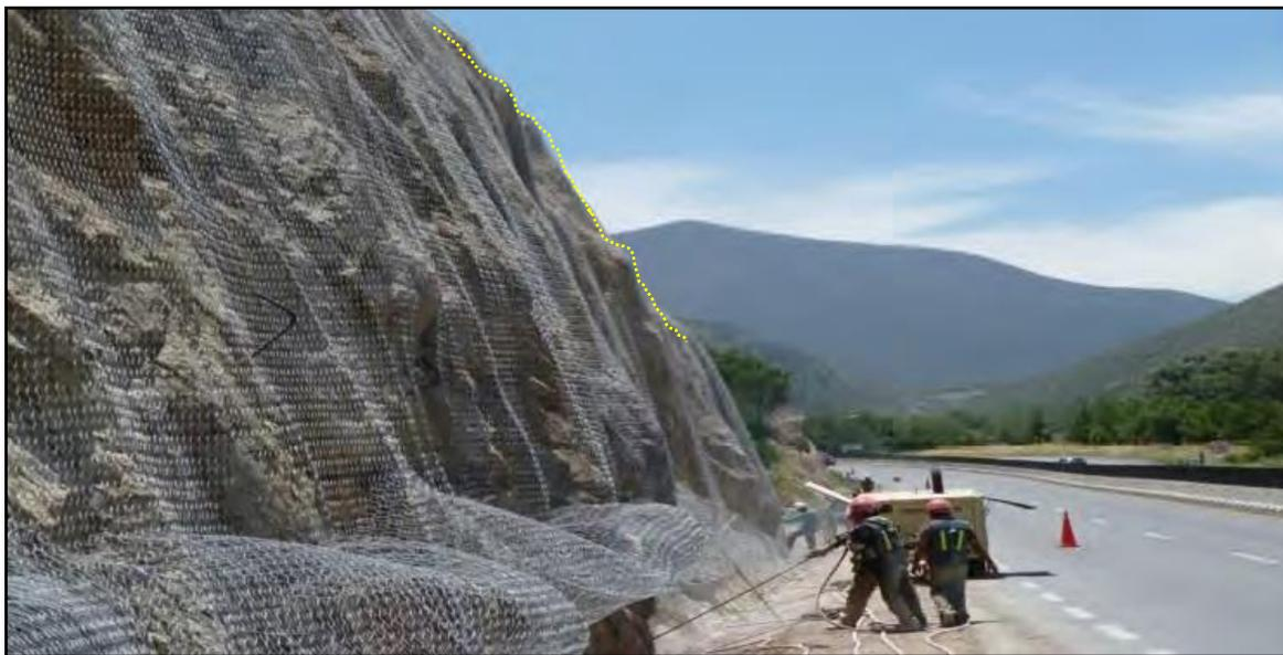
**Figura 18.** Mallas de protección con anclajes para caída de rocas o derrumbes tanto en detritos como roca alterada, (Vilchez, 2021)
