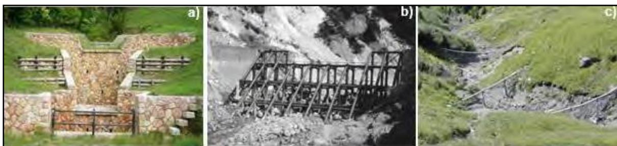
**Figura 20.** Presas tipo SABO de sedimentación escalonada para controlar la fuerza destructiva de los huacos, a) de control; b) tipo rejilla; c) barras flexibles, (Vilchez, 2021)
