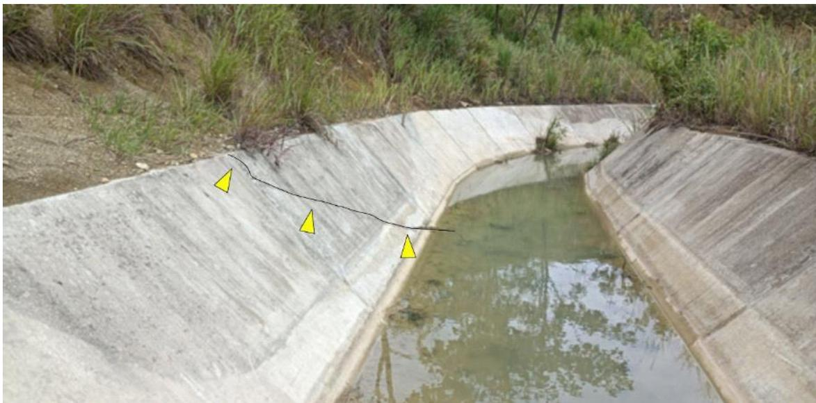
**Figura 24.** Canal de concreto con presencia de grietas en la parte alta de la zona evaluada.
