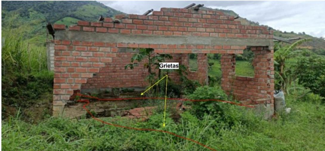
**Figura 15.** Vivienda ubicada en el cuerpo del deslizamiento DRA-1. Los desplazamientos afectaron las estructuras, además de un mal proceso constructivo.
