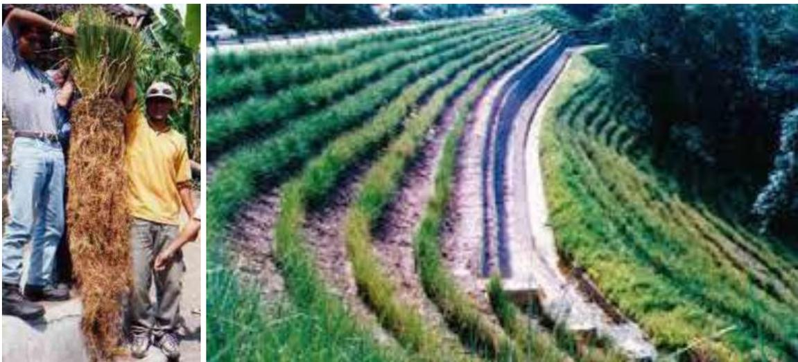
**Figura 26.** Ejemplo de bioingeniería con arbusto (vetiver) en taludes de materiales sueltos.
