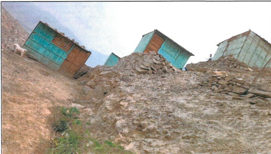
Foto 29: La colocación de rellenos sin compactación o compactados inadecuadamente permiten la sobrecarga de las laderas y la saturación y colapso de los suelos sueltos, facilitando los escurrimientos de suelo, flujo de los suelos sueltos saturados, y formación de cárcavas por erosión
