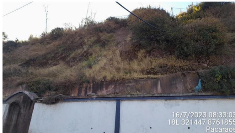
Terraza coluvio – aluvial identificada en el extremo sureste del poblado Santa Cruz de Andamarca
