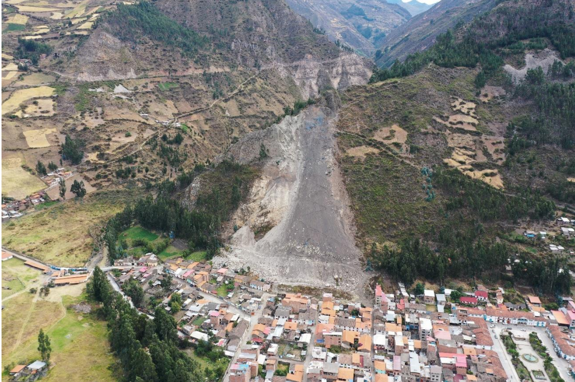
Fotografía 1. Vista panorámica del estado actual del derrumbe del cerro Shallapa.
