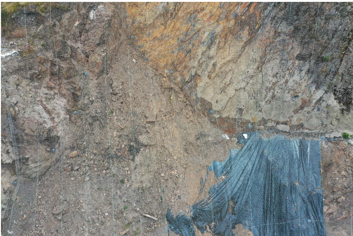
Fotografía 4. Vista de la malla y pernos de anclaje.
