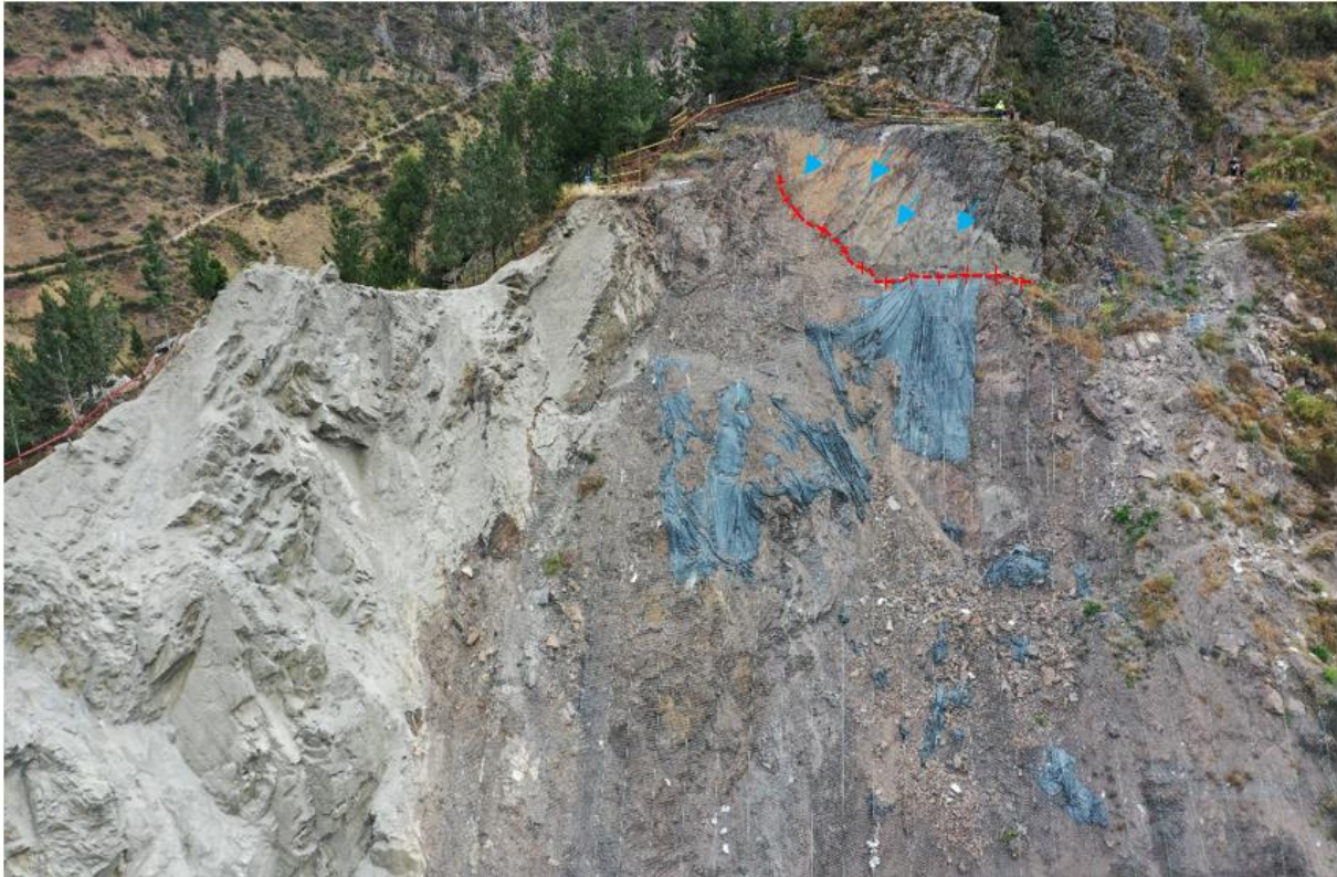
Figura 5. Tendido de mallas, Shotcrete y pernos de anclaje en la ladera del cerro Shallapa con medida estructural a corto-mediano plazo. Líneas rojas: Representa el agrietamiento en contacto de suelo y roca. Líneas celestes: Representa la escorrentía pluvial que discurre directamente hacia la grieta.
