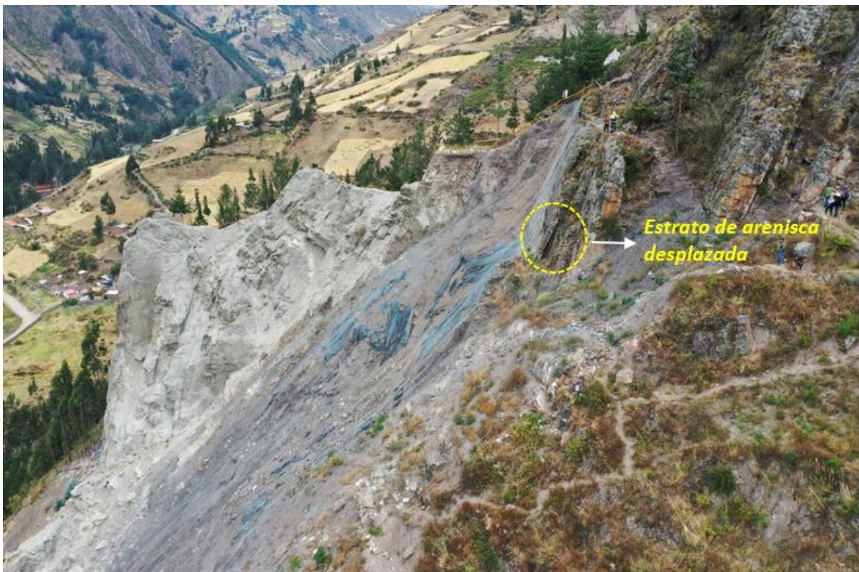
Figura 4. Estrato de arenisca desplazada a favor de la pendiente, con muchas probabilidades de colapsar.
