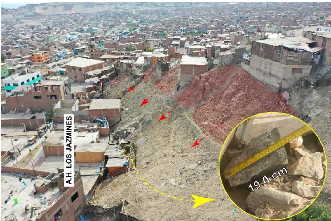
Figura 6. Vista de ladera colindante al A.H. Los Jazmines, mostrando varios bloques de roca, sueltos e inestables susceptible a desprenderse pendiente abajo. En flechas entre cortadas rojas se muestra la dirección de caída preferente. Así mismo; se señala en color amarillo, la ubicación y el tamaño de las rocas caídas, reportados por la población.
