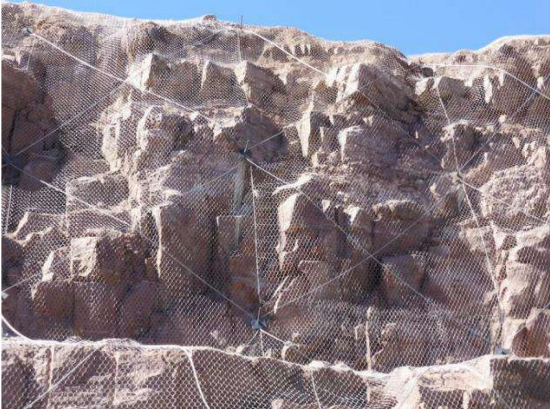
Figura 31. Control de caída de rocas utilizando mallas ancladas.
