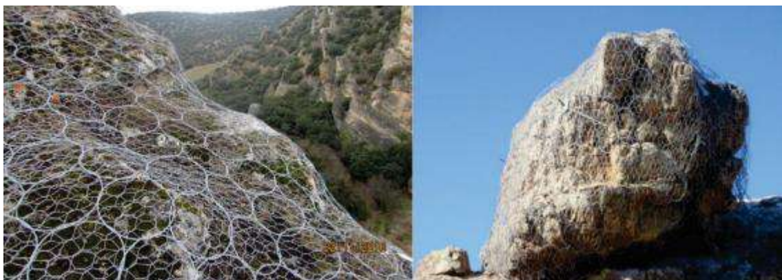
Figura 33. Ejemplos de estabilización con red de anillos
