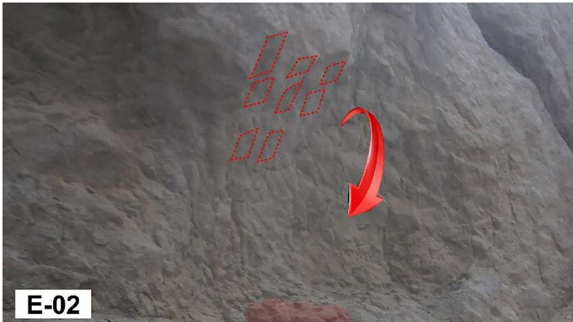
Figura 16. Vista de la estación geomecánica E-02, con evidencias de roturas por volcamiento; además se muestra su dirección de caída (señala con flecha roja). Coordenadas referenciales UTM WGS-84, 18S: E: 269357; N: 8688676.
