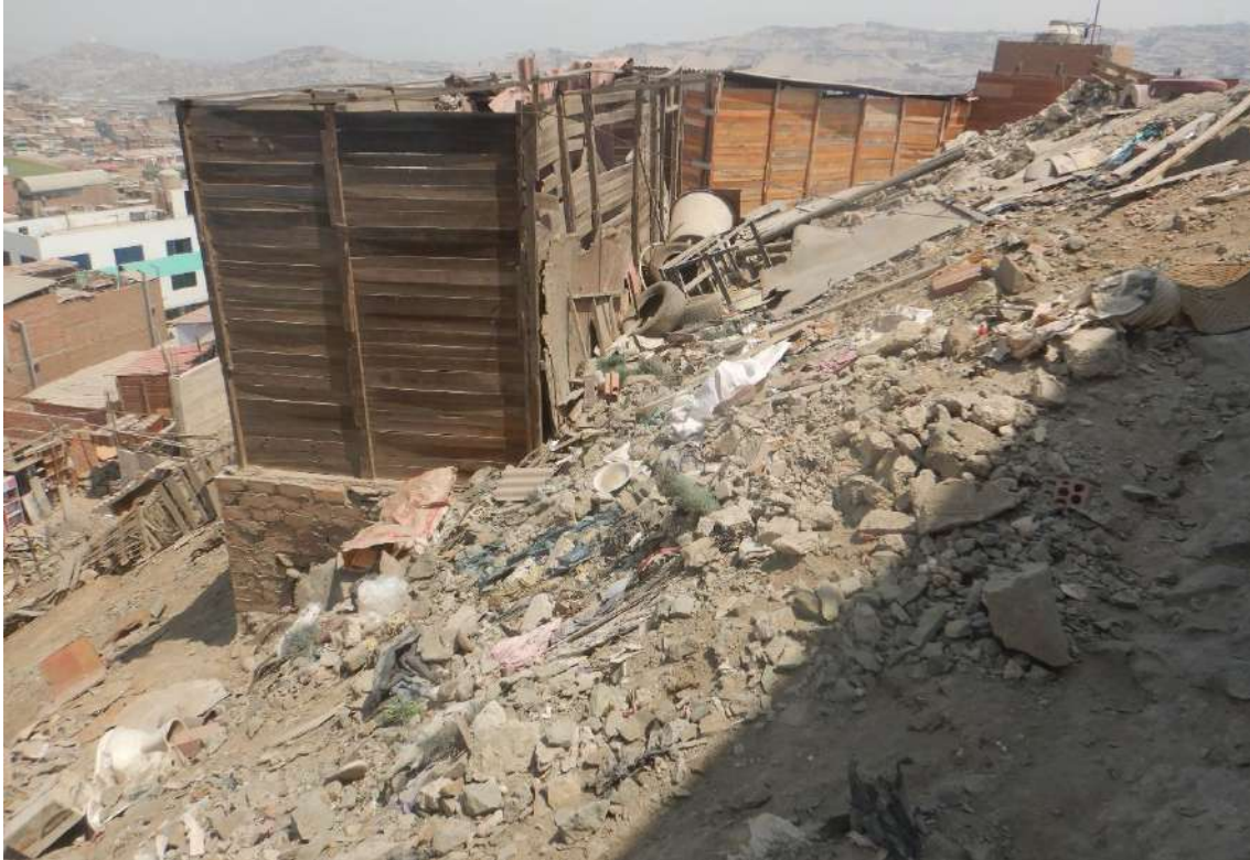
Fotografía 5. Botaderos de desmonte relacionados a cortes de talud, lo que condiciona bloques de roca aislados e inestables susceptible a desprenderse ladera abajo. Coordenadas referenciales UTM WGS-84, 18S: E: 269333; N: 8688678.
