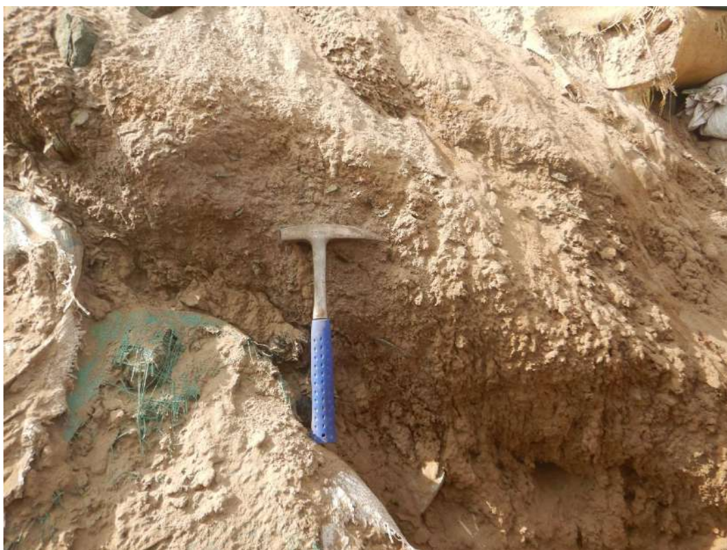
Fotografía 2. Vista de depósito eólico (Q-eo) conformado por arenas inconsolidados de grano medio a fino, acumuladas al pie de la ladera. Se caracteriza por ser de compacidad suelta a muy suelta y poco cohesivos. Coordenadas referenciales UTM WGS-84, 18S: E: 269360; N: 8688663.
