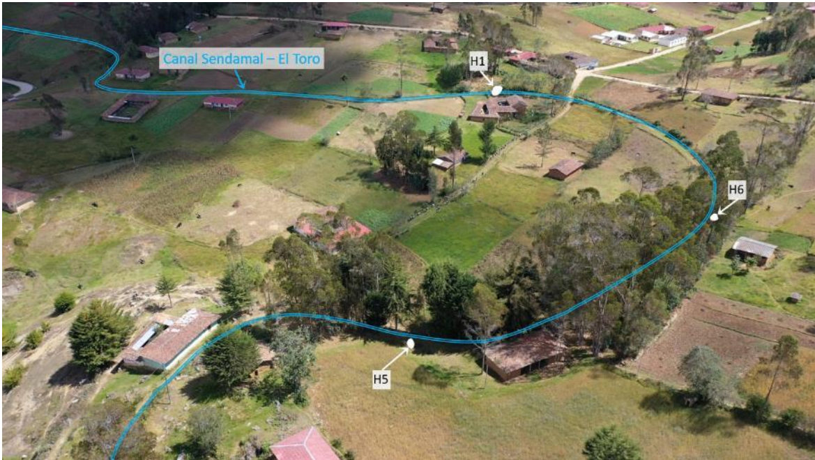
Figura 15. Hundimientos (H1, H5 y H6), se presentan a lo largo del canal de conducción de agua para riego (líneas celestes), Sendamal – El Toro.
