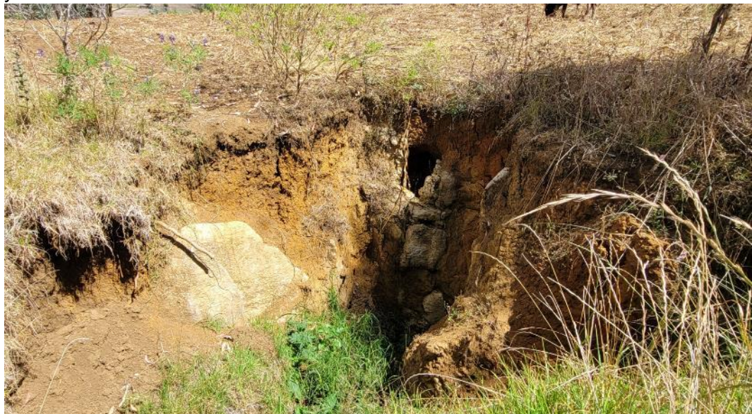
Fotografía 2. Se observa los depósito coluvio-deluvial, conformados por bloques y gravas en matriz limo arcillosa. Coordenadas UTM, WGS-84, 17S. Norte: 9239950 y Este: 809827.
