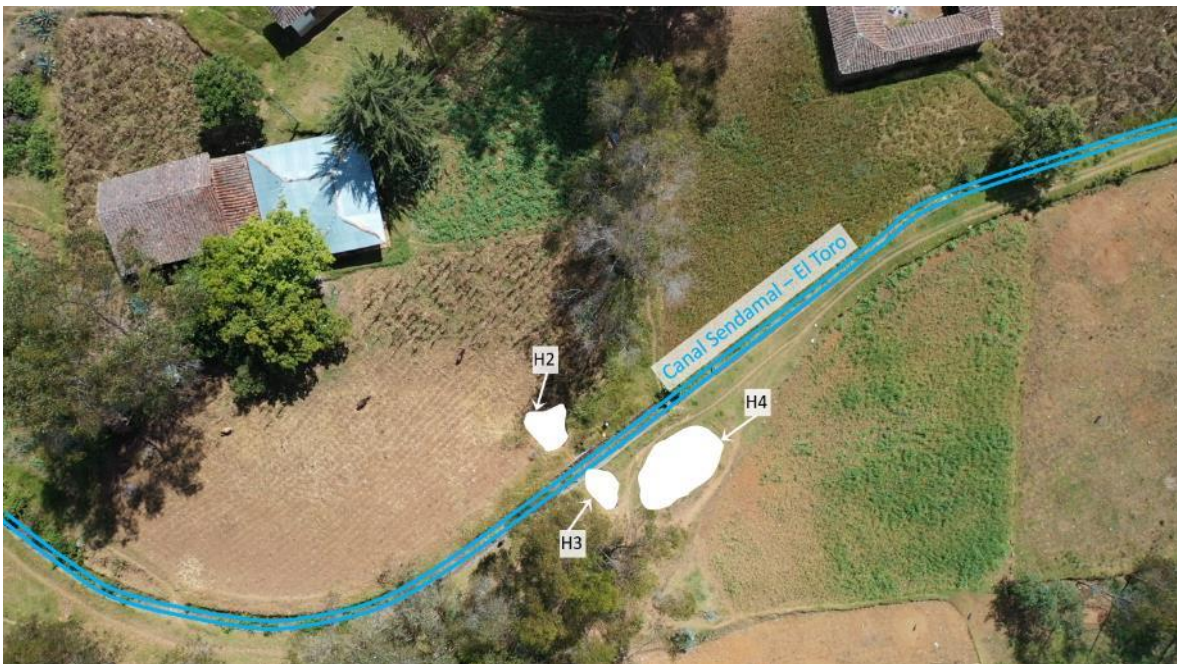
Figura 16. Hundimientos (H2, H3 y H4), afectan canal de conducción de agua para riego (líneas celestes), Sendamal – El Toro; además se ubican a 20 metros de las viviendas de los pobladores.
