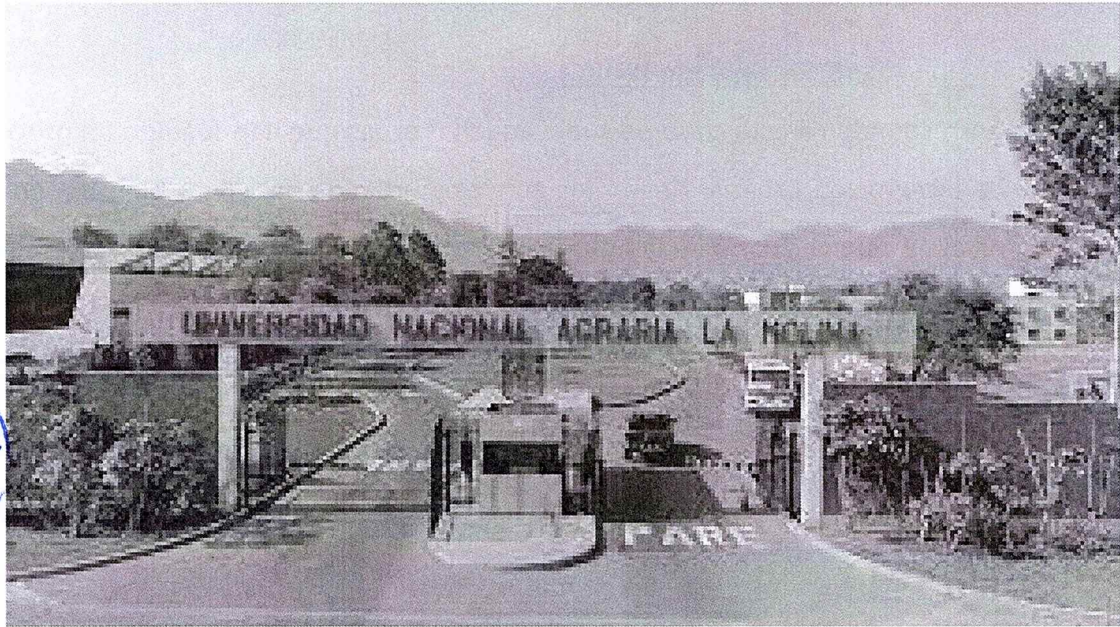
Figura N° 3: Vista Frontal de la Sede La Molina
