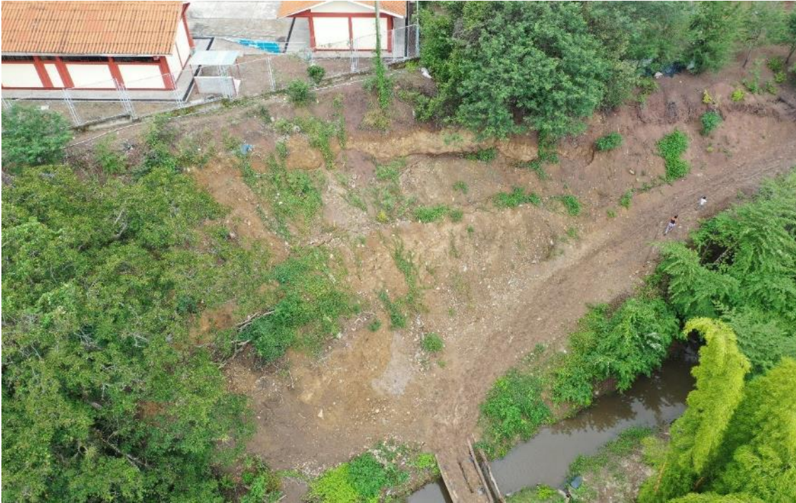
Fotografía 4. Se observa la ladera con escasa vegetación y sin sistema para drenar agua de escorrentía originada por precipitación pluvial.
