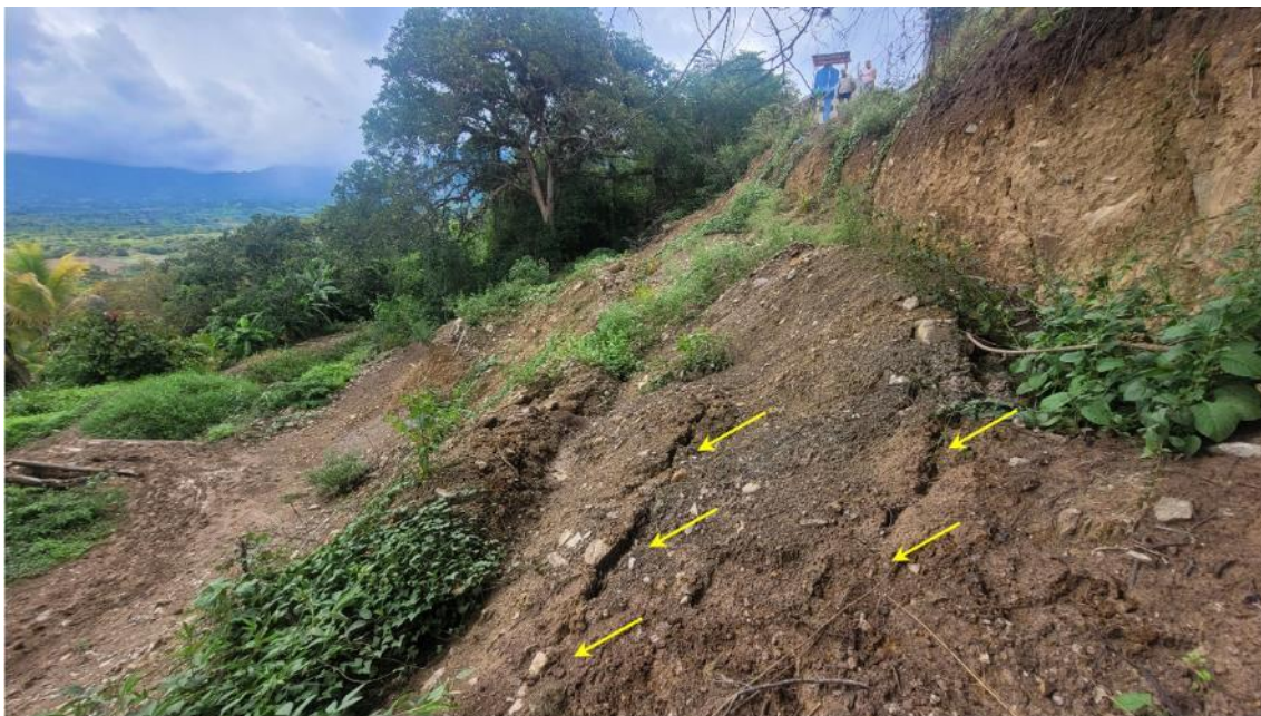
Figura 9. Agrietamientos paralelos al escarpe principal del deslizamiento activo.
