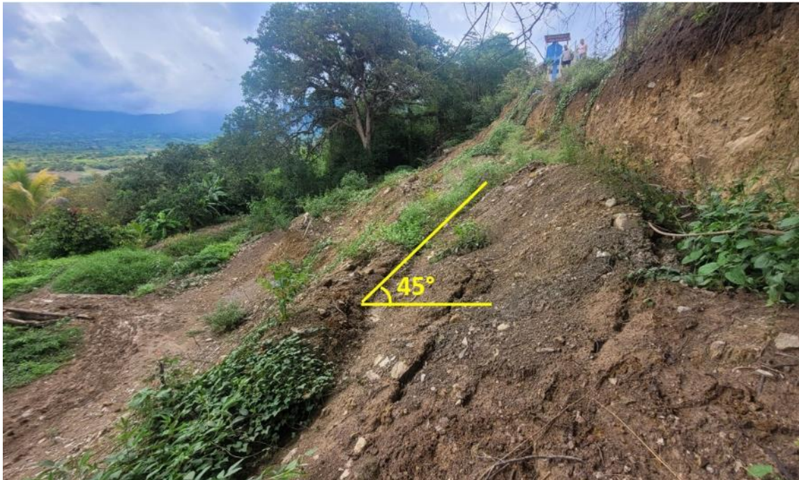
Figura 3. Deslizamiento se origina en laderas con pendiente muy fuerte (25° a 45°).
