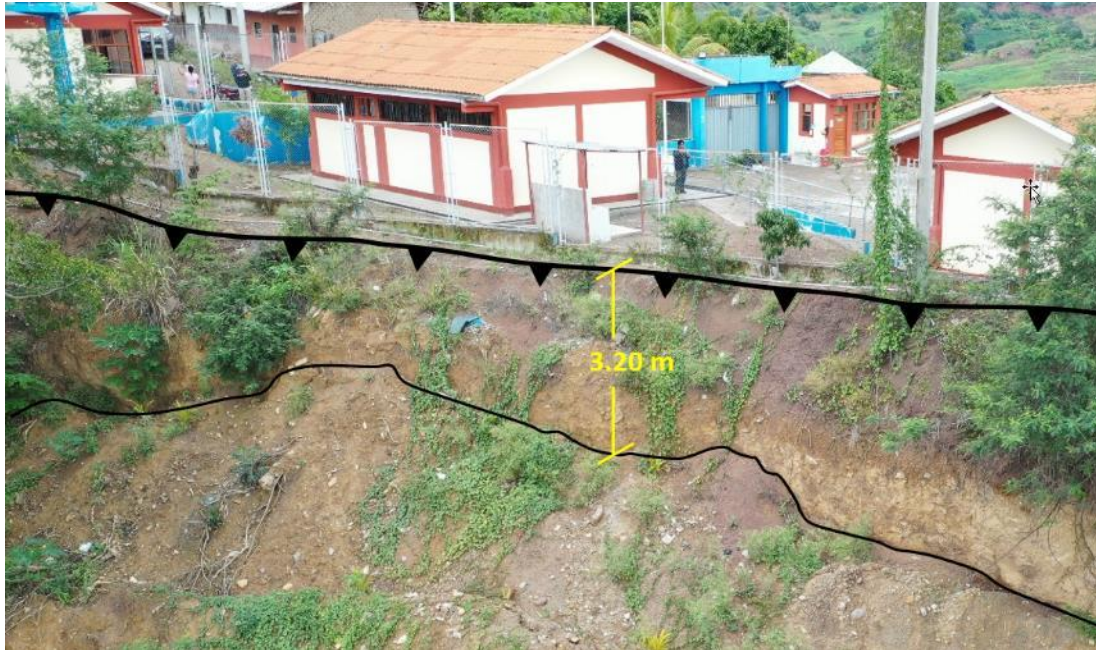
Figura 8. Acercamiento del escarpe principal del deslizamiento ubicado a pocos metros de la Institución Educativa N° 17301.
