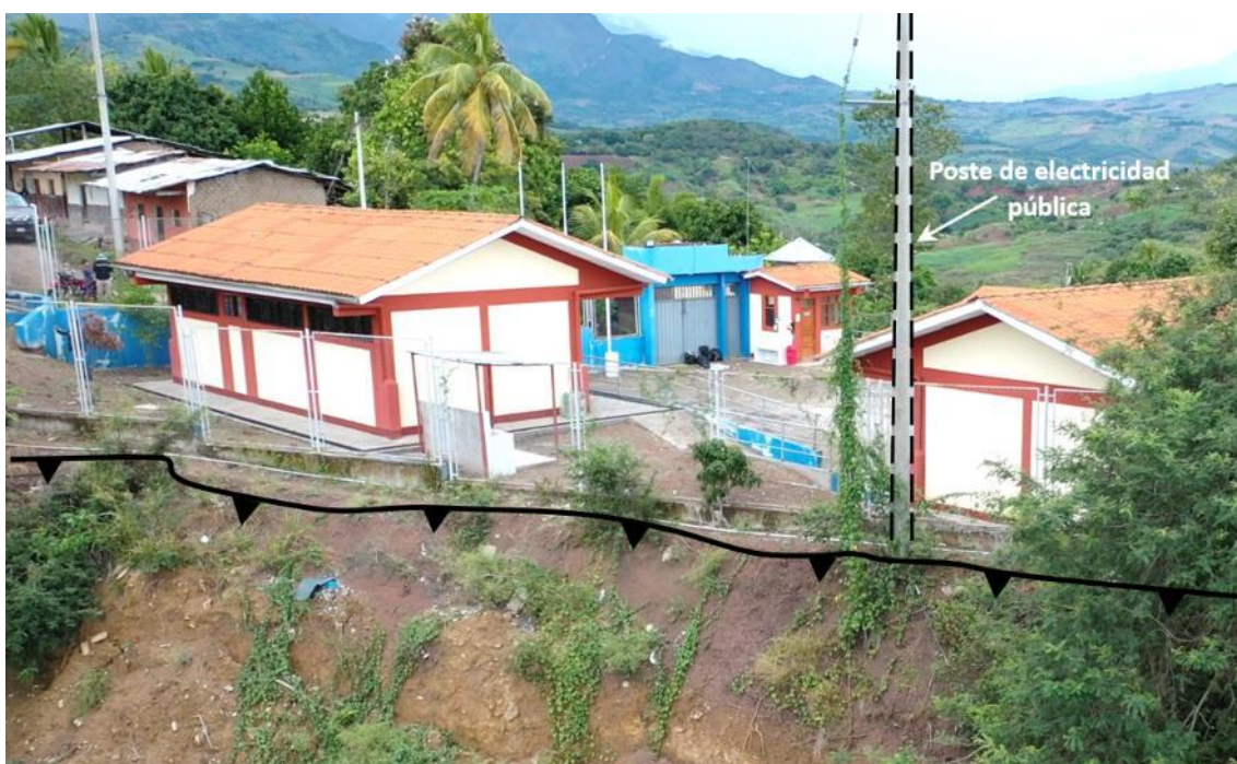
Figura 13. Poste de conducción de tendido eléctrico e institución educativa expuestos al peligro por deslizamiento.
