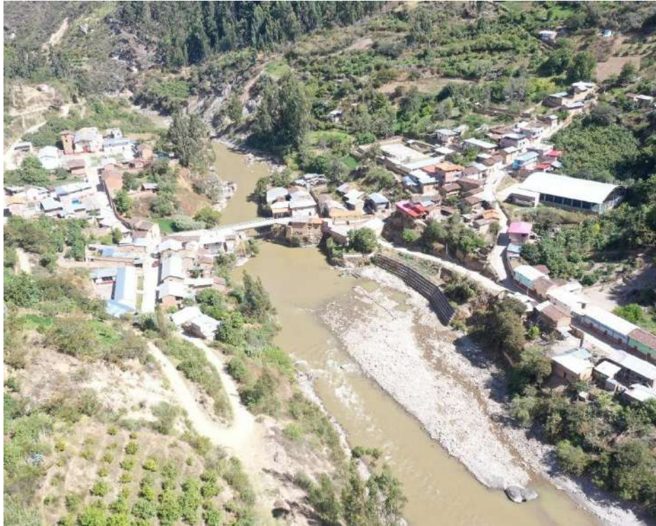
Fotografía 1. Población del centro poblado Chuquibamba ubicada entre los distritos de Punchao y Chavín de Pariarca, ubicado a 7.38 km del derrumbe del 13 de junio 2024. UTM: 303576 / 8953993, Zona 18.
