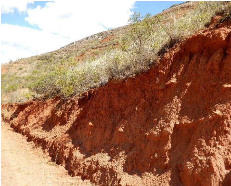
Fotografía 5. Depósito deluvial ubicado en el talud superior del lugar donde ocurrió derrumbe que represó el río Marañón.
