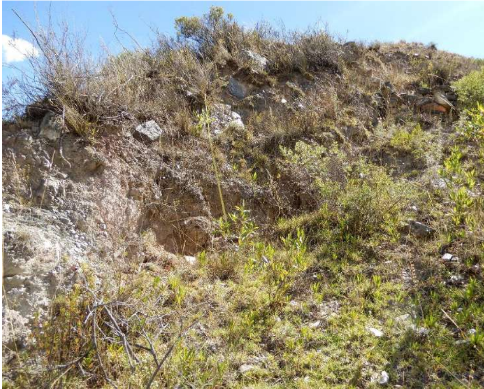
Fotografía 12. Escarpa de deslizamiento confinado ubicado a 500 m de la escarpa principal del derrumbe UTM: 303760 / 8961059, Zona 18.
