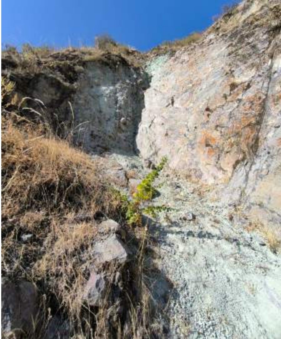
Fotografía 28. Derrumbes en la parte alta de la ladera (afloramiento rocoso volcánico), condicionado por el grado de fracturamiento y meteorización de la roca.
