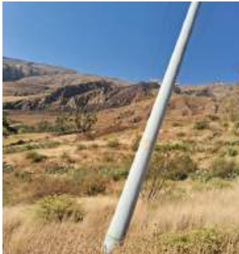
Fotografía 24. Muestra inclinación en postes, en dirección del movimiento del deslizamiento Dr-a5, activo.
