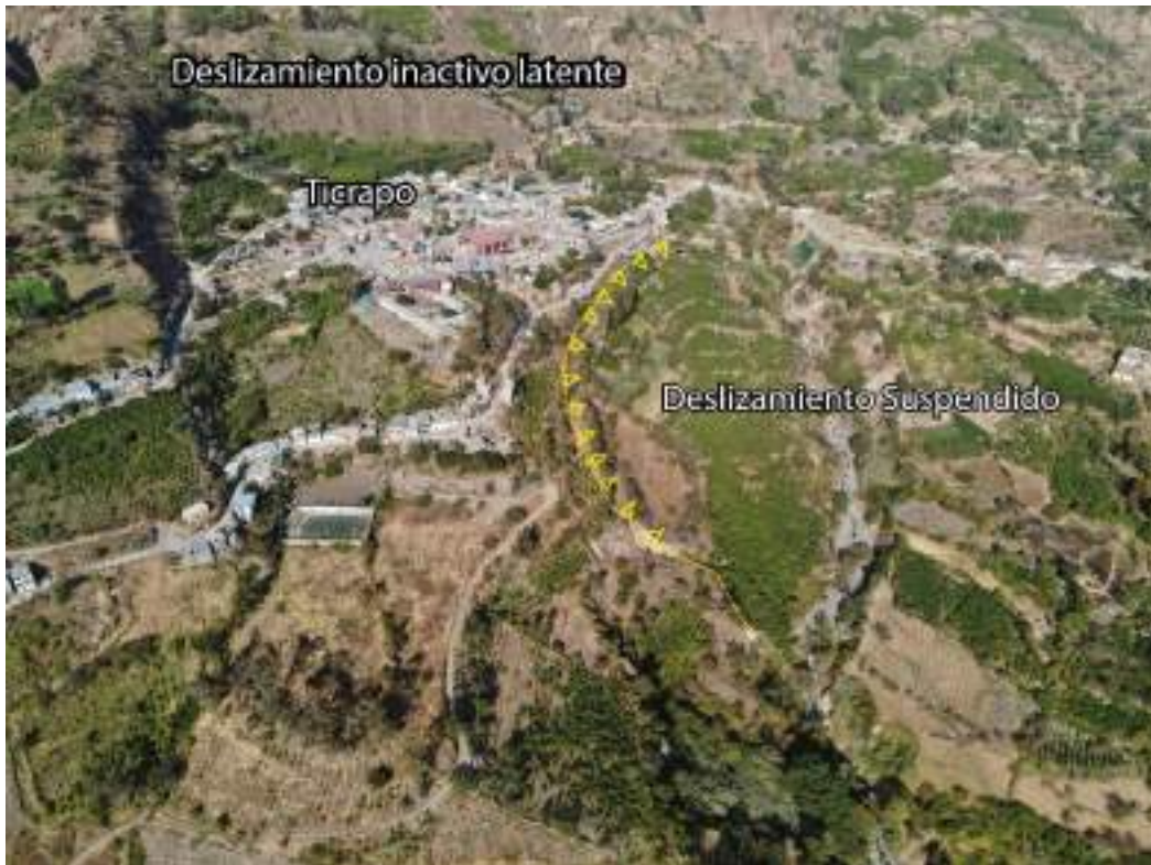
Figura 13. Deslizamiento suspendido más representativo en el sector Ticrapo.
