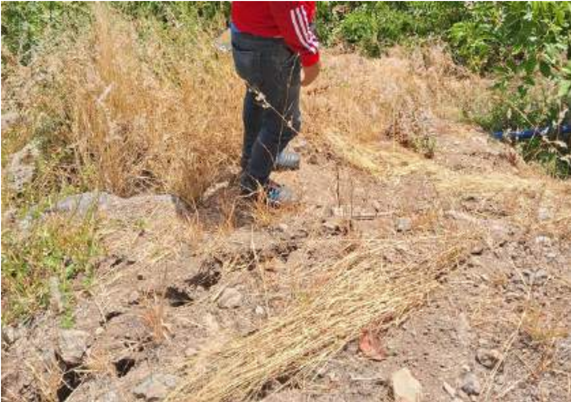
Fotografía 13. Grietas tensionales en el cuerpo del deslizamiento Dr-a2.
