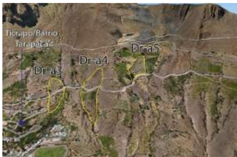
Figura 19. Muestra el deslizamiento Dr-a5, activo.
