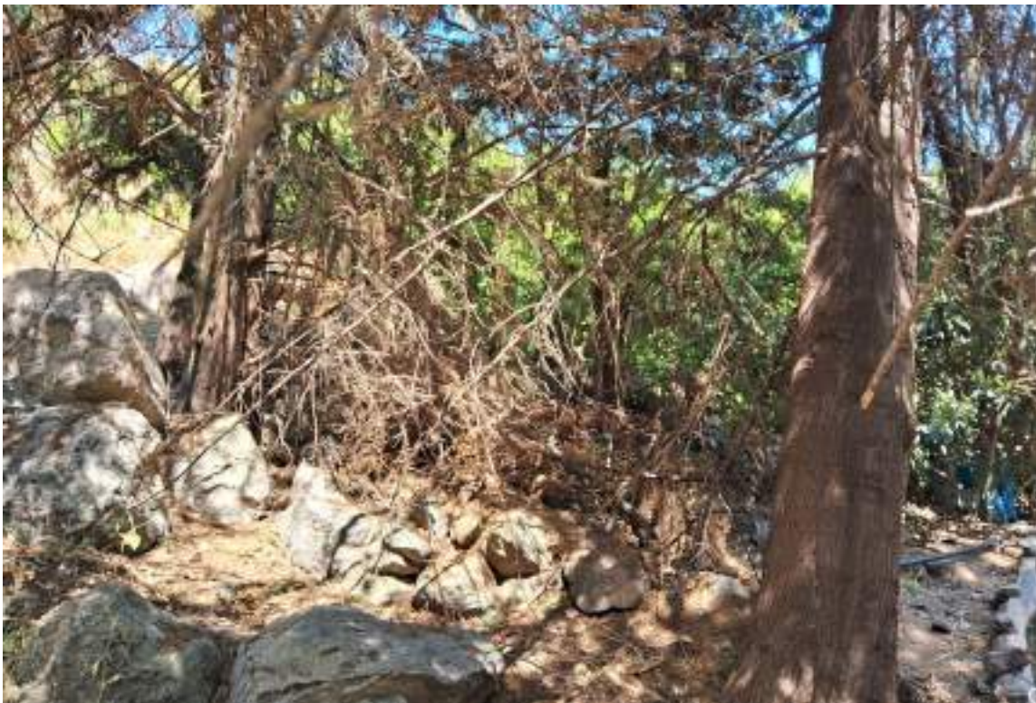
Fotografía 19. Árboles inclinados por encima del deslizamiento Dr-a3.
