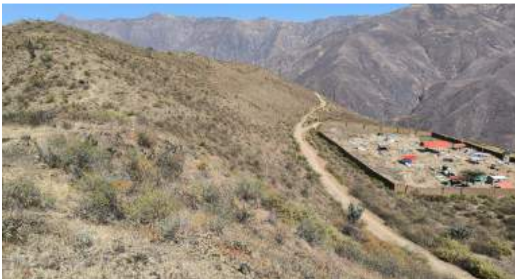
Fotografía 26. Zona superior al deslizamiento Dr-a6, muestra el cementerio de Cebadilla uno de los principales lugares afectados.
