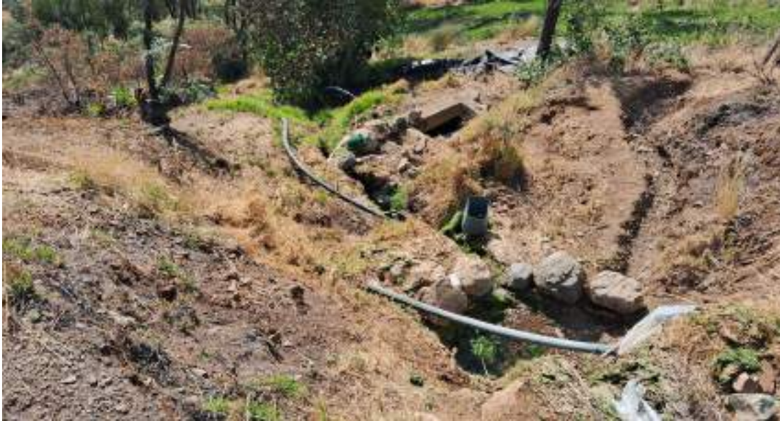
Fotografía 18. Canales de riego secundarios sin impermeabilizar derivados del canal principal.
