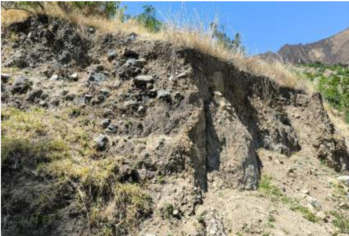
Fotografía 5: Depósitos coluvio-deluviales en la ladera oeste de Ticrapo. Coordenas WGS 84, 18s, X: 453225, Y: 8519879.
