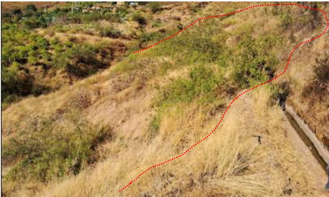
Figura 17. Escarpe principal de deslizamiento Dr-a3 cuál es el escarpe, muestra canales de riego can falta de mantenimiento en la parte superior.
