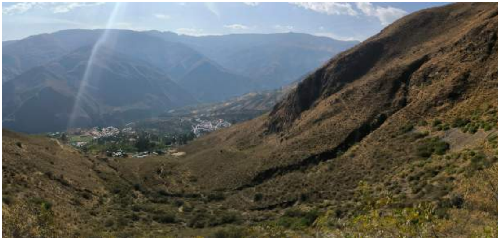
Fotografía 30. Erosión en cárcavas en la parte media y alta de la ladera.
