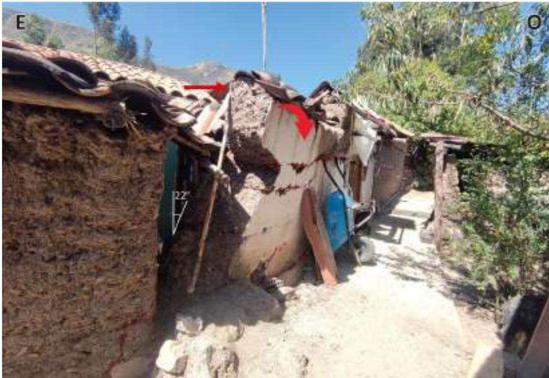
**Figura 5.19.** Muro afectado, con inclinación de  $\sim 22^\circ$  hacia el oeste. Este muro se encuentra en inminente colapso.
