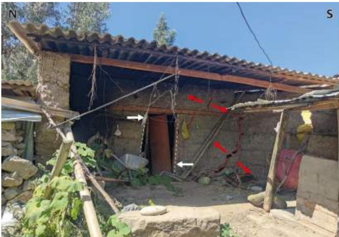
**Figura 5.18.** Vivienda afectada, presenta las paredes agrietadas (líneas y flechas blancas). Las líneas blancas señalan la deformación en la puerta de la vivienda producto del movimiento del terreno.
