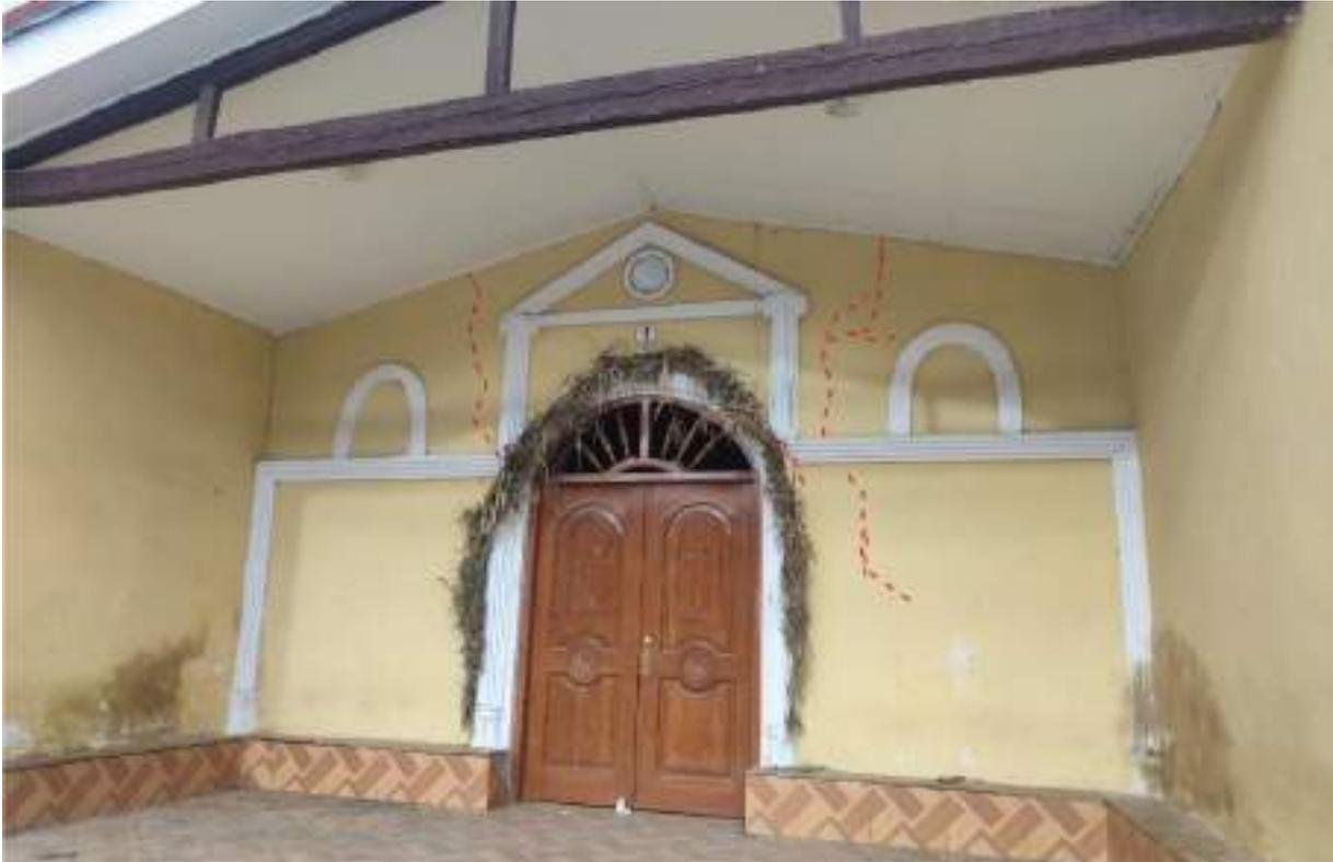
**Figura 5.8.** Grietas en los muros de la iglesia de Chuyo (Líneas rojas punteadas). Coordenadas UTM WGS84, Zona 18L, 262668, 8941204.
