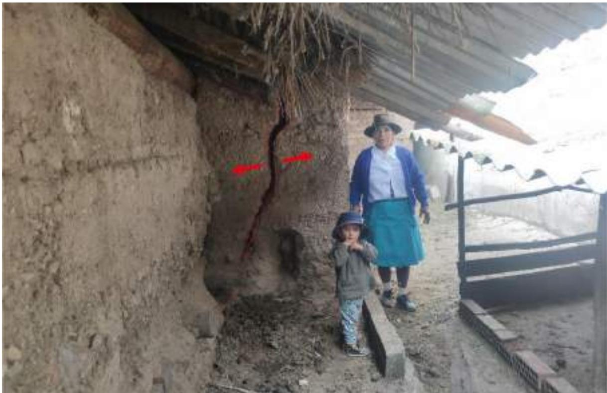
**Figura 5.7.** Grieta en viviendas, con movimiento hacia el Oeste, Sector Chuyo. Coordenadas UTM 262620, 8941220.
