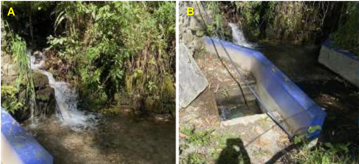
**Figura 7.4.** A y B) Captación de agua con concreto, presenta una captación con tuberías destinadas para riego tecnificado, con un caudal aproximado de 16 l/s, quebrada Raqra, código 498996-015.
