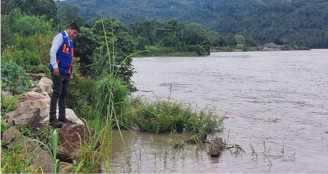
FIGURA N°02: VISTA FOTOGRAFICA DEL CAUDAL DEL RIO APURIMAC A INICIOS DE TEMPORADA DE LLUVIA EN LA ZONA, EN LA QUE SE OBSERVA QUE EL CAUDAL YA ALCANZA A LA CORONA DE LOS DIQUES PROVISIONALES, POR LO QUE EN LOS MESES DE MAXIMA AVENIDA SON AFECTADOS Y EXPUESTOS AREAS AGRICOLAS Y VIIVENDAS.
