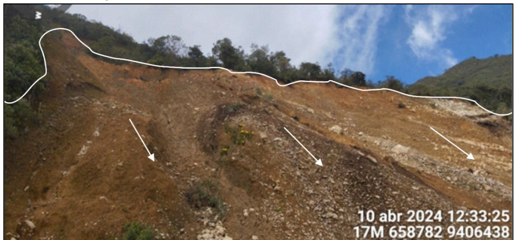
Figura 36. Vista frontal del escarpe principal del deslizamiento.
