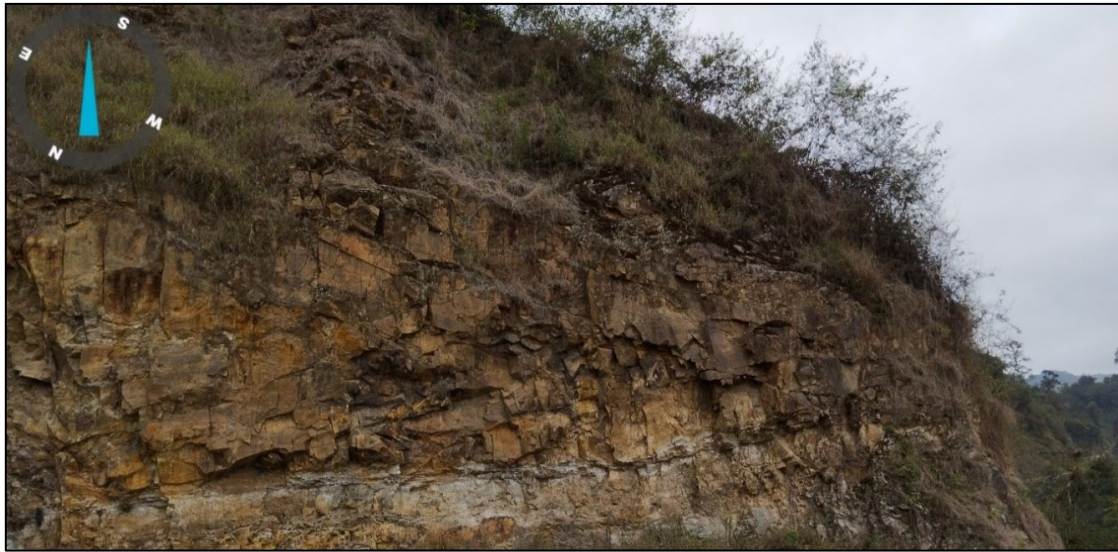
Figura 46. Talud vertical con afloramientos muy fracturados.
