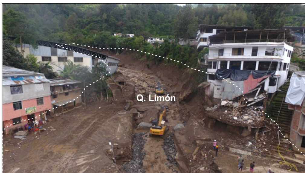
Figura 42. Vista aguas abajo del cauce de la quebrada El Limón.
