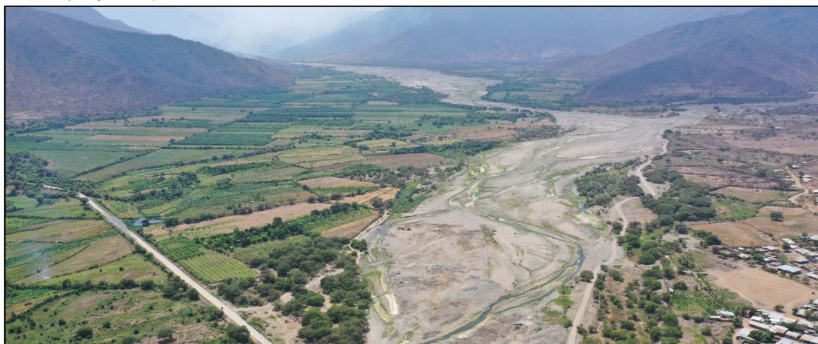
Figura 48. Zona de derrumbes en las inmediaciones del caserío Silia.
