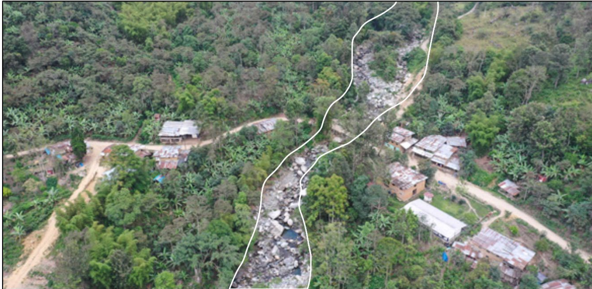
Figura 43. Vista hacia la quebrada Coyona donde ocurren flujos de detritos y lodos en temporada de lluvias.
