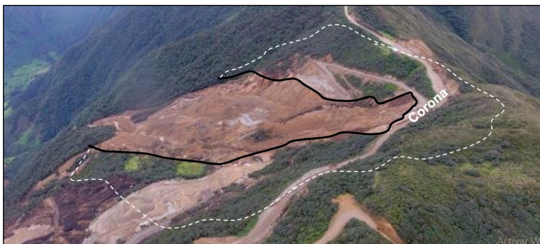
Figura 31. Vista de sur a norte de la corona parte superior del escarpe del material deslizado.
