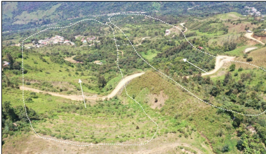
Figura 26. Vista hacia el caserío Palambra ubicado sobre un antiguo deslizamiento.
