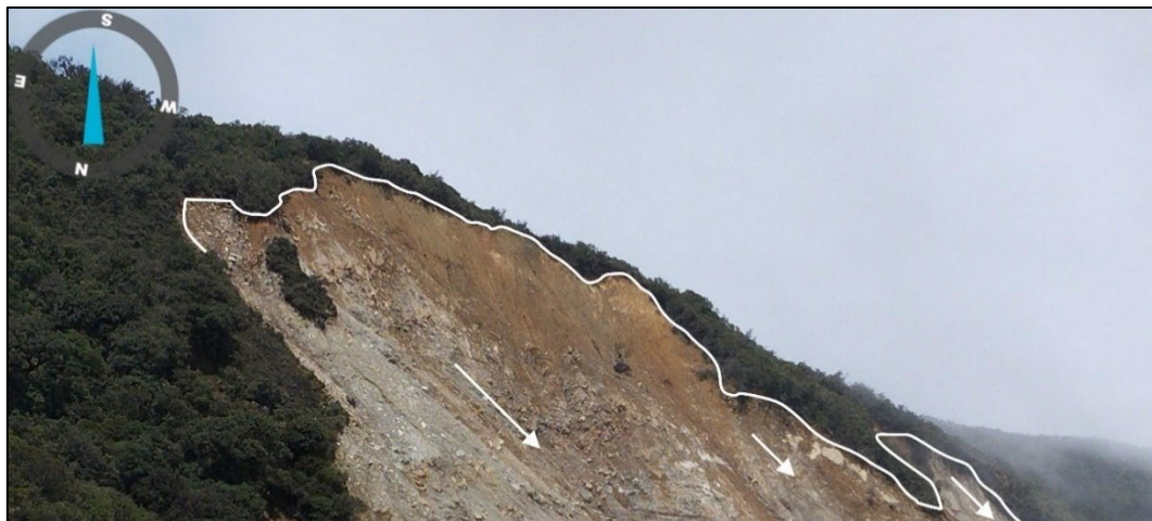
Figura 35. Vista frontal del escarpe principal del deslizamiento.
