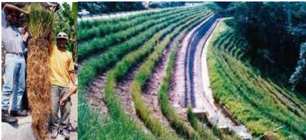
Fotografía 6. Ejemplo de bioingeniería con arbusto (vetiver) en taludes de materiales
