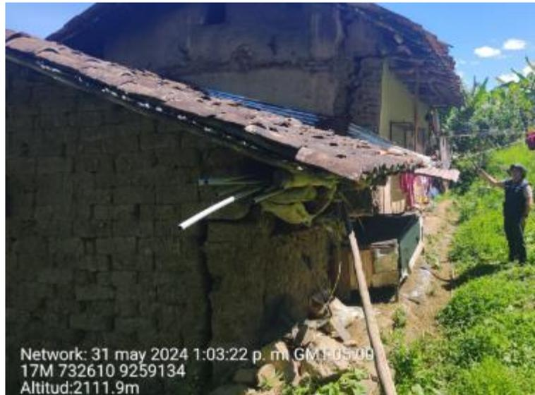
**Fotografía 3.** Agrietamientos en una vivienda, parte del cuerpo del deslizamiento DRR2.
