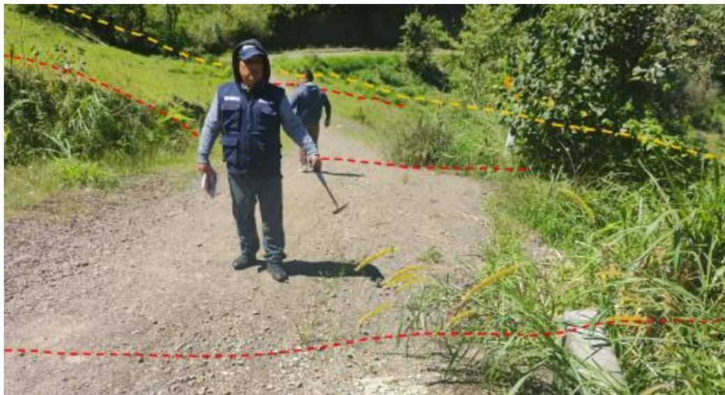
**Figura 13.** Agrietamientos y subsidencias del terreno que afectan a vía vecinal (deslizamiento rotacional reactivado 2). Ubicación: E: 732637; N: 9258802; Z: 2070.
