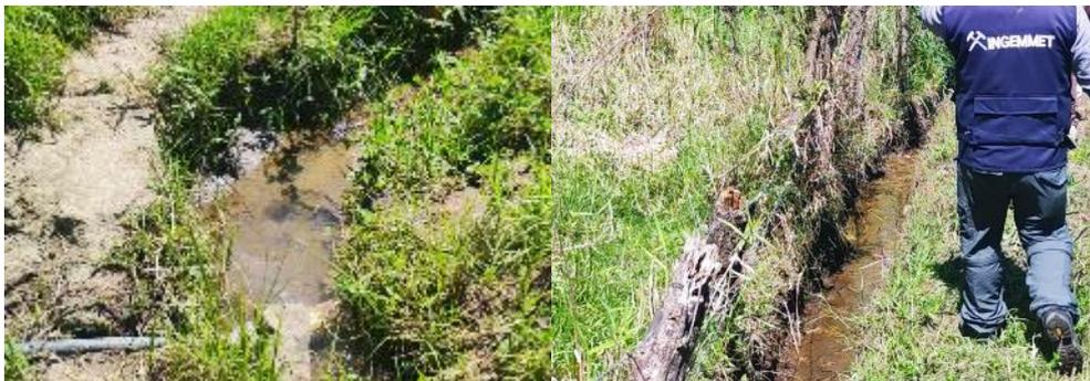
**Fotografía 6.** Canales sin revestimiento dentro del cuerpo del deslizamiento DRR2.
