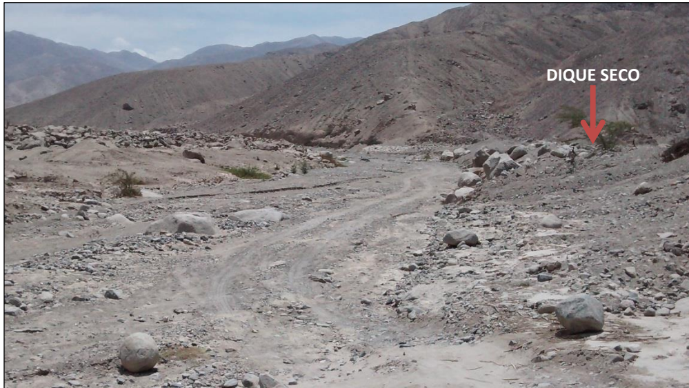
FOTO N° 1: DIQUE SECO DE MATERIAL ARRIMADO
