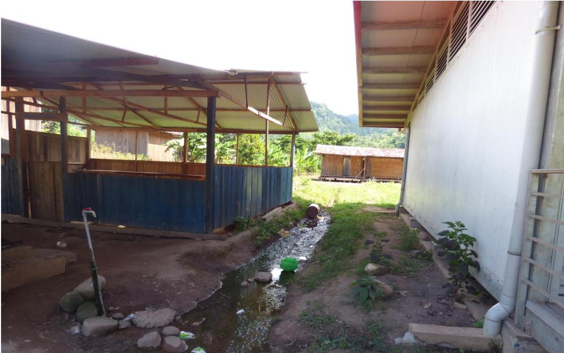
**Fotografía 6:** Escorrentía de aguas a través de las viviendas de Platanillo Shimaki, por la ausencia de drenajes
