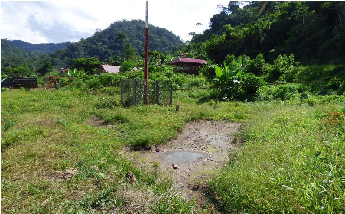
**Fotografía 5:** Zonas de alta saturación de aguas por filtraciones y manantes en la terraza baja de Platanillos Shimaki, con ausencia de canales de drenaje.
