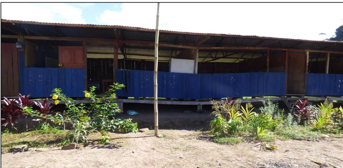
**Fotografía 3:** Cimientos de madera del colegio de Platanillo Shimaki afectado por la humedad del terreno.
