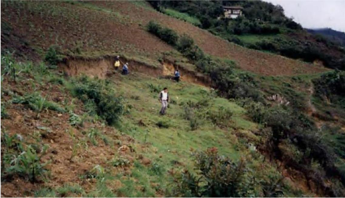
**Fotografía 3.** Zona de arranque del deslizamiento ubicado en los taludes superiores al campo deportivo, se observan escarpas verticales (corona).
