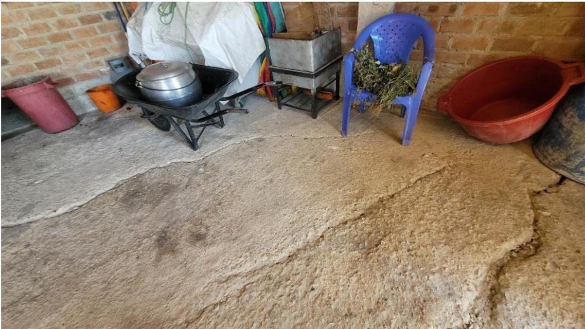
**Fotografía 4.** Agrietamiento en el piso de vivienda a consecuencia de la reptación de suelos.
