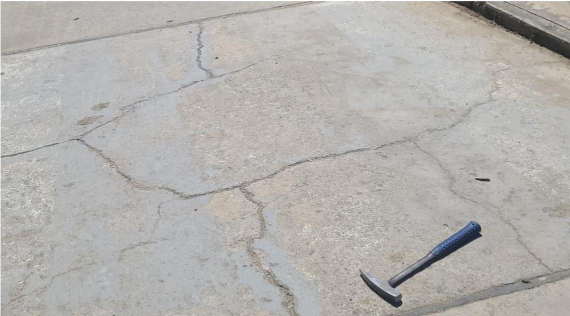
**Fotografía 6.** Grietas en pavimento de concreto.
