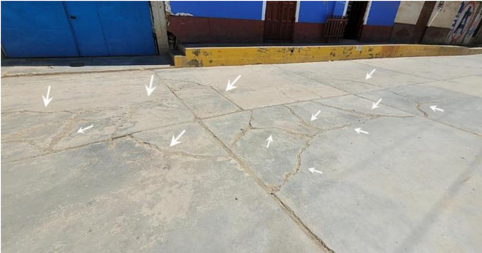
**Figura 18.** Grietas con diferentes direcciones, en la vía de concreto
