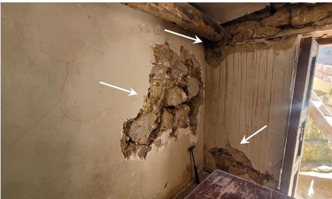
**Figura 16.** Pared en interior de vivienda, agrietada y deteriorada por empuje de masa deslizada.
