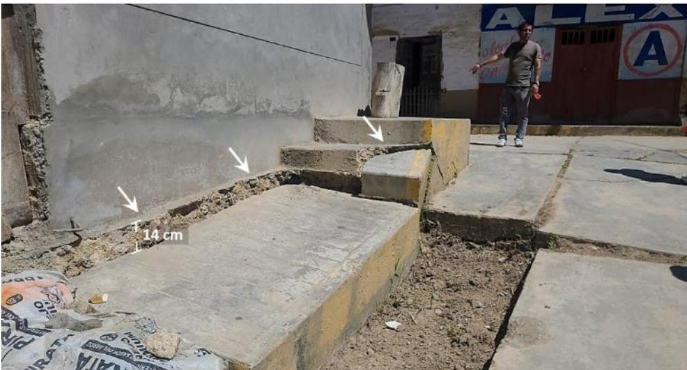
**Figura 19.** Vereda en mal estado, presenta grietas y desplazamiento vertical.
