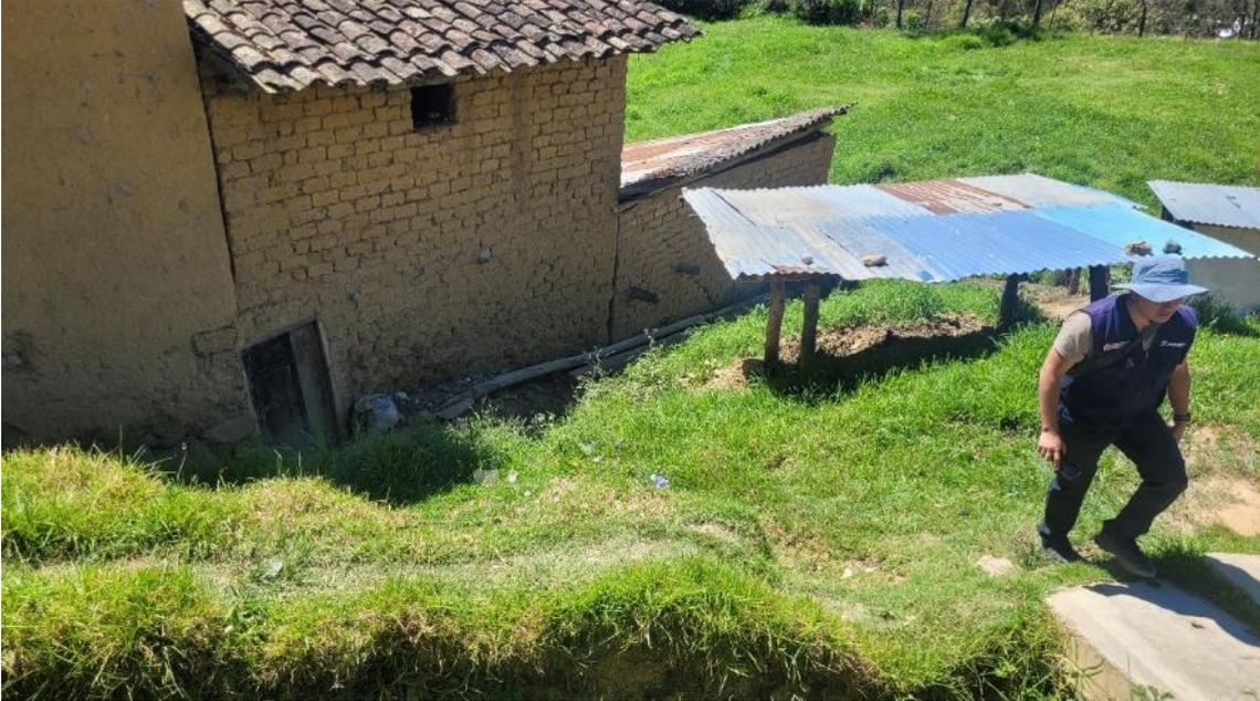
**Fotografía 5.** Separación de paredes de vivienda a consecuencia de la reptación de suelos.
