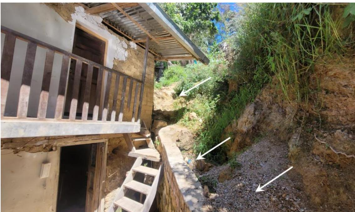
**Figura 15.** Material deslizado en dirección de vivienda.
