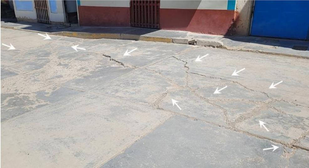
**Figura 17.** Grietas con diferentes direcciones, en la vía de concreto
