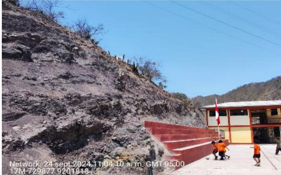
**Fotografía 1.** Corte de talud donde en la Institución Educativa N° 82555, donde se aprecian secuencias de lavas andesíticas muy fracturadas y altamente meteorizadas.
