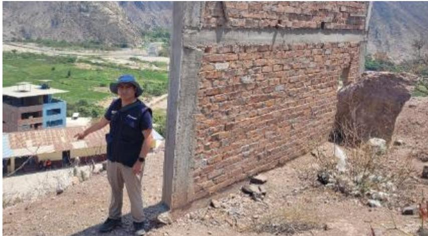
**Fotografía 7.** Muro de retención afectado por una caída de rocas reciente. Ubicación: E 729858 y N 9201780.
