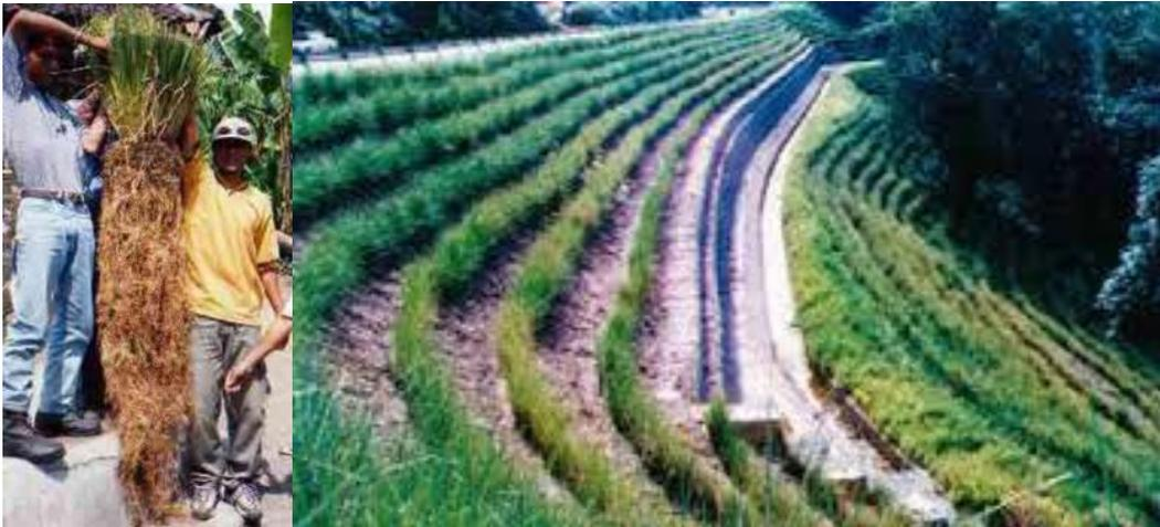
**Fotografía 8.** Ejemplo de bioingeniería con arbusto (vetiver) en taludes de materiales
